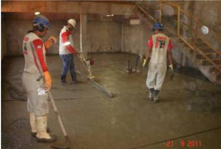
Execução de piso em alta resistência na sala destinada aos motoristas, no subsolo.
