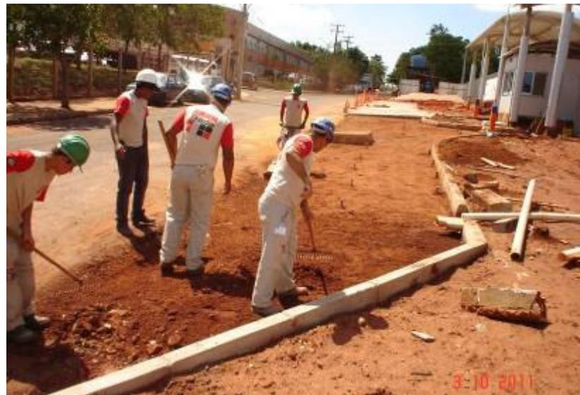
Preparo do terreno para concretagem da pista de desaceleração ao lado da pista pavimentada.
