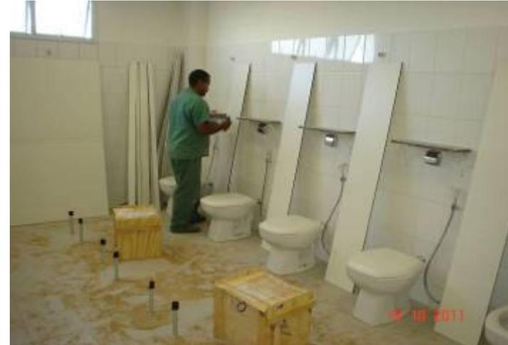
Detalhe da instalação de divisória em madeira revestida em laminado para os boxes sanitários.
