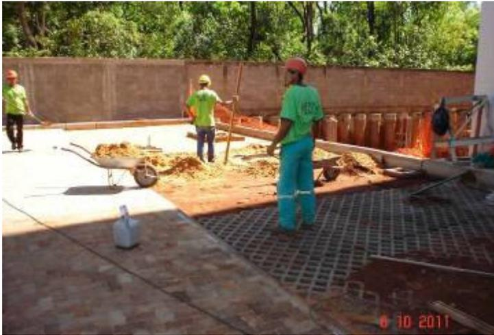
Detalhe da execução da pavimentação em piso intertravado tipo vazado para grama.
