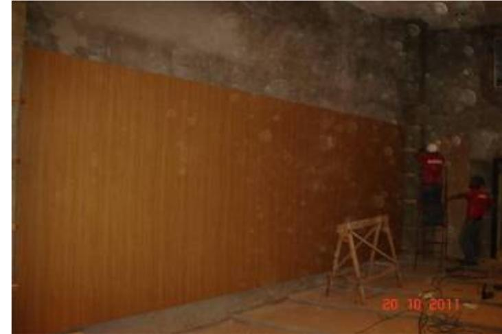
Detalhe da instalação de painel em madeira prensado nas laterais dos plenários.
