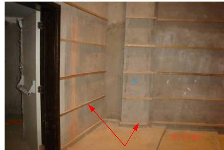
Preparo da parede com tarugos de madeiras para instalação dos painéis em madeiras prensada nas laterais dos plenários. 11
