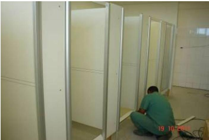
Detalhe da instalação de divisória em madeira revestida em laminado para os boxes de sanitários.
