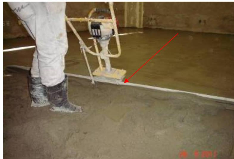
Detalhe da régua vibratória na execução de piso de alta resistência.
