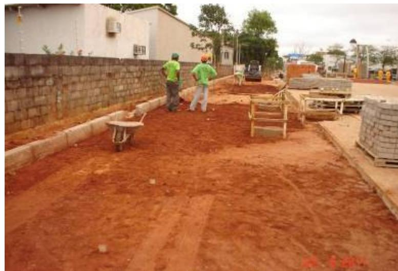
Detalhe do preparo de solo para o assentamento de piso intertravado vazado.
