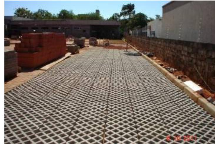
Detalhe da pavimentação em piso intertravado tipo vazado para grama.
