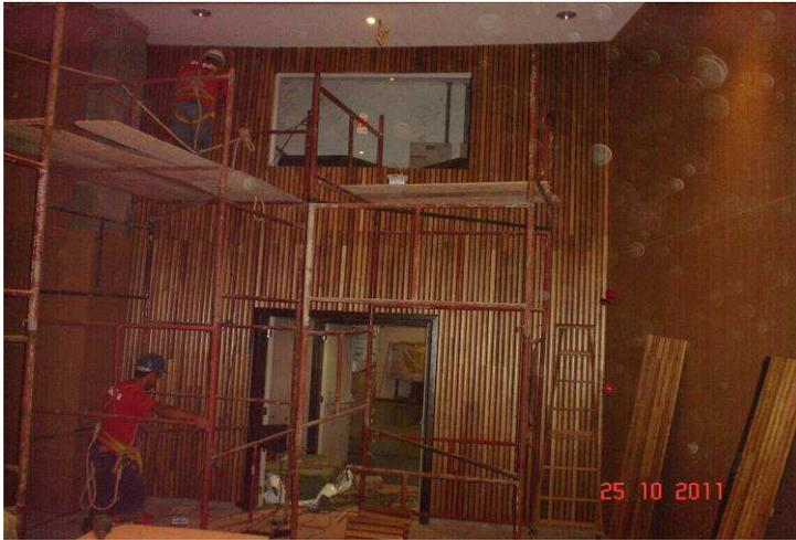
Detalhe da montagem do lambrí aberto em réguas nas paredes dos plenários.
