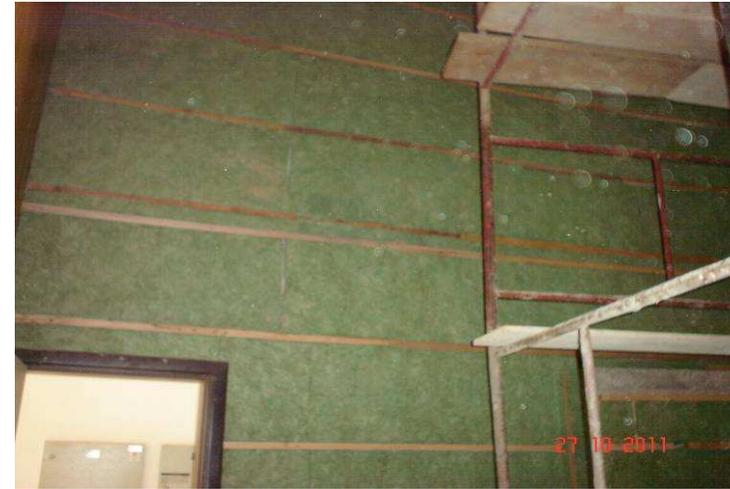
Detalhe do revestimento em lã de vidro nas paredes dos plenários onde serão aplicados os lambris em réguas.
