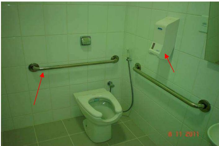
Detalhe de aplicação de barra em aço inox e do porta papel higiênico instalado no banheiro de portadores de necessidades especiais.
