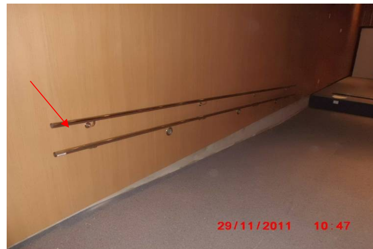
Detalhe de corrimão instalado nos plenários.
