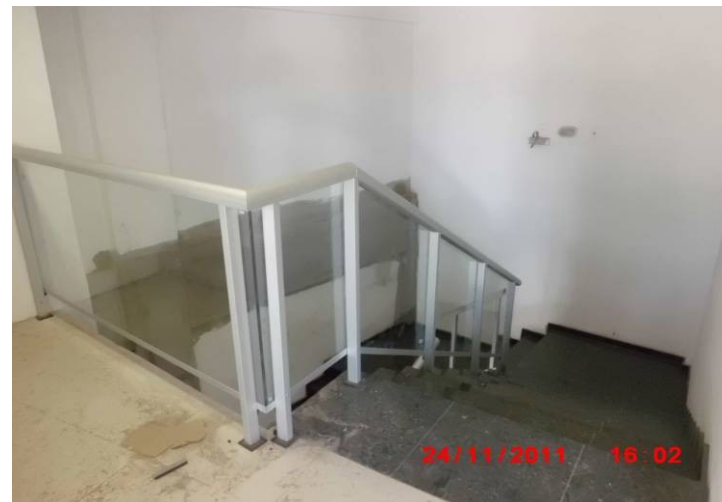
Detalhe do revestimento em granito da escada.
