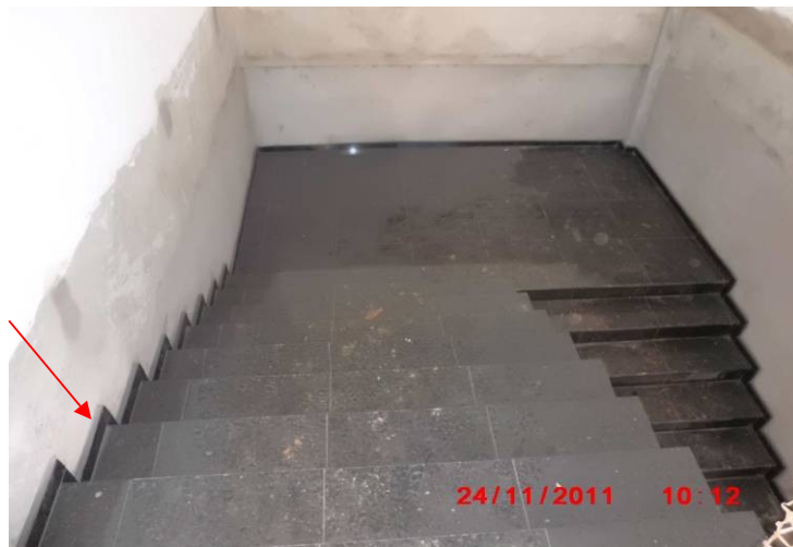
Detalhe do revestimento e rodapé em granito da escada.
