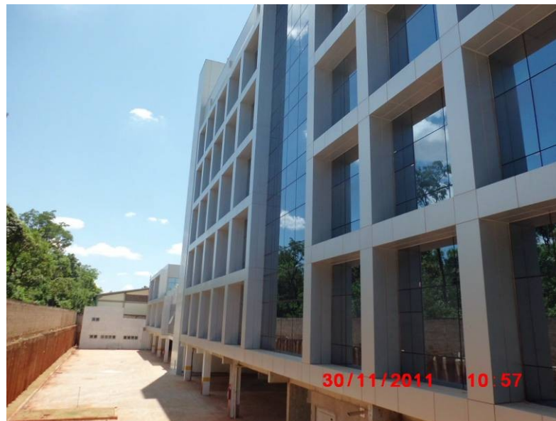
Vista do estacionamento descoberto no subsolo.
