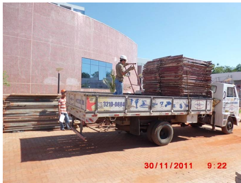
Retirada de parte de andaimes do canteiro de obras.
