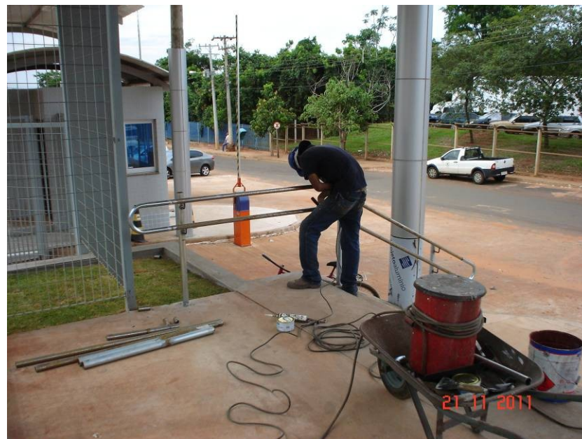
Detalhe da execução do corrimão na escada de acesso ao prédio.
