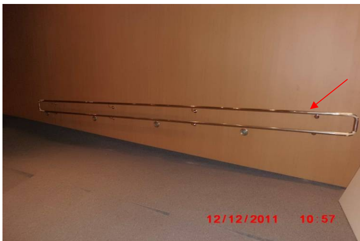
Detalhe do corrimão instalado nos plenários
