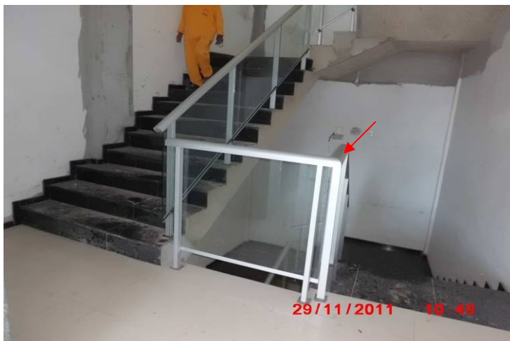
Detalhe do guarda corpo metálico.
