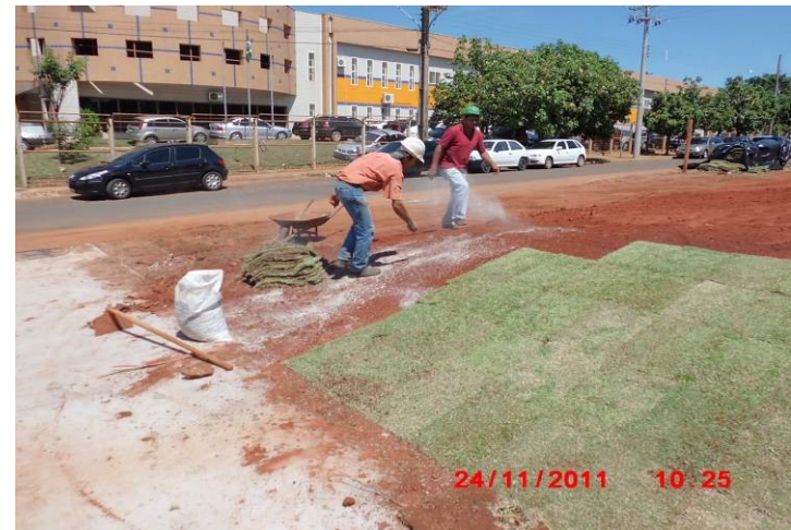
Detalhe do preparo do solo e plantio da grama em placa.
