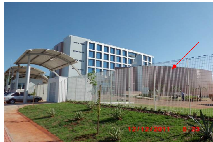
Detalhe do gradil de fechamento já instalado na fachada do prédio.
