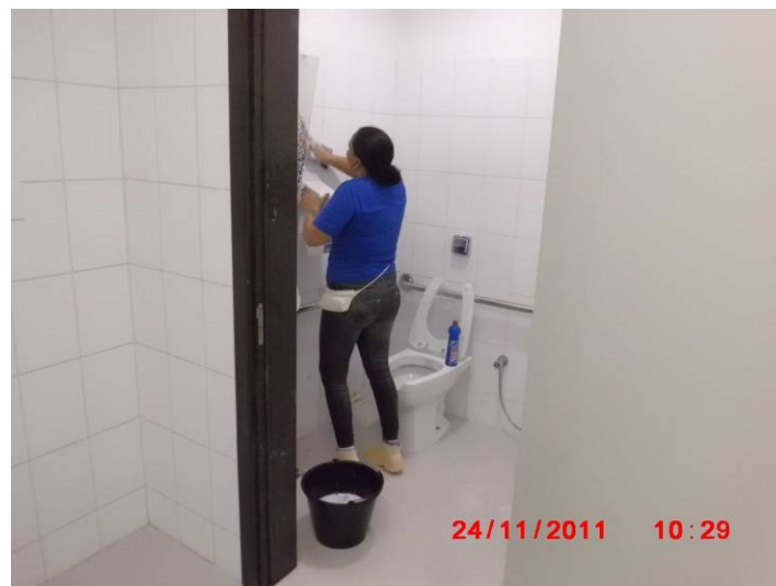
Detalhe da limpeza interna da obra.
