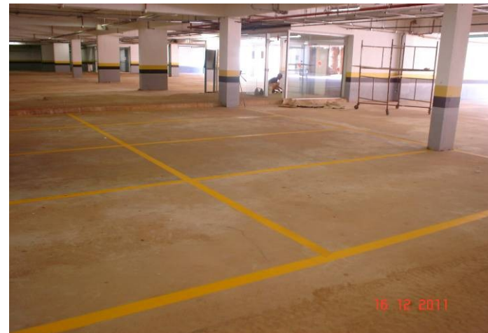
Detalhe da pintura da demarcação de vagas no estacionamento do subsolo.
