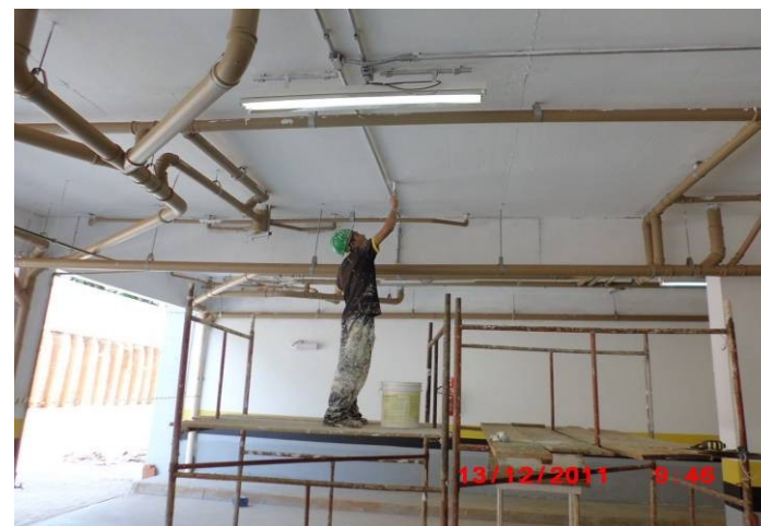
Detalhe da pintura do teto do subsolo.
