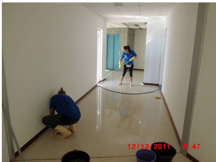
Detalhe da limpeza interna da obra.
