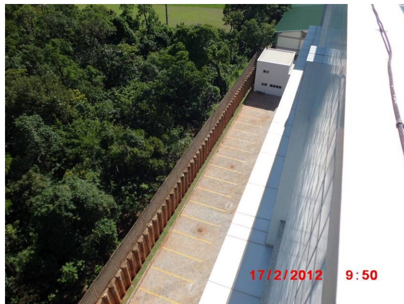
Vista de parte da fachada norte e do estacionamento descoberto do subsolo.
