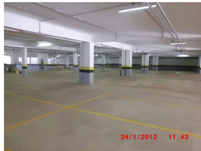
Pintura em látex PVA sem massa acrílica sobre o teto do subsolo.
