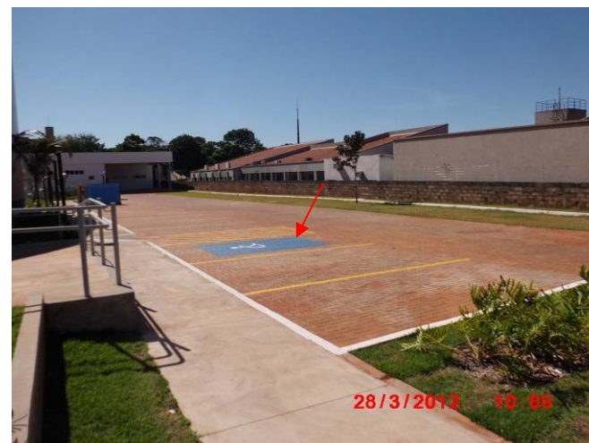
Detalhe da pintura de vaga de estacionamento para PNE.
