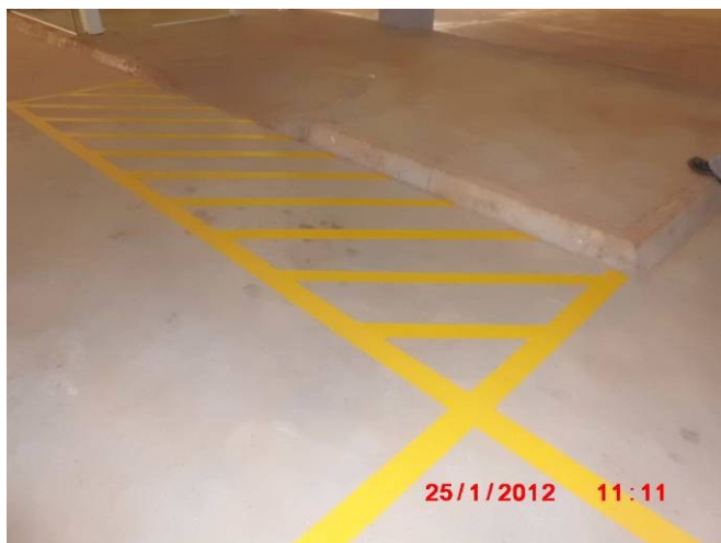
Detalhe da faixa zebrada pintada em vaga do estacionamento do subsolo.
