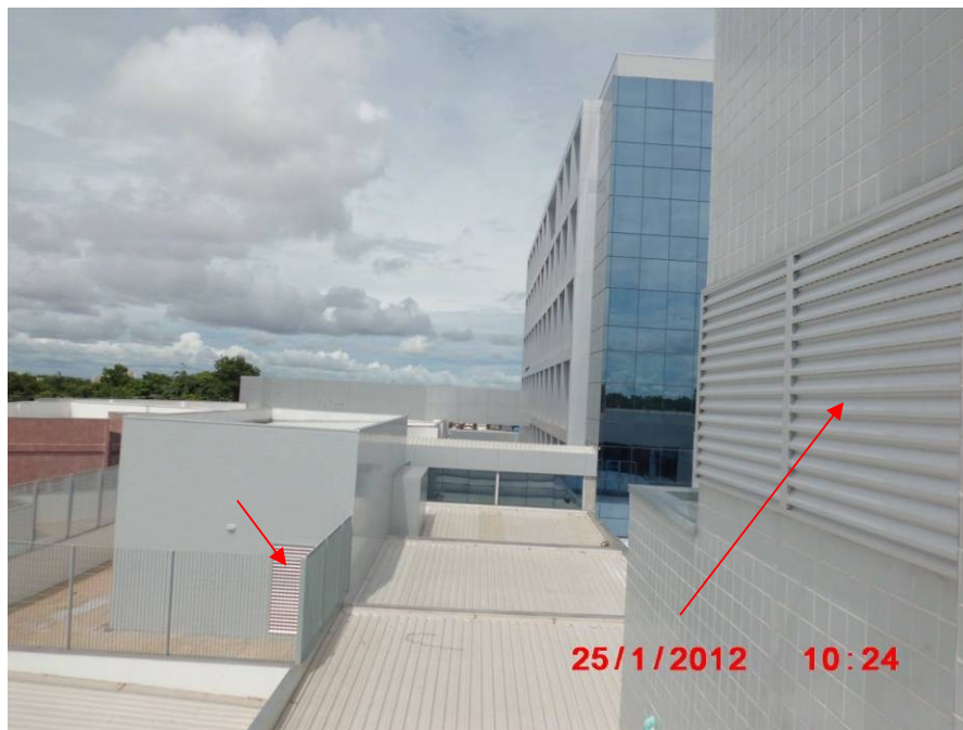
Detalhe das esquadrias em alumínio (porta e veneziana).
