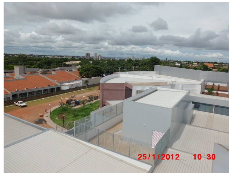
Vista de parte dos telhados da fachada sul.
