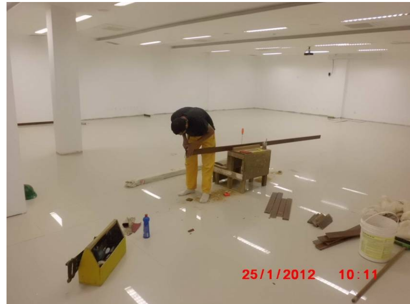
Equipe de trabalho executando rodapé em madeira na sala de treinamento.
