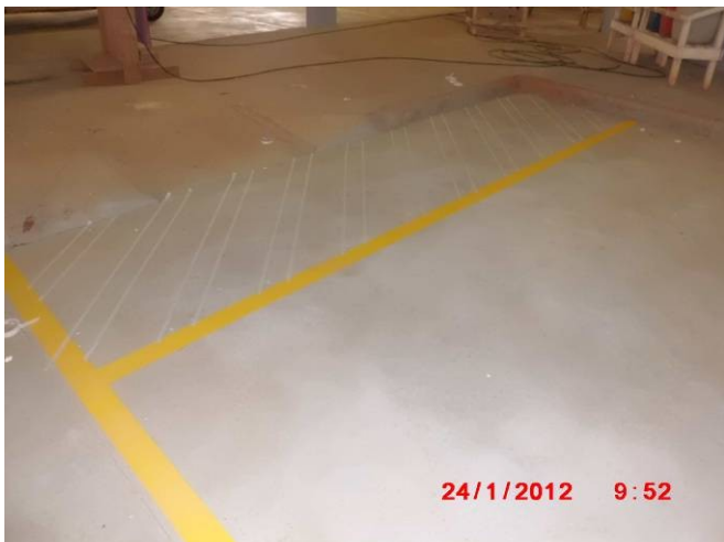
Execução de faixa zebrada em vaga do estacionamento do subsolo.
