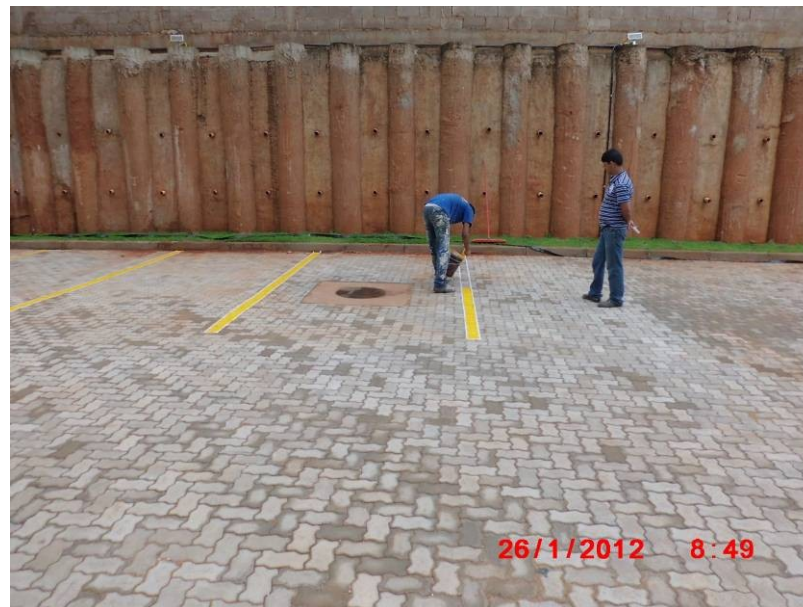
Pintura de demarcação de estacionamento no subsolo descoberto.
