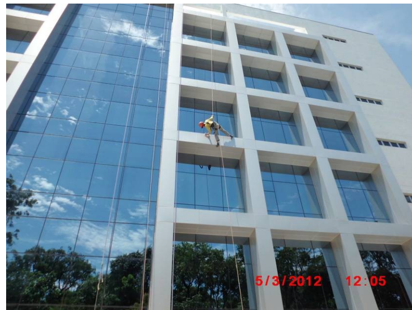
Vista da limpeza externa da Fachada Norte.
