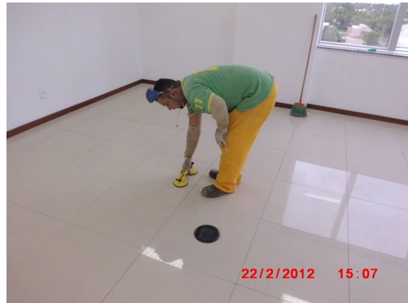
Vista de equipe executando revisão de serviços do piso elevado.
