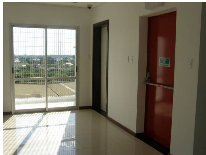
Detalhe da pintura e identificação de rota de fuga – saída de emergência.
