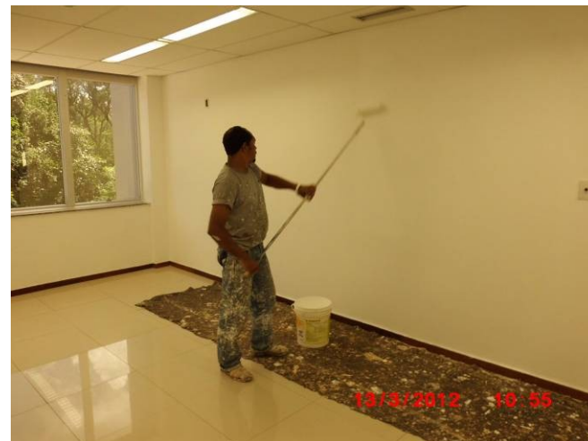
Detalhe de retoque de pintura interna no 1º pavimento.
