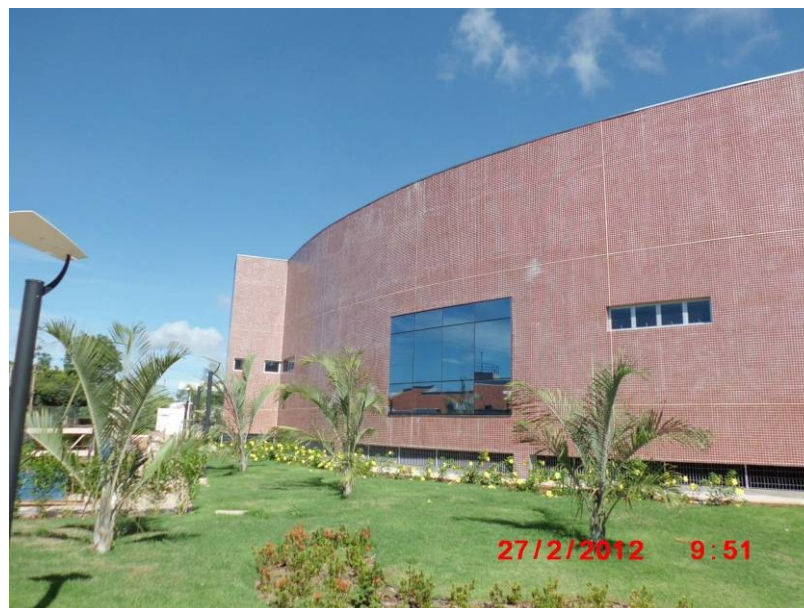
Vista de parte da Fachada Sul.
