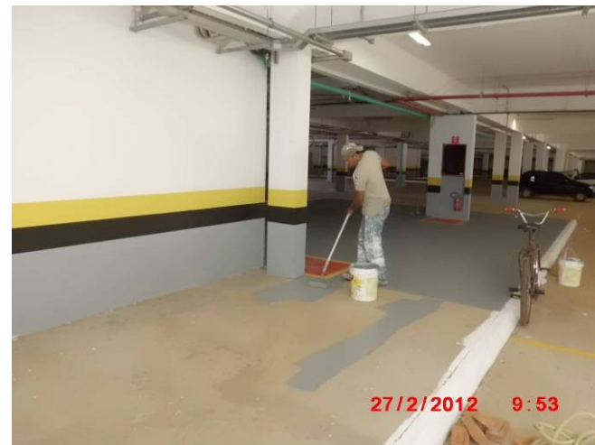
Detalhe de pintura sobre ilha de proteção no subsolo.
