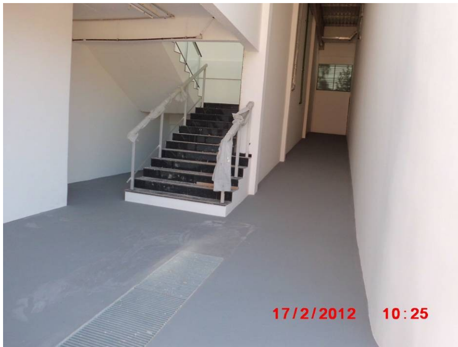
Guarda-corpo de uma das escadas de acesso ao subsolo e térreo.
