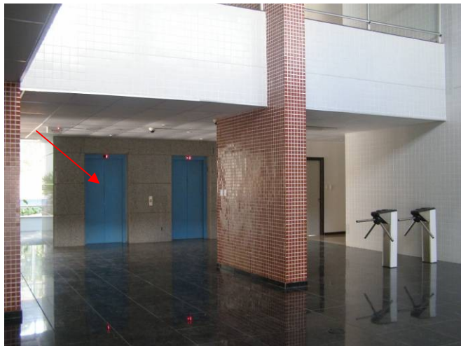
Vista dos elevadores panorâmicos instalados no pavimento térreo.
