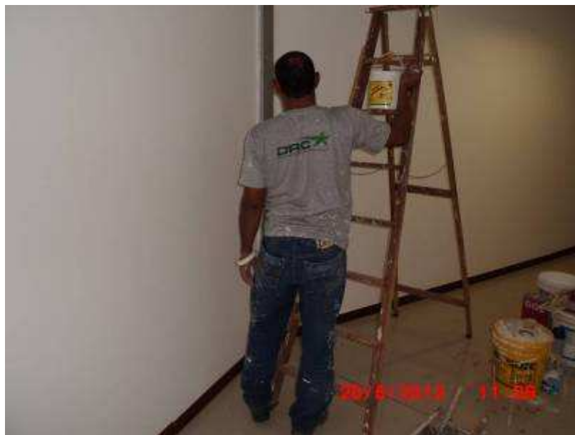
Serviço de pintura.
