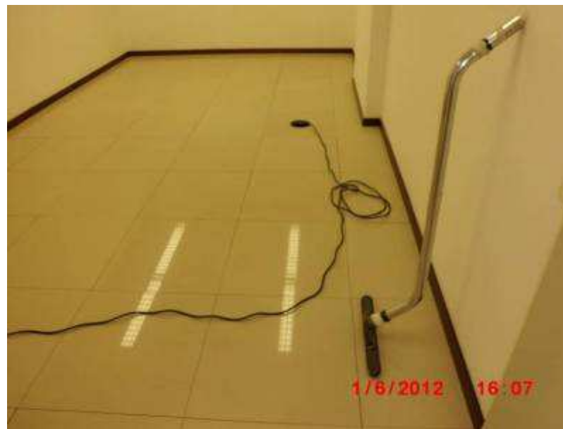
Vista de ambiente interno.
