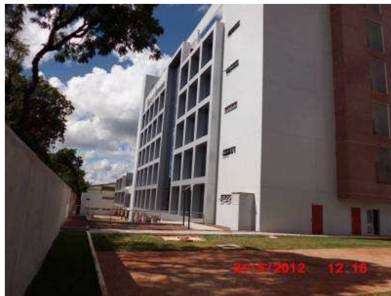
Vista parcial da fachada norte.
