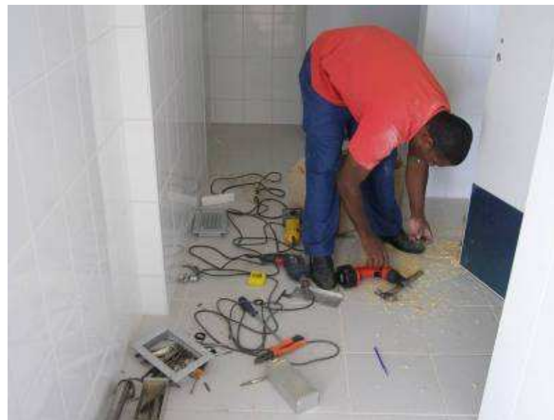
Equipe executando revisão das esquadrias de madeira.
