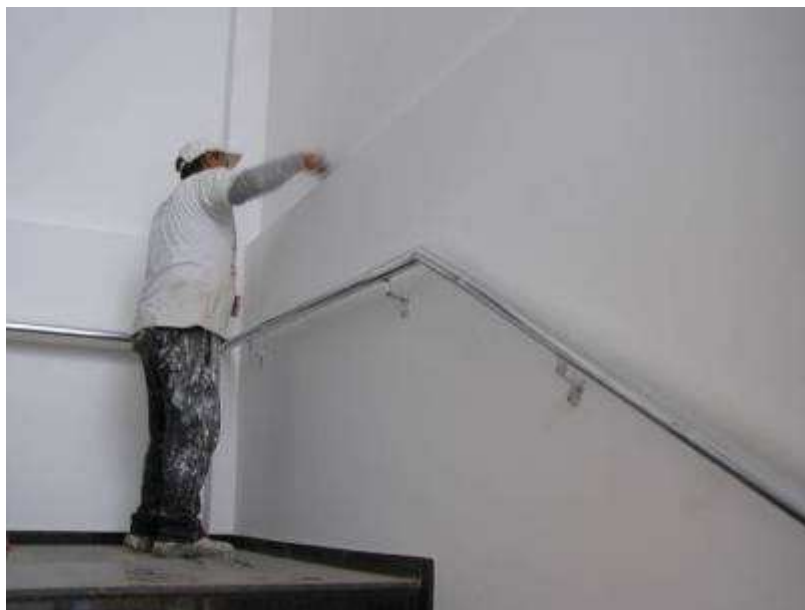
Corrimão de inox em escada.
