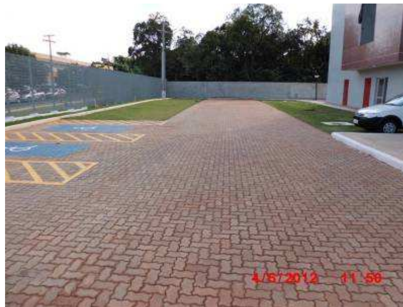
Vista do estacionamento frontal (fachada norte).
