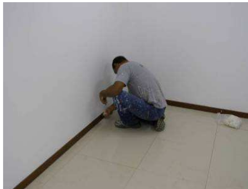
Serviço de pintura.
