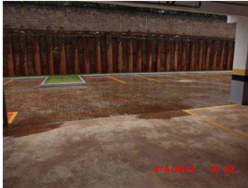
Vista do estacionamento descoberto no subsolo em dia de chuva.
