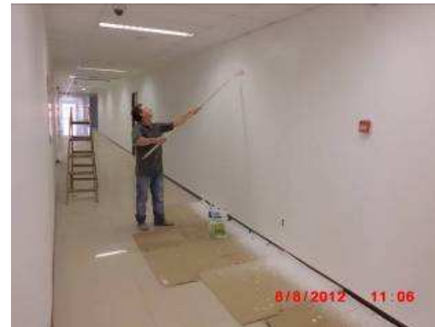
Detalhe da pintura em parede interna.
