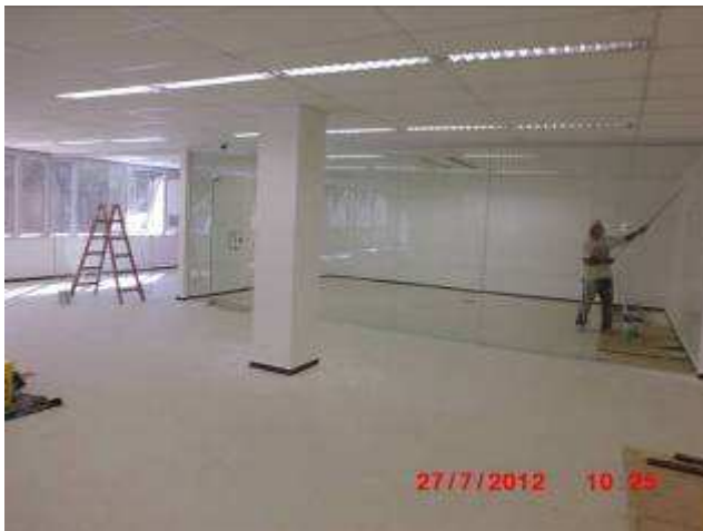
Detalhe da pintura em parede interna.
