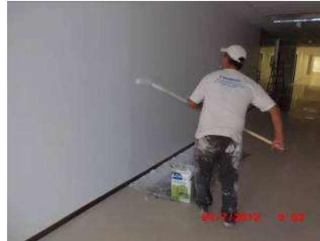
Detalhe da pintura em parede interna.
