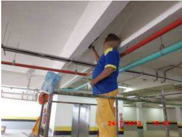
Detalhe da pintura em teto do subsolo.
