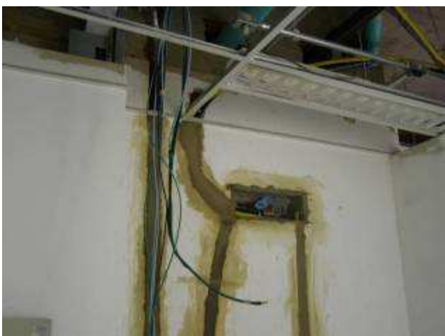
Instalação de infraestrutura para condicionador de ar tipo split em sala técnica do térreo trecho B
