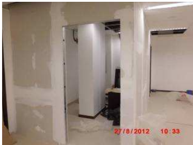
Detalhe da massa corrida em divisória de gesso acartonado.
