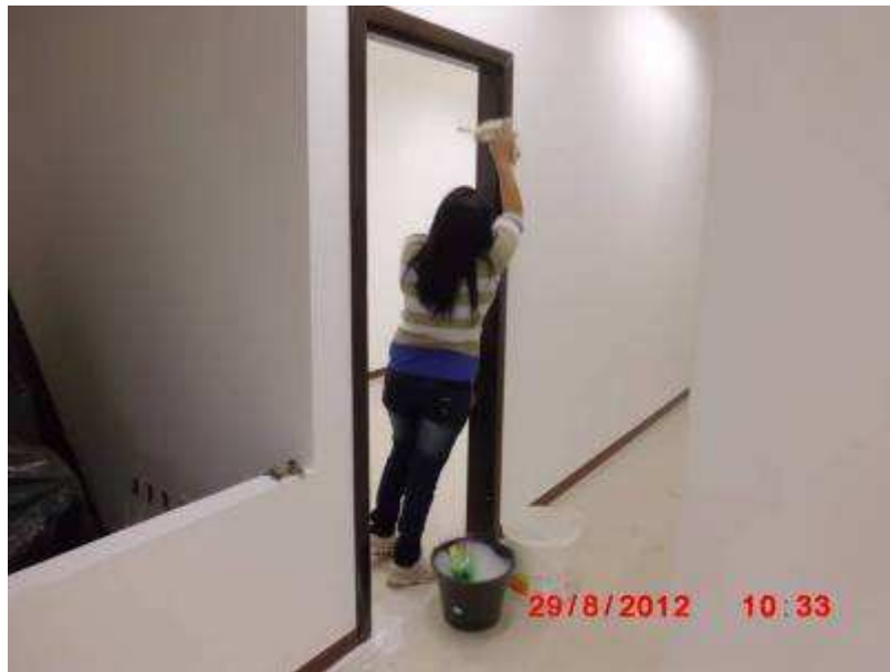
Detalhe de serviço de limpeza final.
