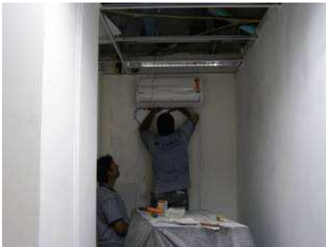
Detalhe de instalação de equipamento de split na sala técnica do térreo trecho B
