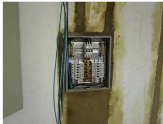
Instalação de quadro elétrico para rede estabilizado por no-break a ser adquirido pelo TRT
