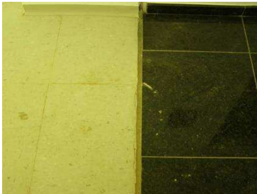
Detalhe da junta de dilatação, entre o piso de granito e o piso vinílico.
