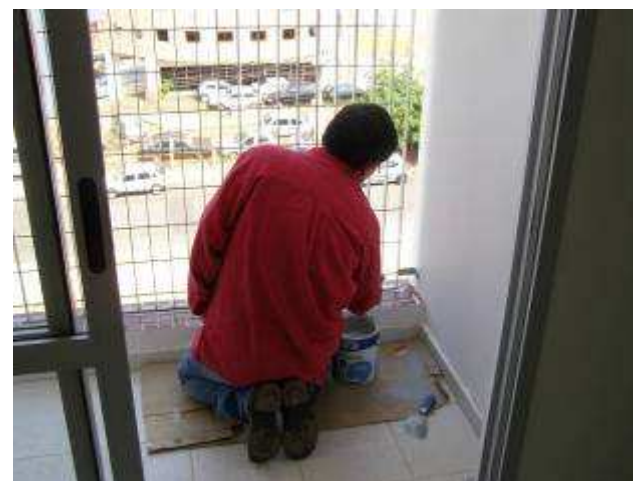
Detalhe de pintura em gradil de proteção da fachada.
