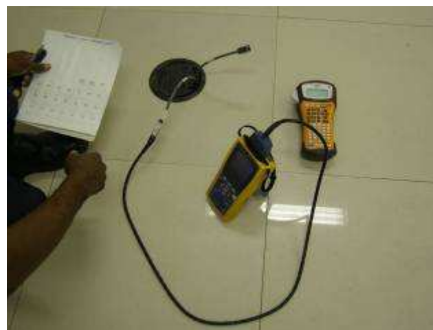
Utilização de equipamento para certificação digital da qualidade do cabeamento estruturado
