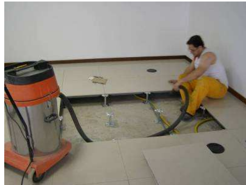
Detalhe de serviço de limpeza final.
