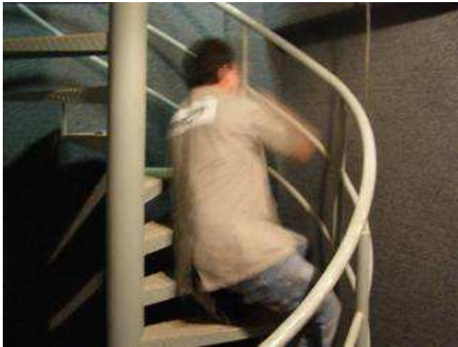
Detalhe de acabamento do corrimão metálico.
