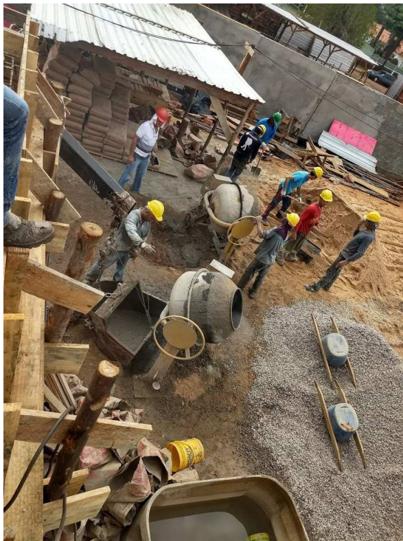
Confecção de concreto em betoneira e lançamento primário em caçamba adaptada no munk
