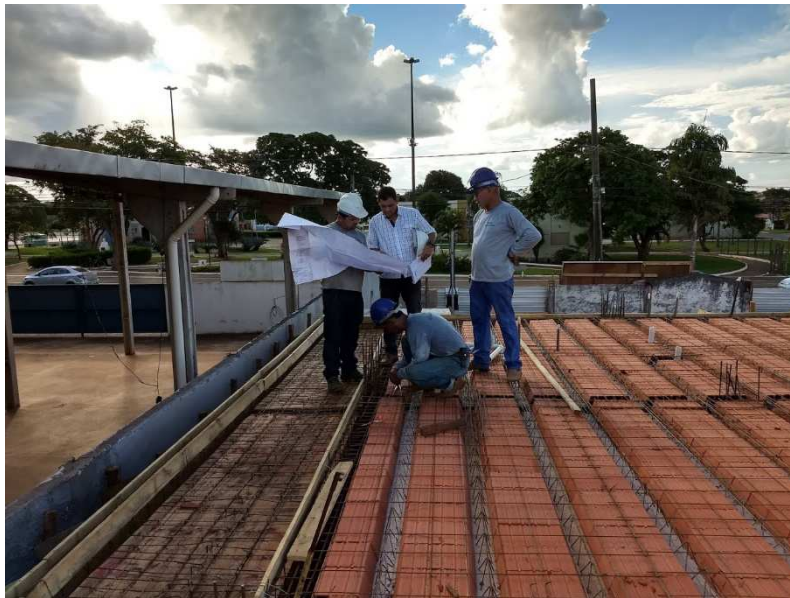
Conferência das armaduras para liberação da concretagem
