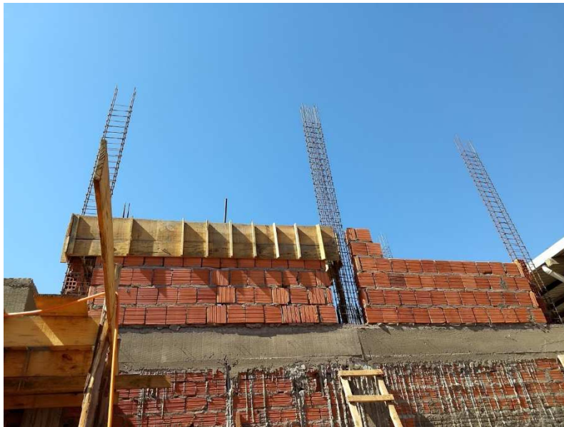
Alvenaria de vedação do 2º pavimento e caixa d'água.
