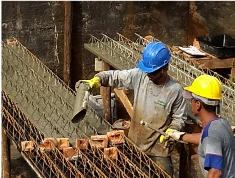
Detalhe da fabricação de lajes pré-moldadas no canteiro de obra
