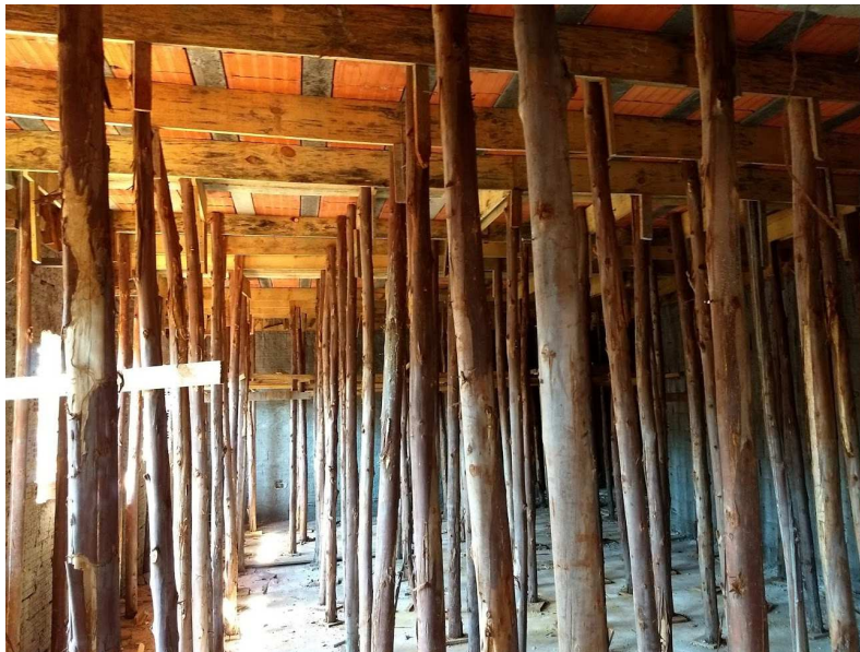
Detalhe de escoramento de laje pré-moldada e de laje maciça (beiral)
