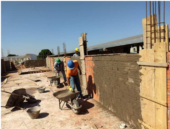
Chapisco na platibanda e, em seguida, o 2º pavimento chapiscado
