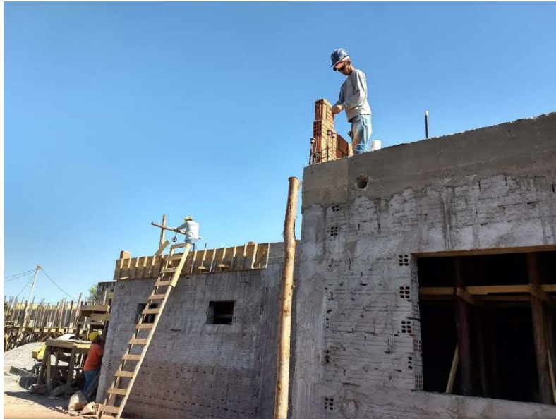
Alvenaria de vedação das platibandas
