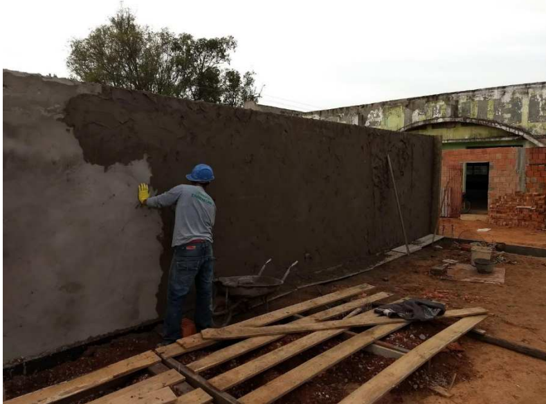
Emboçamento dos muros
