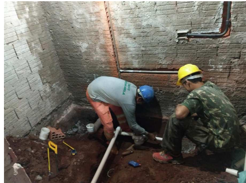
Detalhe do esgoto de um banheiro e a instalação da rede de esgoto interna
