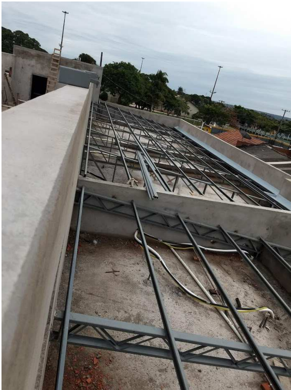
Estrutura metálica da cobertura da fachada oeste
