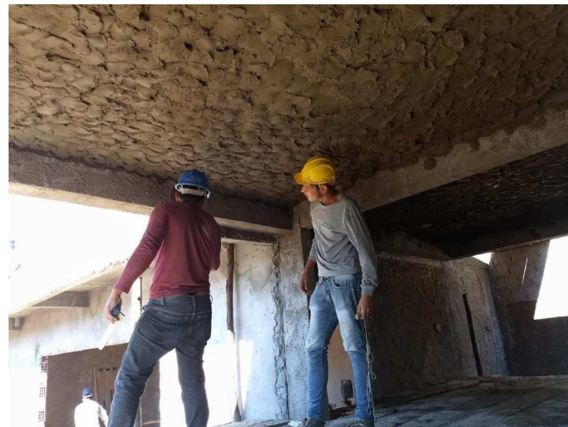
Emboçamento de laje
