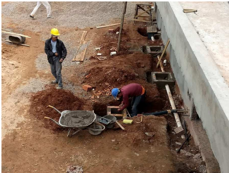
Caixa de passagem elétrica e tubulação corrugada de 4". Detalhe da infraestrutura elétrica entre forros
