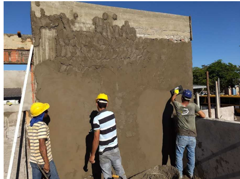
Emboçamento do abrigo da caixa d'água
