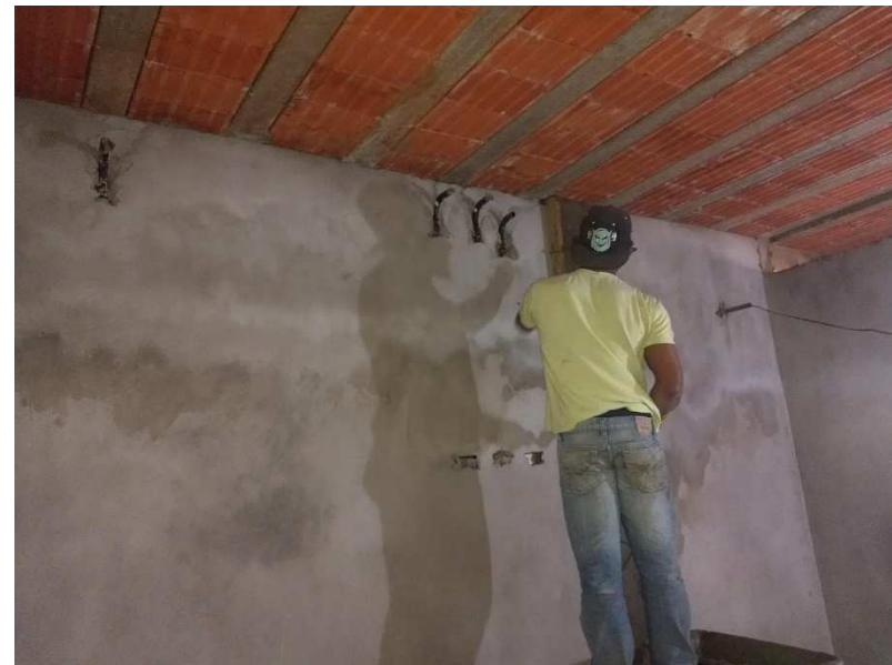
Caixa de passagem elétrica e tubulação corrugada de 4". Detalhe da infraestrutura elétrica entre forros
