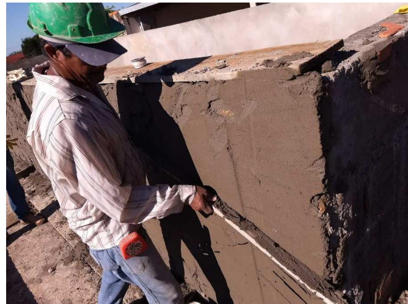
Emboçamento da platibanda
