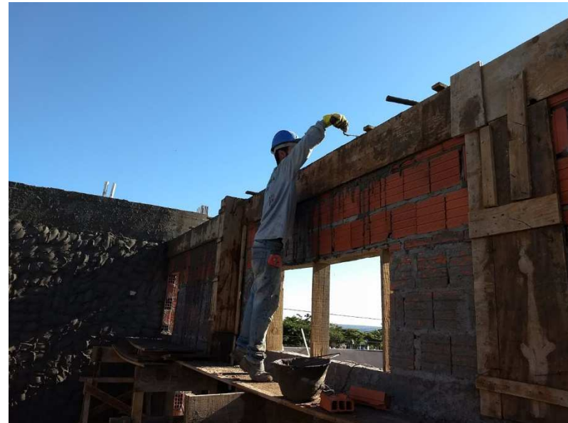
Lançamento e acabamento de concreto em viga cinta
