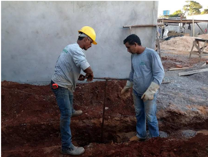
Estaca a trado e escavação manual de valas
