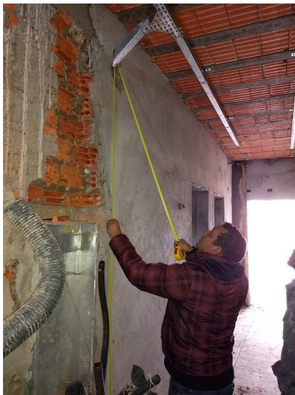
Eletrocalha para passagem de fios, cabos elétricos e cabos de lógica
