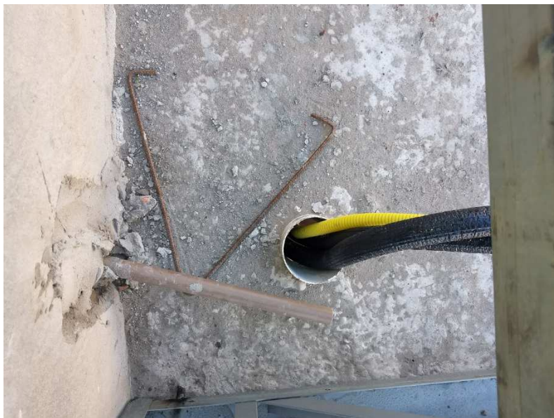
Tubulação frigorífica e elétrica do sistema de climatização
