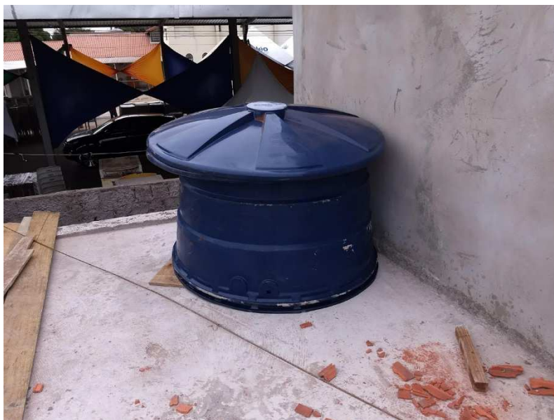
Reservatório superior de água de chuva e cisterna a ser enterrada
