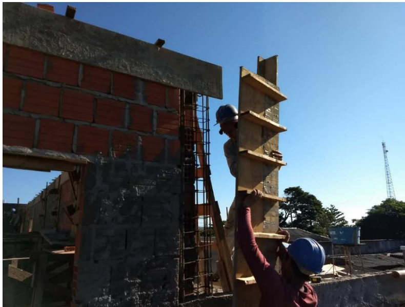
Montagem e desmontagem de formas
