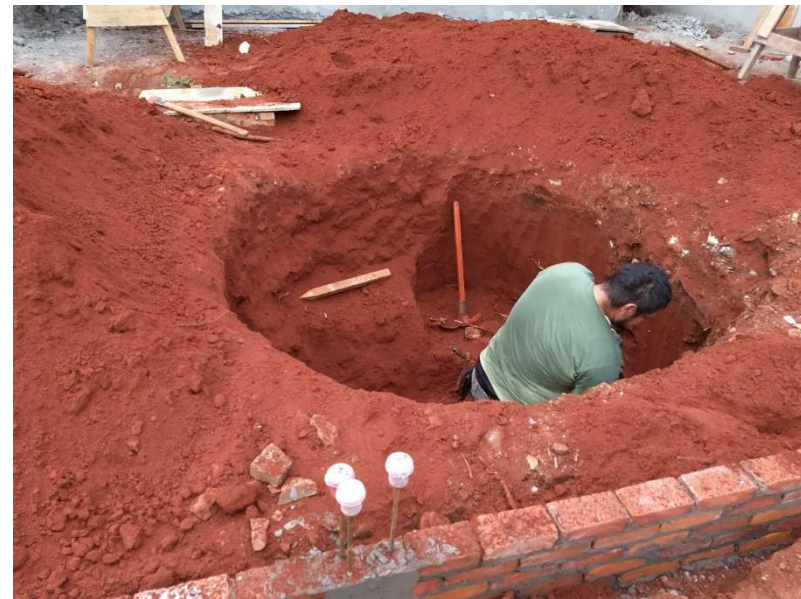
Caixa de passagem, abertura de valeta para tubulação de águas pluviais e escavação para a cisterna
