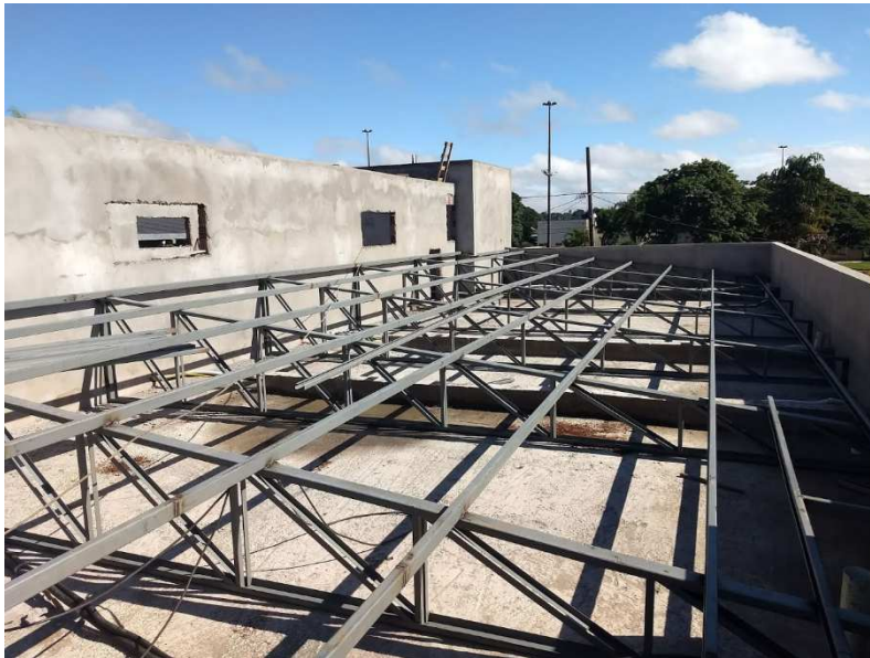
Estrutura metálica da cobertura da fachada leste
