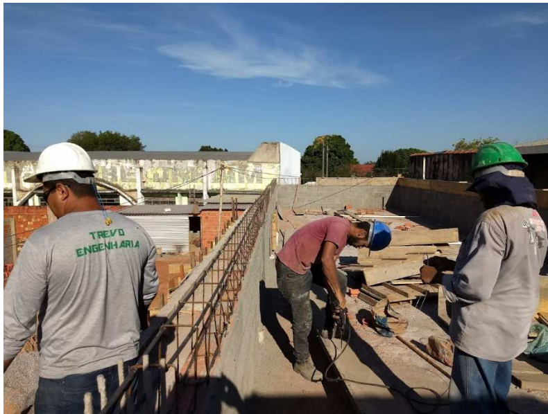
Instalação de armação e fechamento das formas
