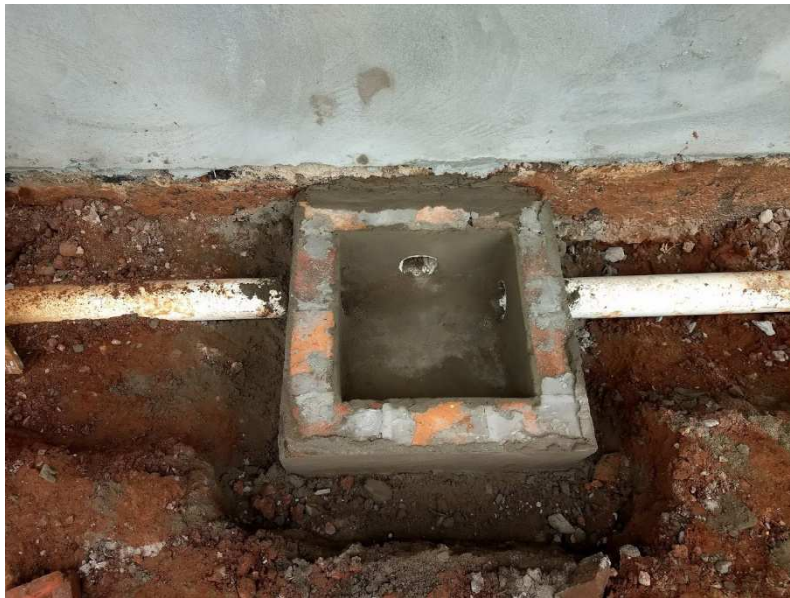
Instalação da rede de esgoto externa, detalhe de caixa de passagem e caixa de gordura
