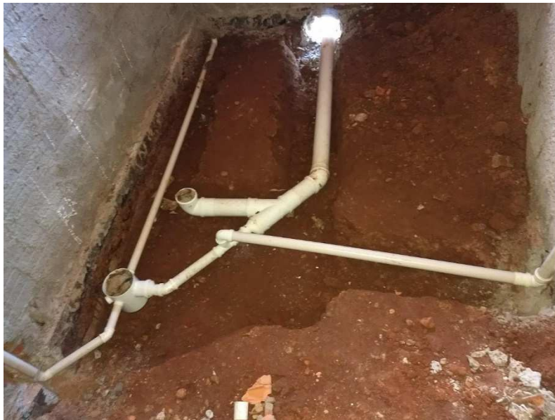
Detalhe do esgoto de um banheiro e a instalação da rede de esgoto interna
