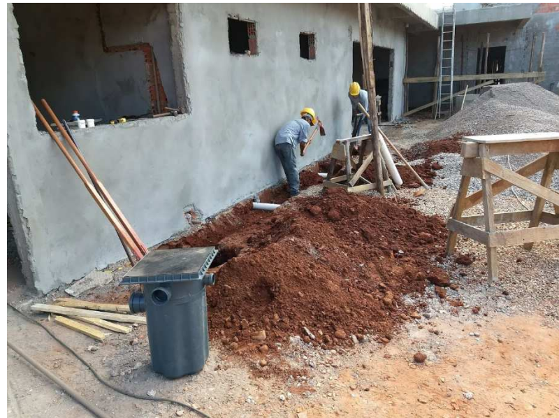
Instalação da rede de esgoto externa, detalhe de caixa de passagem e caixa de gordura
