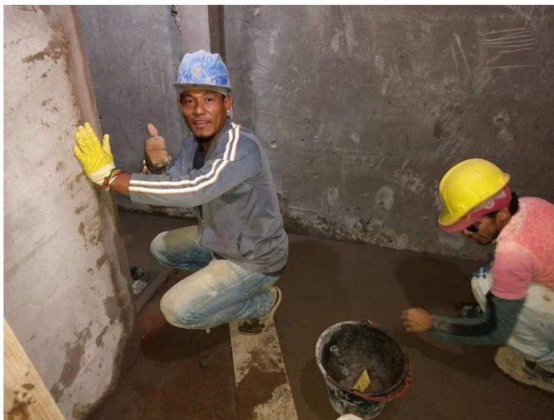
Piso regularizado no banheiro e na sala do assistente
