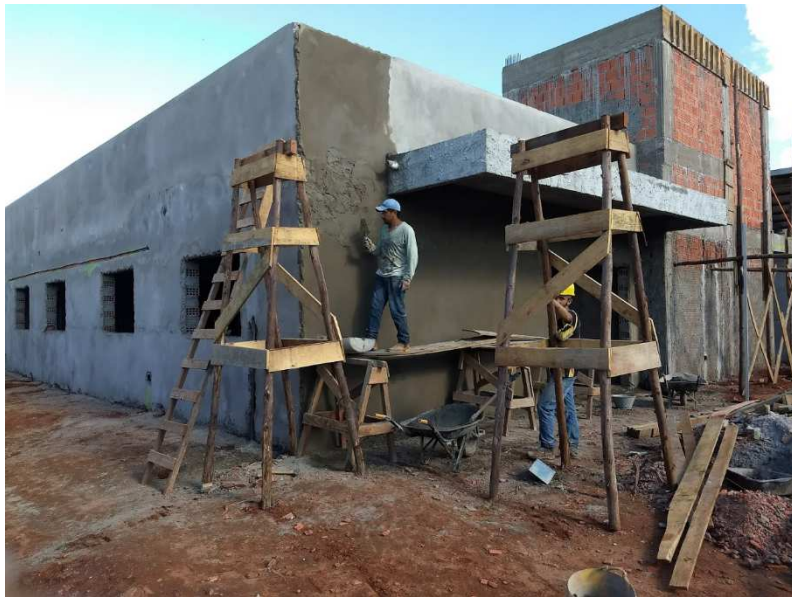
Emboçamento da fachada principal
