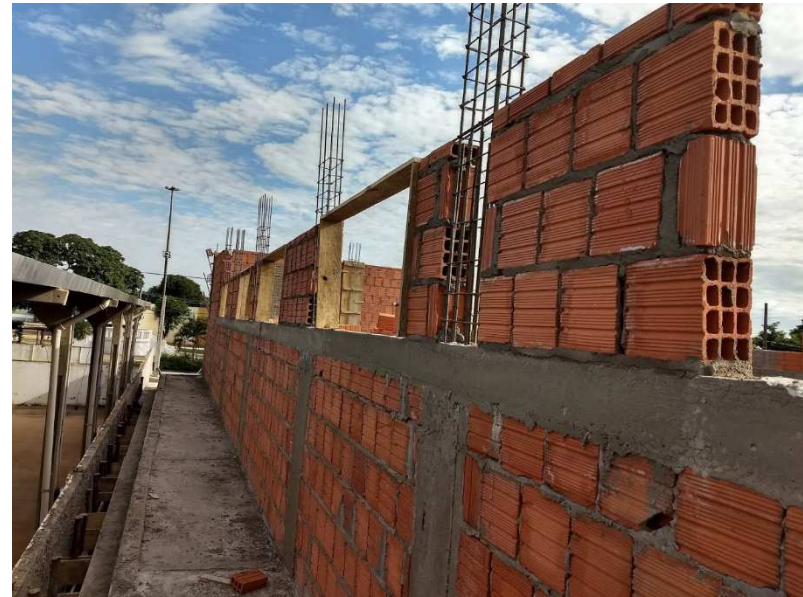
Montagem de vergas e detalhe da verga contínua aplicada na sala técnica do segundo piso
