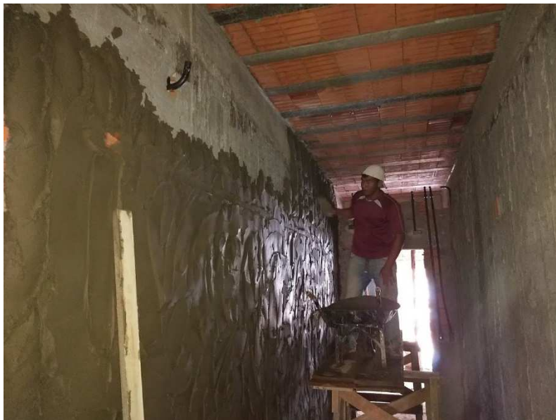
Emboçamento da parede do corredor
