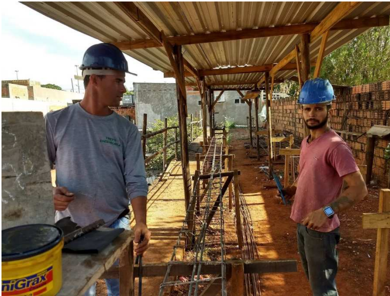
Montagem de vergas e detalhe da verga contínua aplicada na sala técnica do segundo piso
