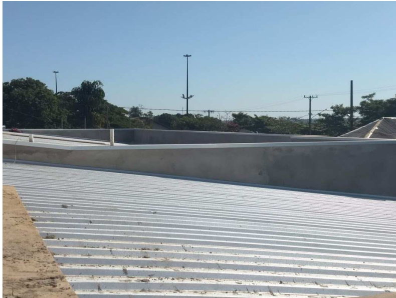
Rufos e calhas instalados
