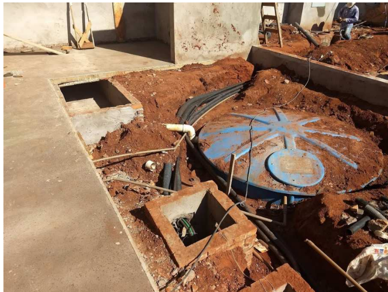
Detalhe do calçamento com a cisterna de água de chuva e os blocos ecológicos do estacionamento
