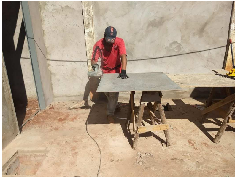
Corte e assentamento de porcelanato
