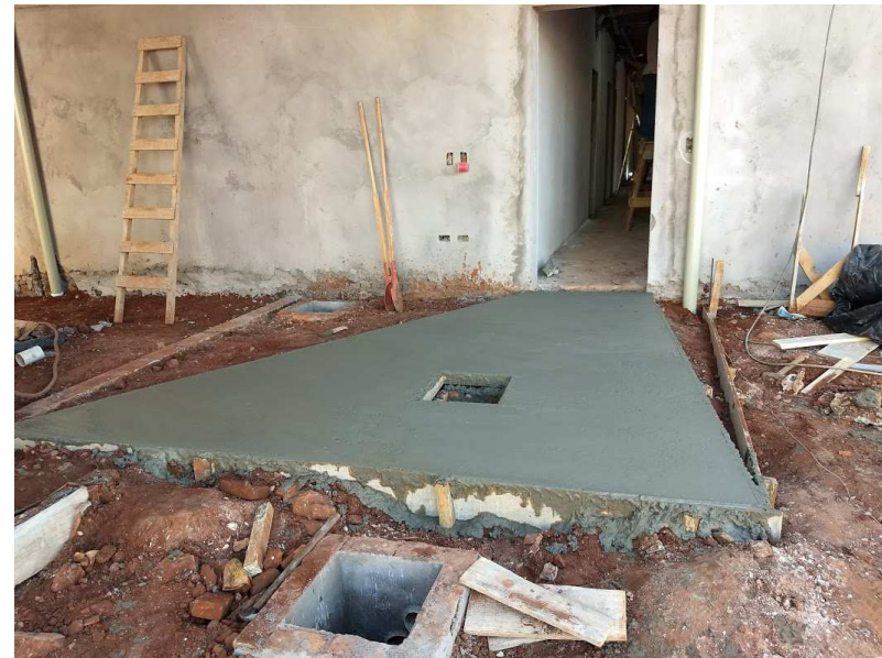
Detalhe da execução de calçada e da rampa de acesso da entrada de serviço
