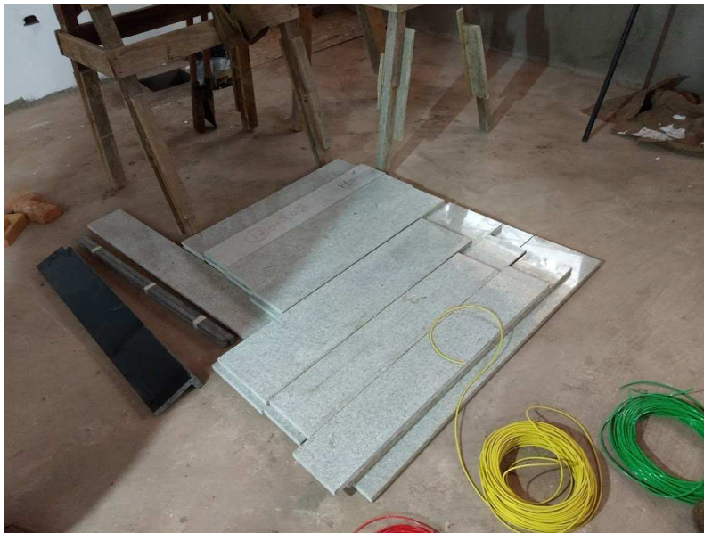
Detalhe das soleiras e do piso tátil
