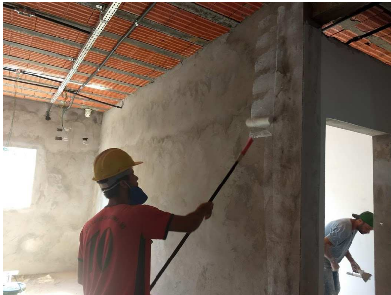
Aplicação de seladora e de massa corrida
