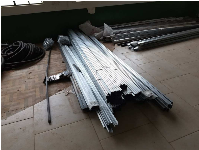
Estrutura do forro e placas de gesso acartonado
