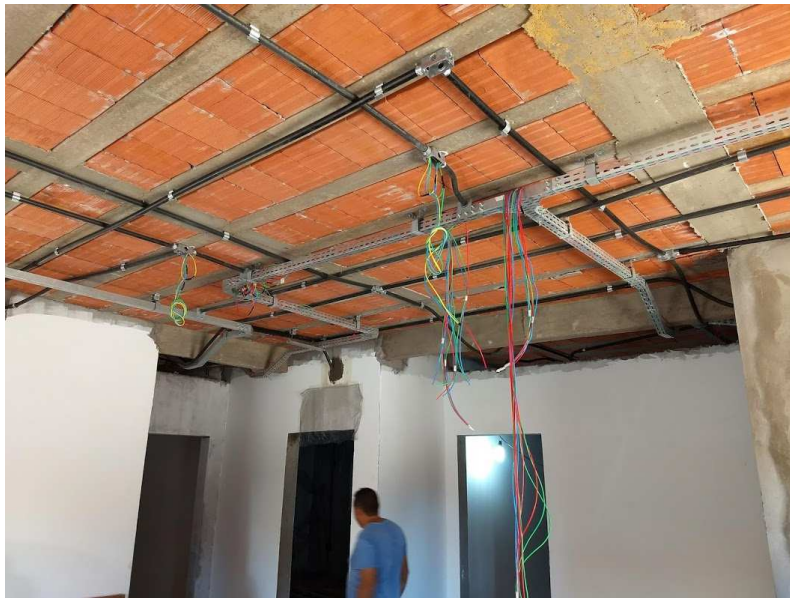
Detalhe da fiação nas eletrocalhas e dos quadros de distribuição
