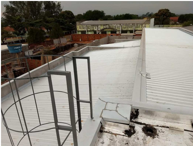
Detalhe da escada externa e guarda corpo da escada interna
