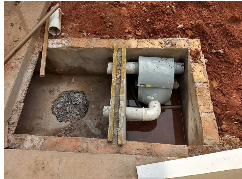
Caixas de passagens de alvenaria impermeabilizada, grelha e detalhes do filtro e sistema “first flush”
