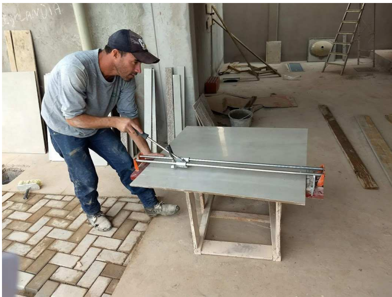
Detalhe do corte do porcelanato e do piso de um banheiro
