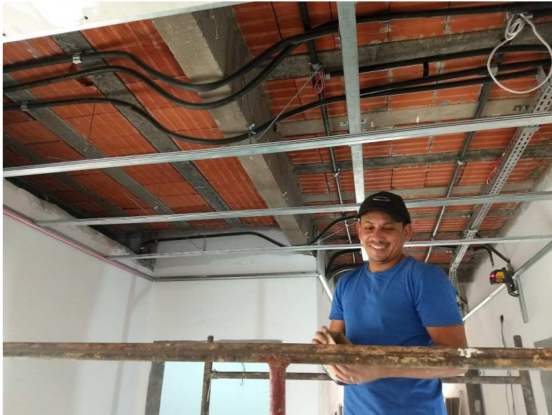
Estrutura do forro e detalhe do forro de gesso acartonado no corredor
