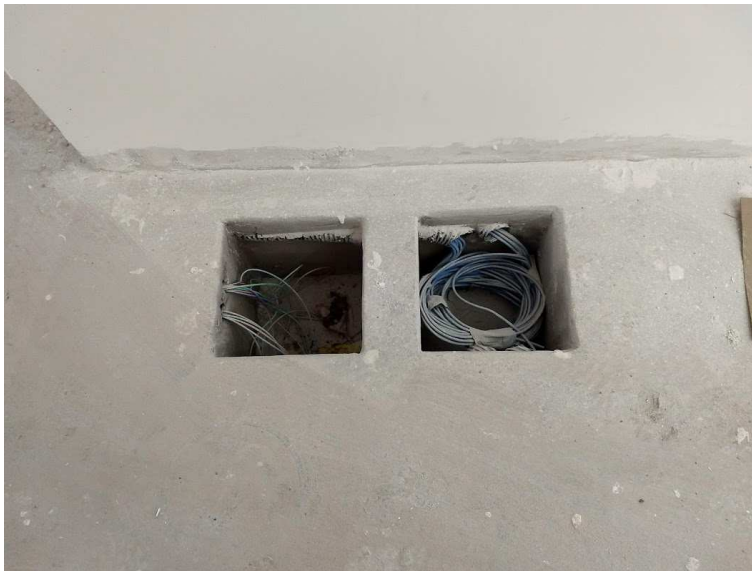
Caixas de passagens sob o piso elevado e detalhe da chegada do cabeamento estruturado na sala técnica
