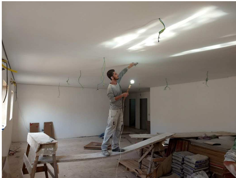
Lixamento e rolamento de látex em teto
