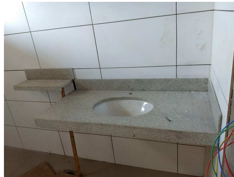
Detalhe do apoio para trocador e da bancada dos banheiros em granito com porta bolsa
