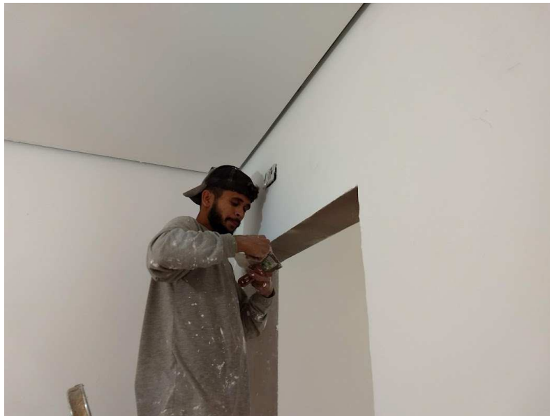
Aplicação de massa corrida em forro de gesso e em paredes
