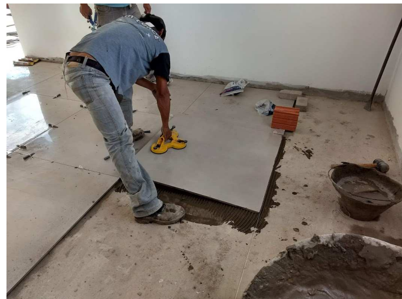
Instalação de piso utilizando ventosas
