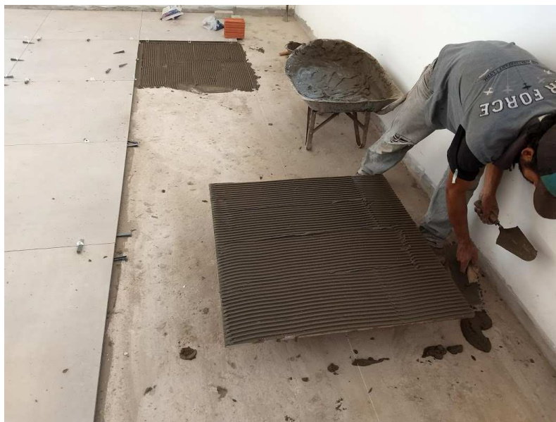
Detalhe da aplicação de argamassa industrial no piso e no porcelanato com espátula dentada, em sentido cruzado
