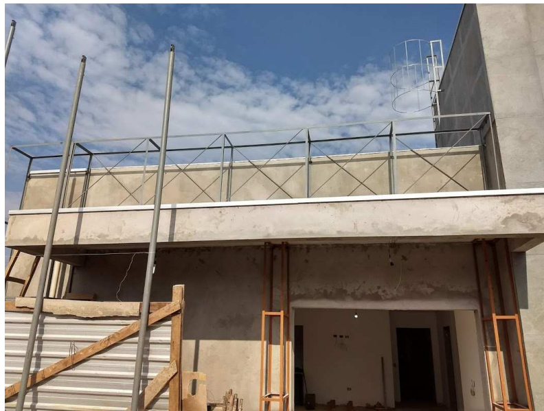
Detalhe da estrutura em metalon para o revestimento em alumínio composto
