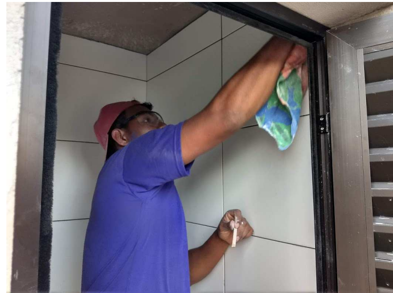
Detalhe dos revestimento externo e limpeza do rejunte do abrigo de lixo
