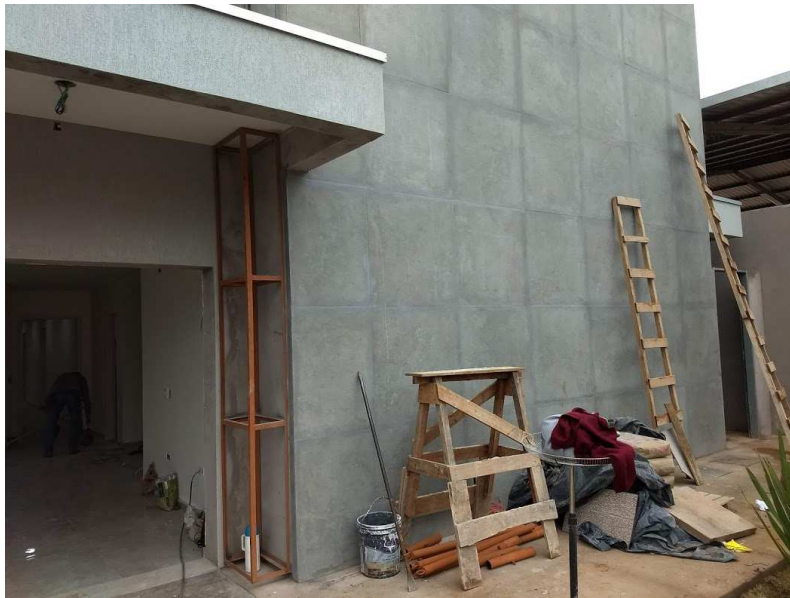
Detalhe dos revestimento externo e limpeza do rejunte do abrigo de lixo
