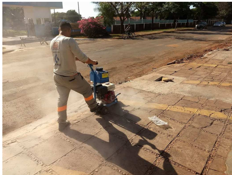
Ligação definitiva de esgoto, executado pela SANESUL
