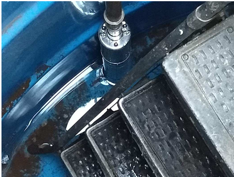
Detalhe da bomba movida a energia solar e o reservatório de 5000l enterrado (cisterna)
