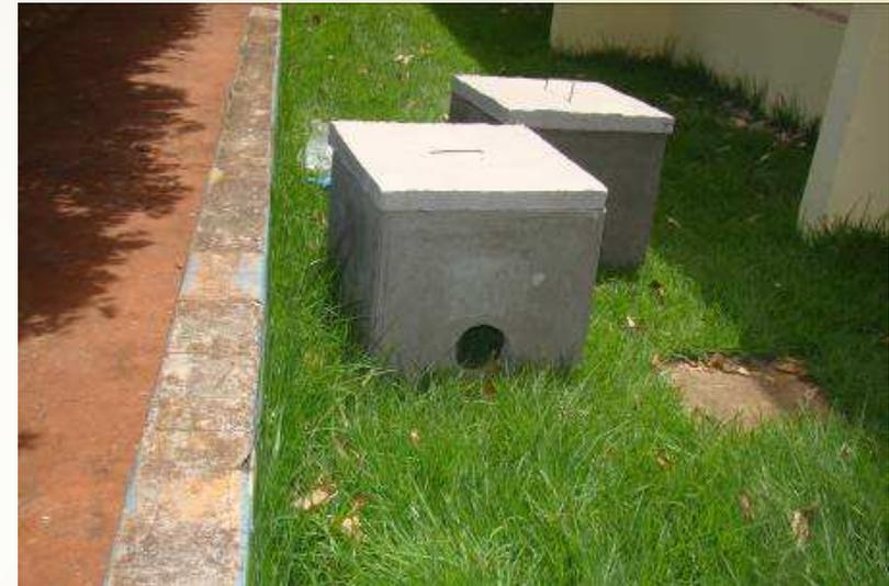
Detalhe das caixas de passagem de elétrica
