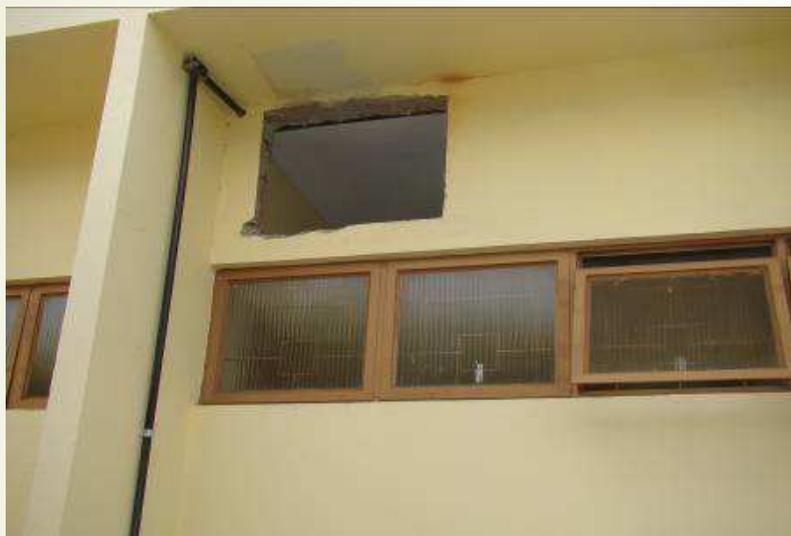
Detalhe de vão para caixa de ar condicionado
