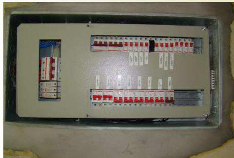
Detalhe do novo quadro de energia, com etiquetas orientadoras
