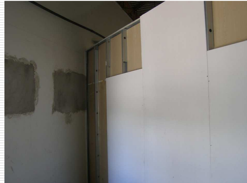
Parede de gesso acartonado sendo montada
