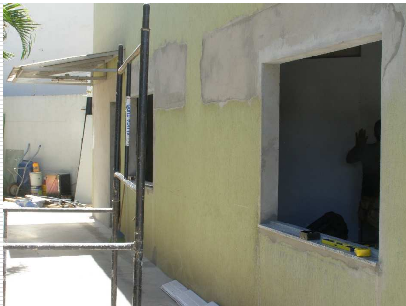
Requadro das aberturas das esquadrias: portas e janelas
