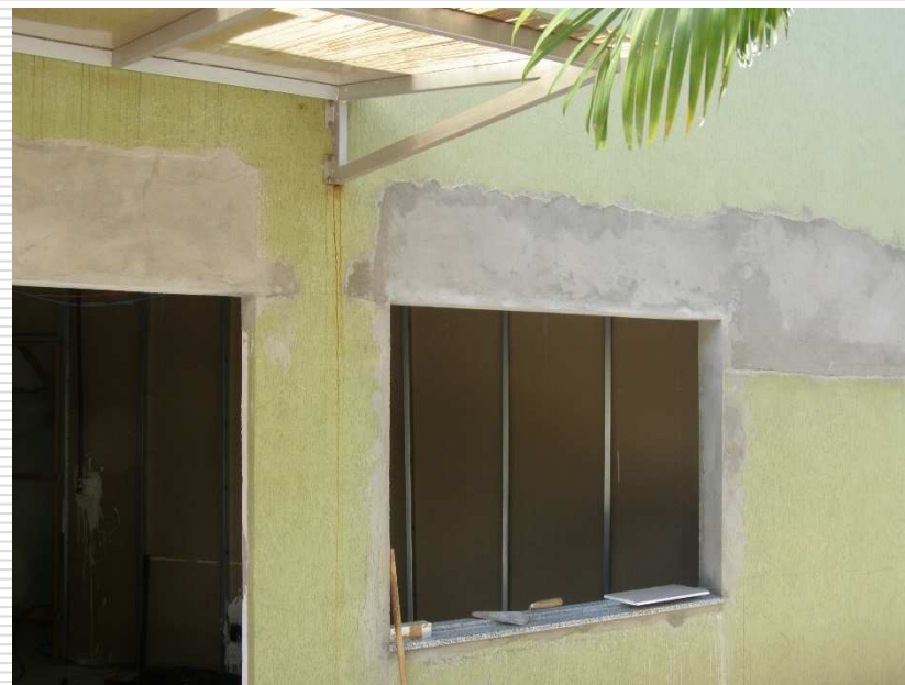
Requadro das aberturas das esquadrias: portas e janelas
