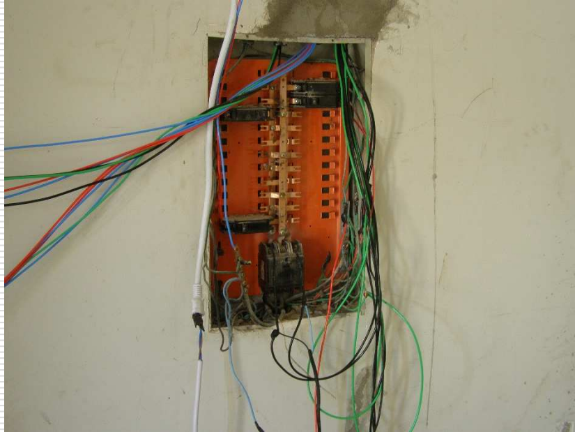
Detalhe geral do quadro de distribuição que está sendo montado
