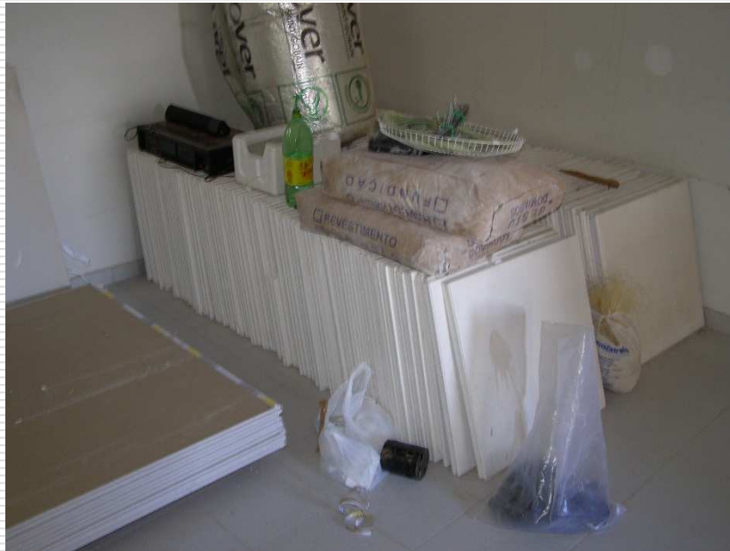
Placas de gesso para forro suspenso com arame
