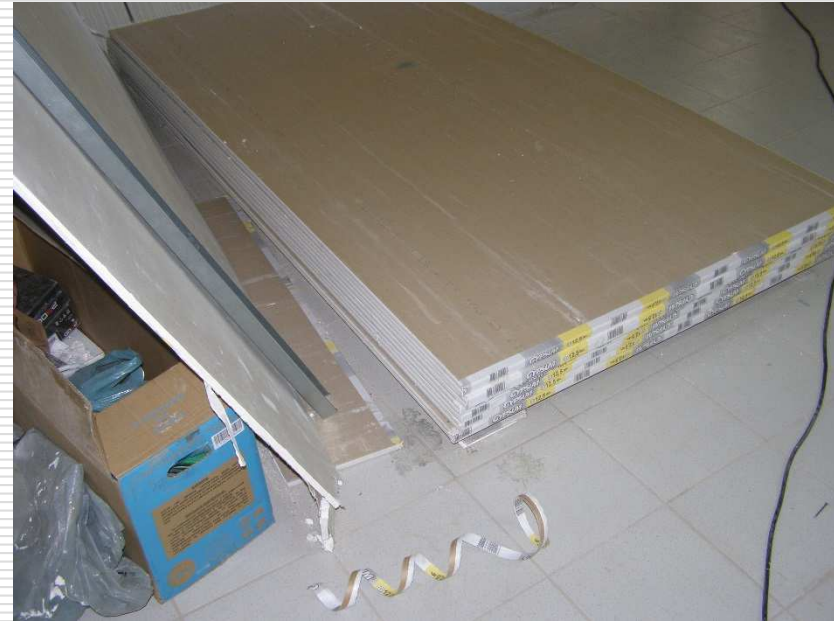
Placas da parede de gesso acartonado
