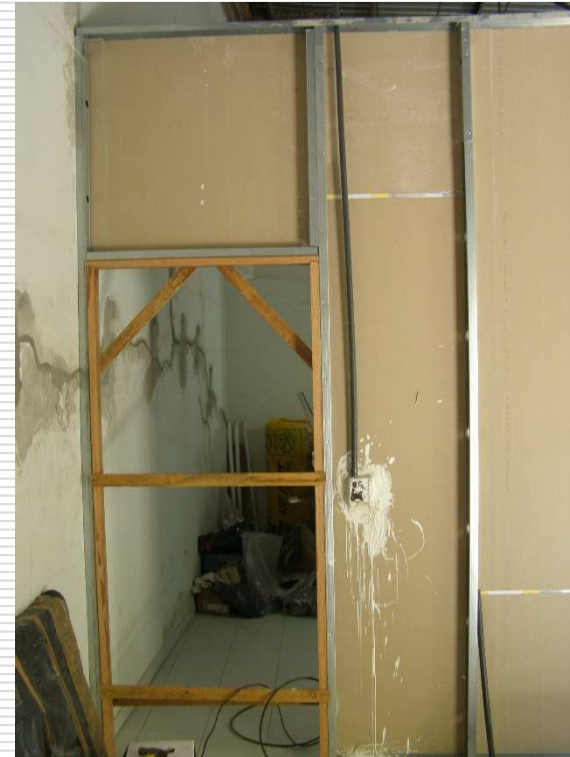
Portal de madeira para assentamento da porta e guarnição
