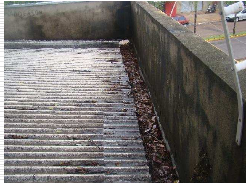
Detalhe do acúmulo de folhas e galhos nas calhas do prédio
