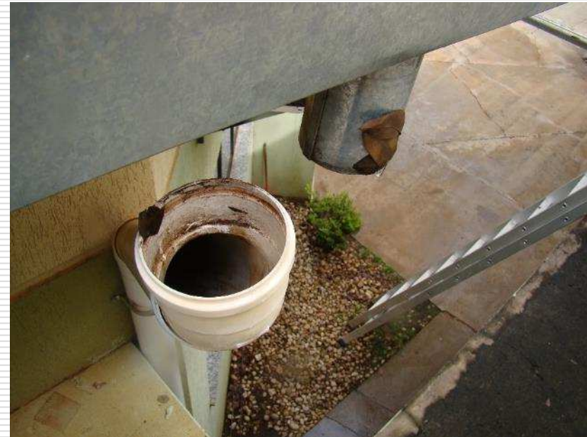
Detalhe do acúmulo de folhas e galhos nas calhas do prédio. Detalhe do tubo de queda danificado
