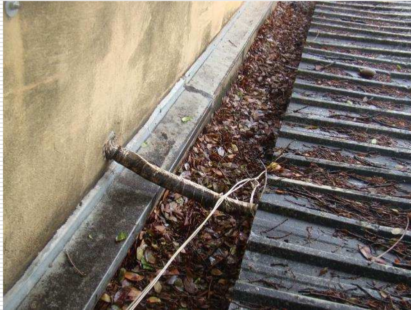
Detalhe do acúmulo de folhas e galhos nas calhas do prédio
