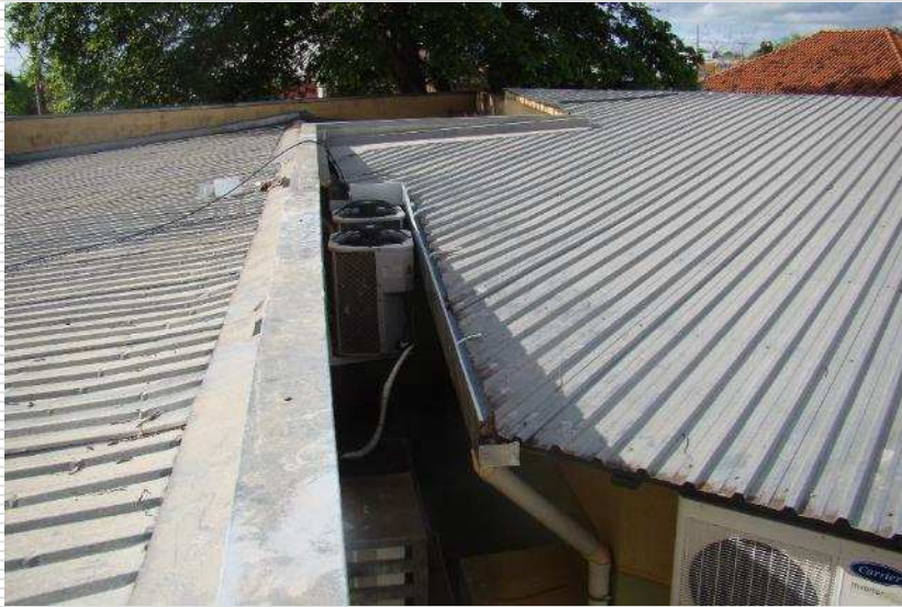
Detalhe geral do telhado com novas calhas e rufos instalados
