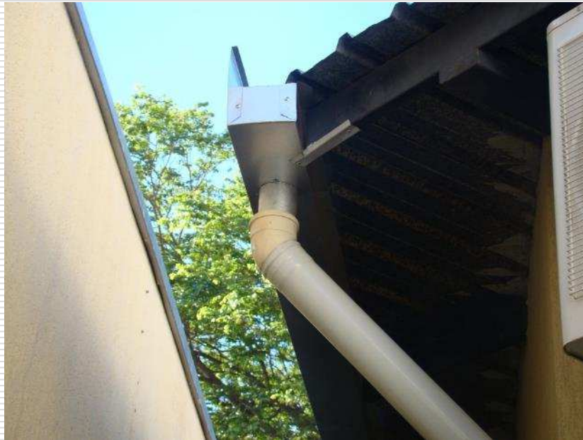
Detalhe dos novos tubos de queda instalados
