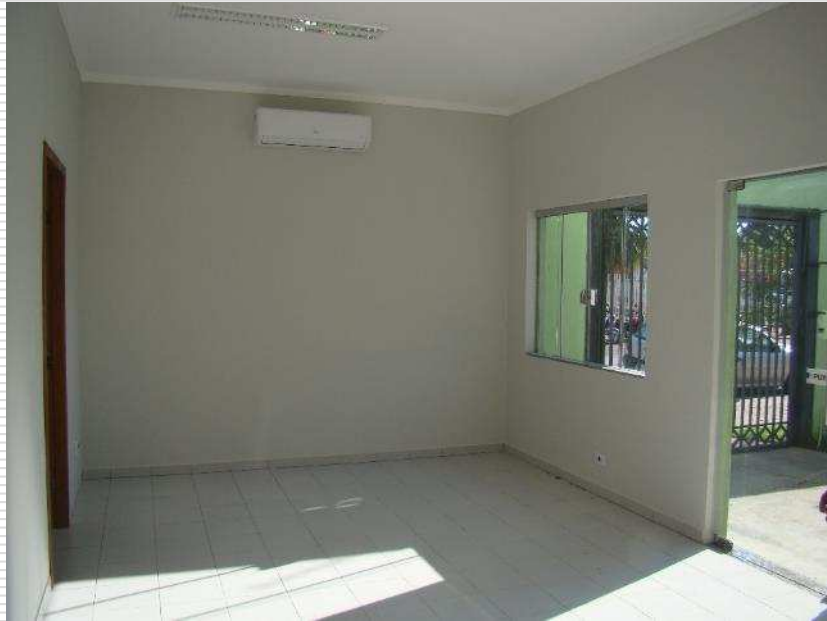
Detalhe do interior da sala de espera na conciliação
