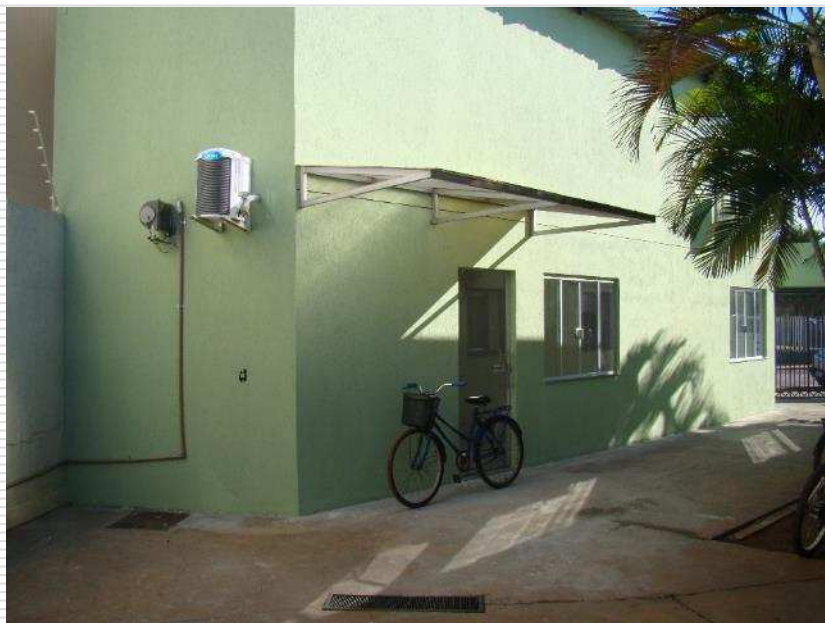
Vista geral da reforma
