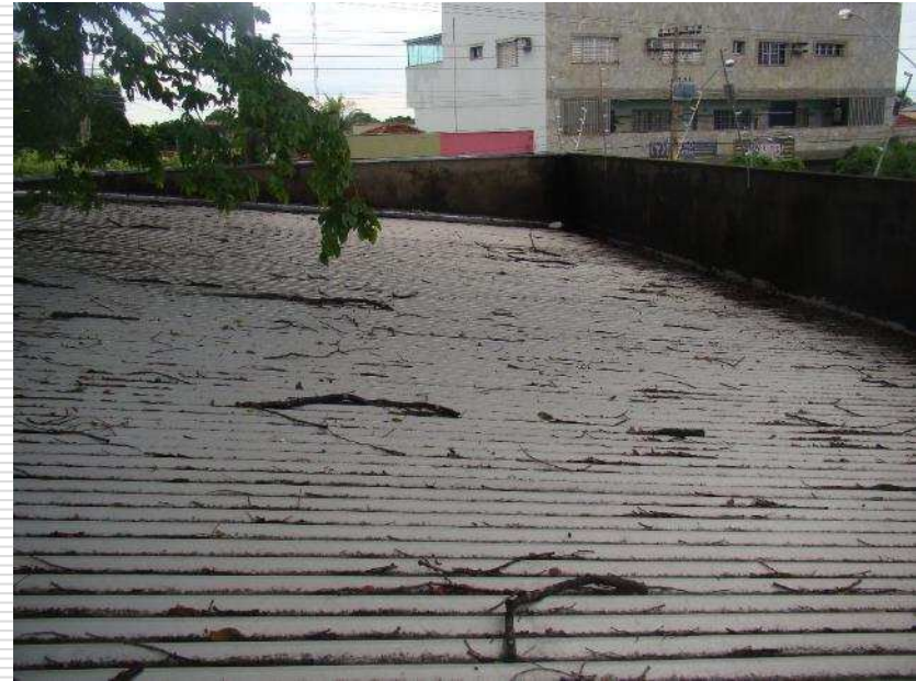
Detalhe das folhas e galhos acumulados em diversos pontos do Foro Trabalhista
