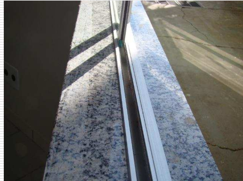
Detalhe geral das esquadrias de alumínio e peitoril em granito
