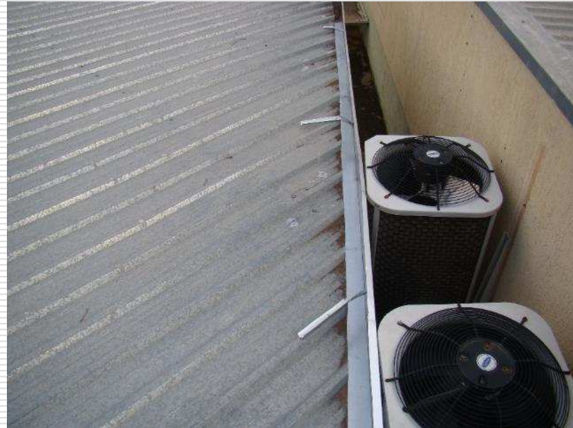
Detalhe das novas calhas e limpeza de todo telhado
