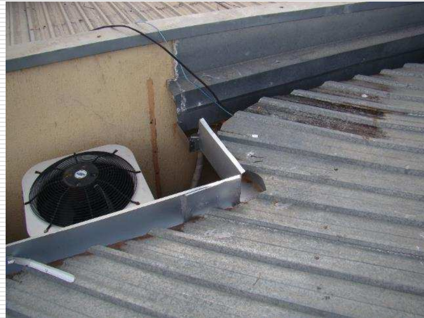
Detalhe da limpeza do telhado com novas calhas instaladas
