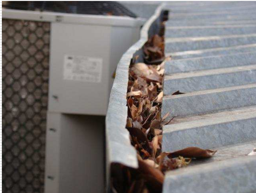
Detalhe do acúmulo de folhas e galhos nas calhas do prédio. Detalhe do tubo de queda danificado
