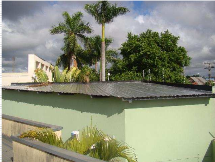
Detalhe do telhado com aplicação de manta isolante aluminizada
