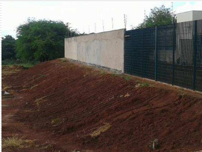
Talude do aterro já compactado
