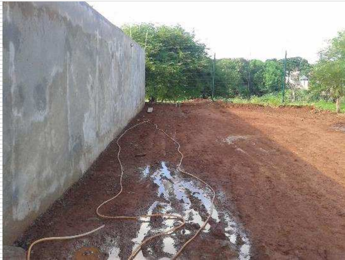
Emboço do muro lateral direito.
