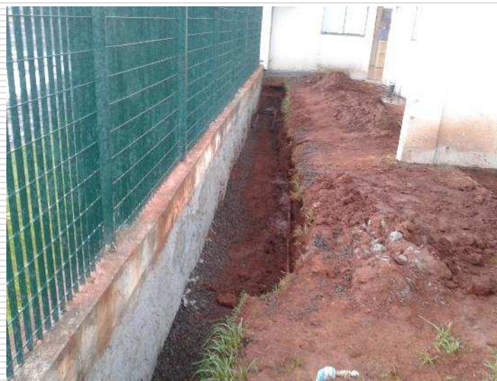
Escavação manual de valas
