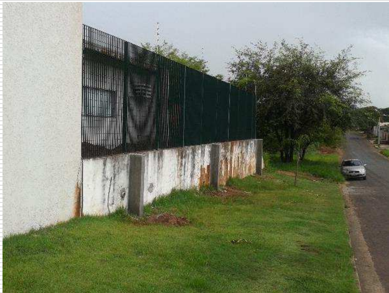
Detalhe dos reforços do muro de arrimo, vista da região externa e da região interna.
