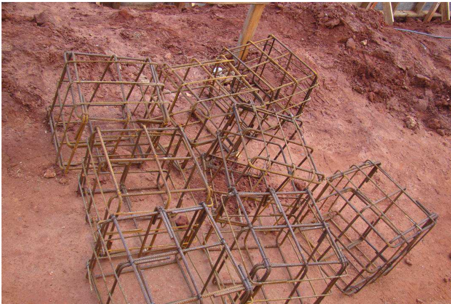
Detalhes dos blocos de transição das salas de subestação e do grupo gerador e das formas dos baldrames com arranque dos pilares.
