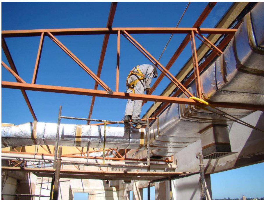
Detalhes da retirada de telhas de aço e o agulhamento das terças. Detalhe da retirada de piso de Paviflex e da sua regularização.
