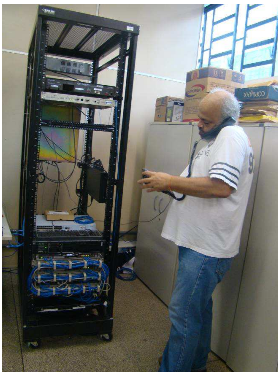
Desinstalação, remanejamento de endereço e reinstalação de uma central telefônica phillips (SOPHO iS3030)
