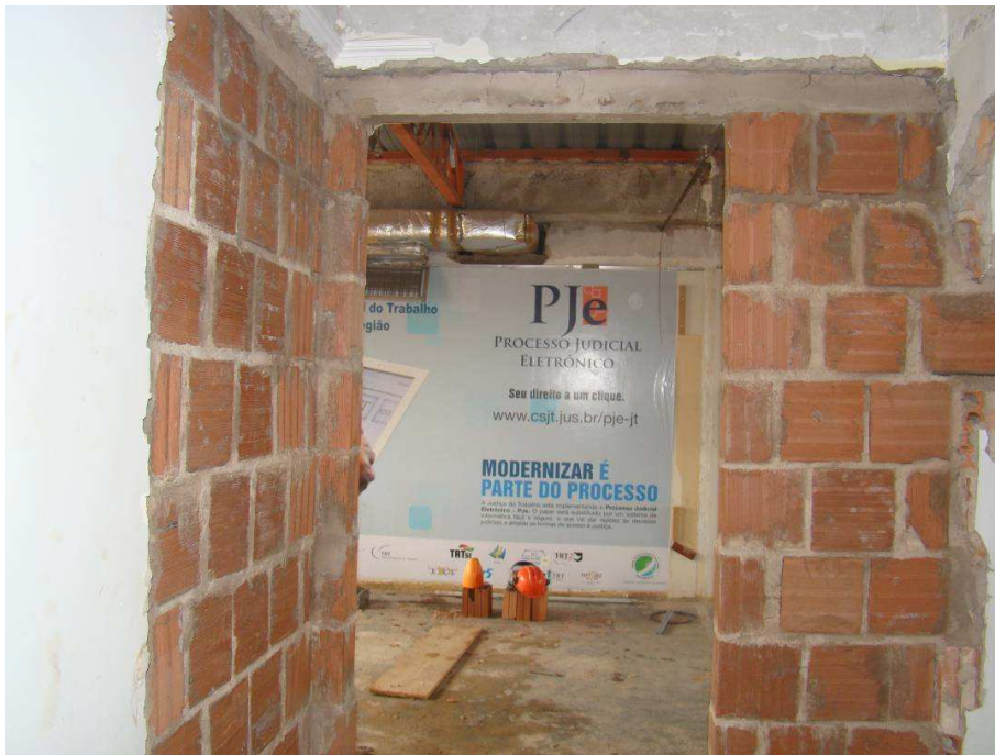
Detalhes de parede de alvenaria e vergas no 8º pavimento e fechamento de alvenaria nas fachadas
