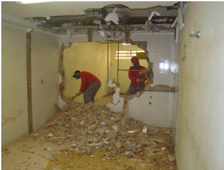
Detalhes da demolição de alvenaria e da demolição de forro de gesso
