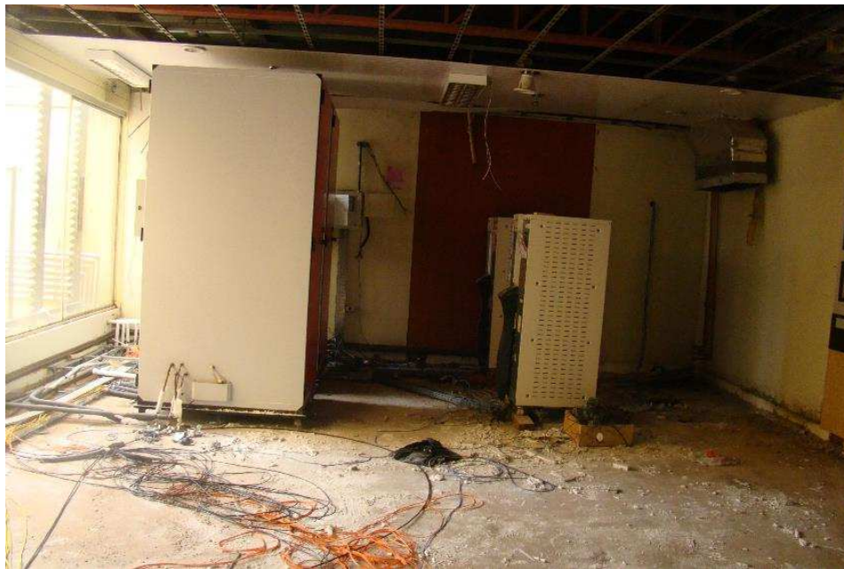
Detalhes do início da retirada do forro e transferência do “Modular Safe” com os “Nobreak” – Situação sem o forro, o piso elevado e os equipamentos de informática
