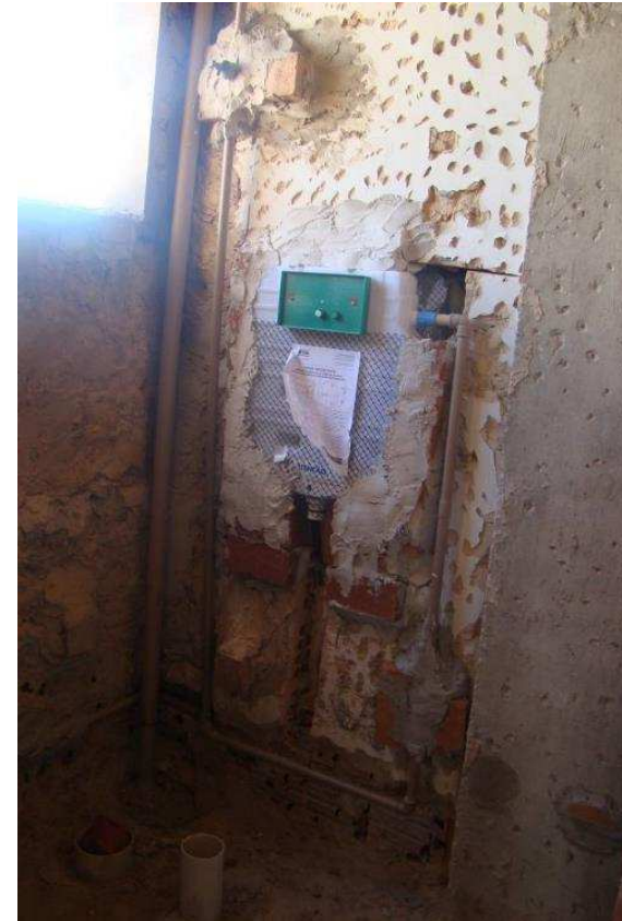
Detalhe da prumada de água pluvial das sacadas (sul) e esquema de água fria dos banheiros c/ cx de descarga embutida
