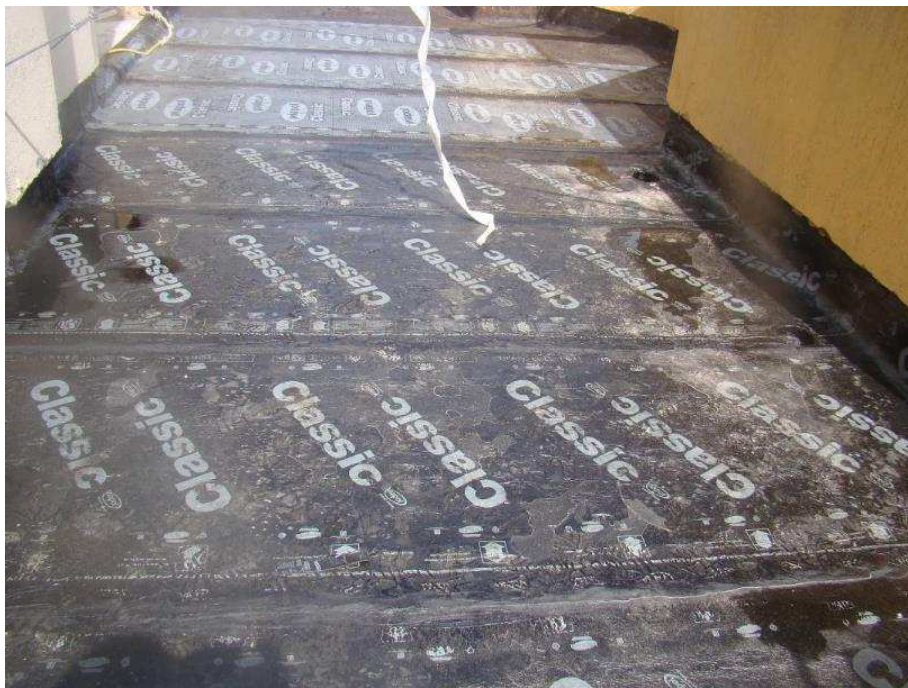
Detalhe da manta asfáltica 4,00mm aplicada na cobertura.
