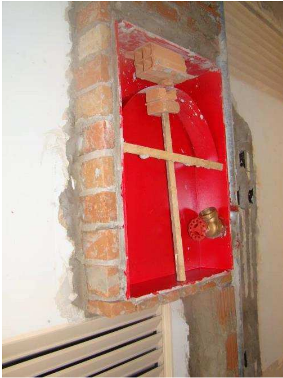
Detalhe das caixas de hidrantes com o registro instalado
