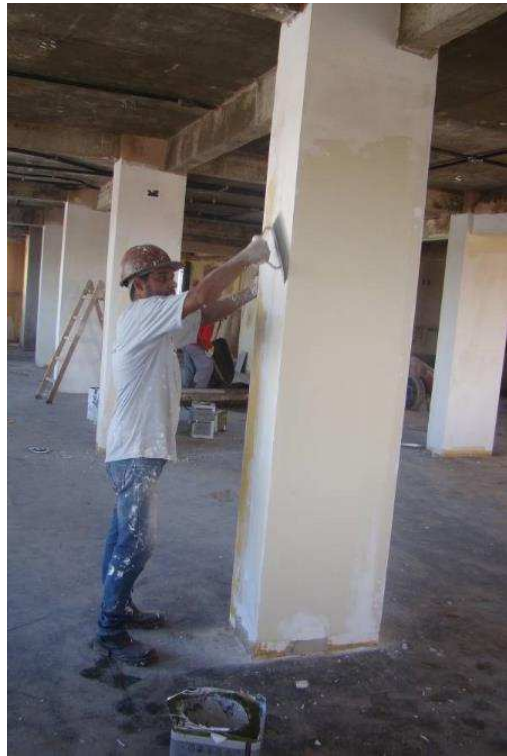
Detalhe do emassamento interno e aplicação externa de Permacyrl com balancim
