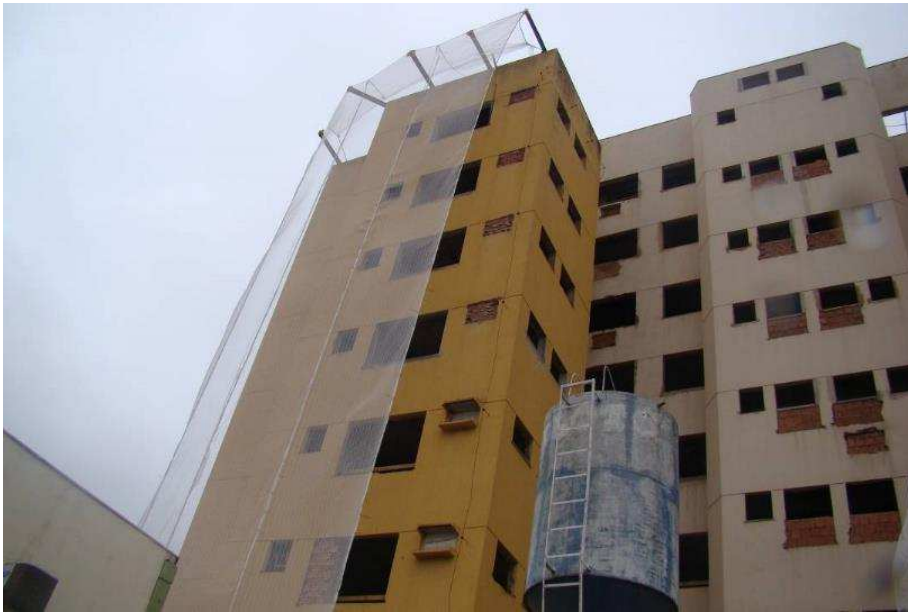
Montagem de proteção de fachada em tela e bandejas
