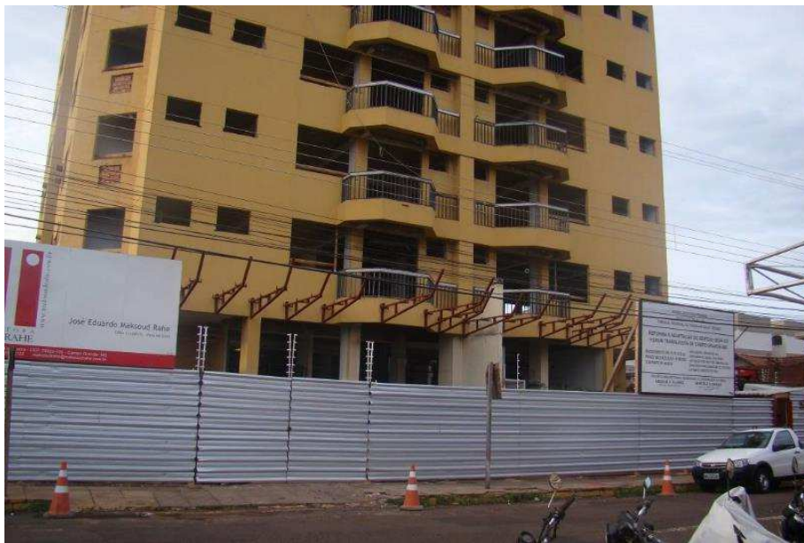
Montagem de bandejas, balacim fachadeiro e sistema de transporte vertical externo
