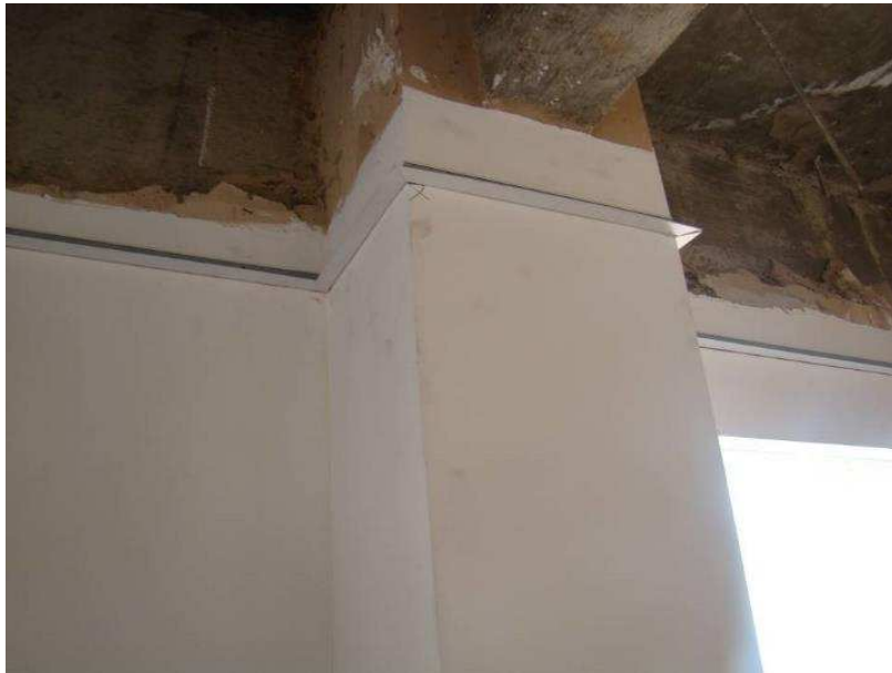
Detalhes da Estrutura do forro de alumínio (ambientes de trabalho) e das juntas paulistas (tabicas) em banheiros.
