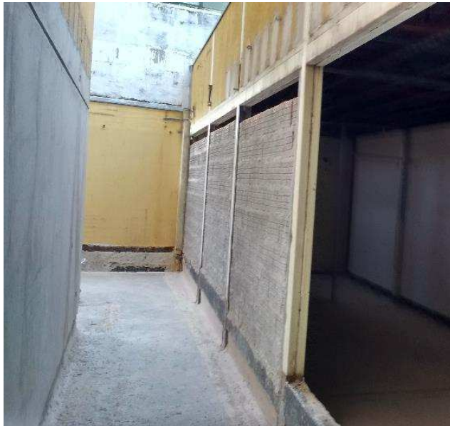
Detalhes do chapisco externo da sala dos servidores e da instalação de peitoril de granito
