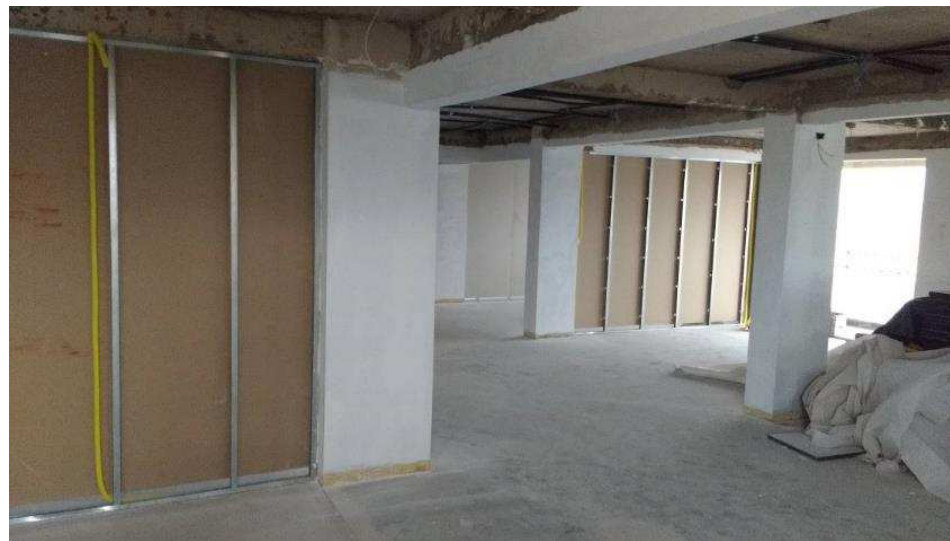
Detalhes da estrutura metálica da escada de acesso as audiências e das paredes de gesso acartonado
