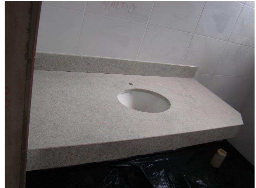
Detalhe da caixa d'água de embutir e da bancada com a cuba, em banheiro com toda tubulações de esgoto e água fria executadas
