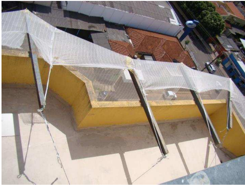
Detalhes da estrutura para a tela de proteção de fachada, bandeja e o elevador de cremalheira.
