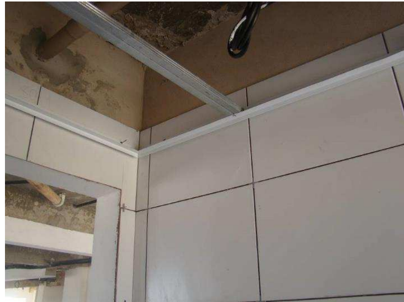
Detalhes da Estrutura do forro de alumínio (ambientes de trabalho) e das juntas paulistas (tabicas) em banheiros.
