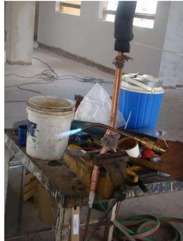
Detalhes da tubulação frigorífica sendo testada com pressão, e a Soldagem Oxicombustível com temperatura de 3480°C (com oxigênio) e utilizando nitrogênio nas tubulações para evitar fuligem.
