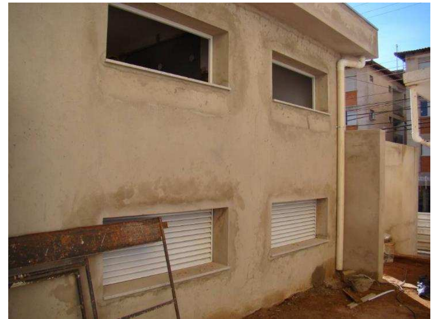
Detalhes das portas venezianas de alumínio e das janelas venezianas em alumínio do anexo. Detalhe da grade interna de proteção dos elementos energizados.
