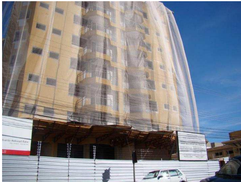
Detalhes da bandeja com a tela de proteção na fachada norte e leste carregamento de entulho em caminhão bota-fora
