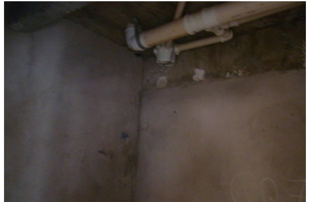
Detalhe da prumada de água pluvial e da instalação provisória de drenagem, em seguida detalhe das tubulações de esgoto
