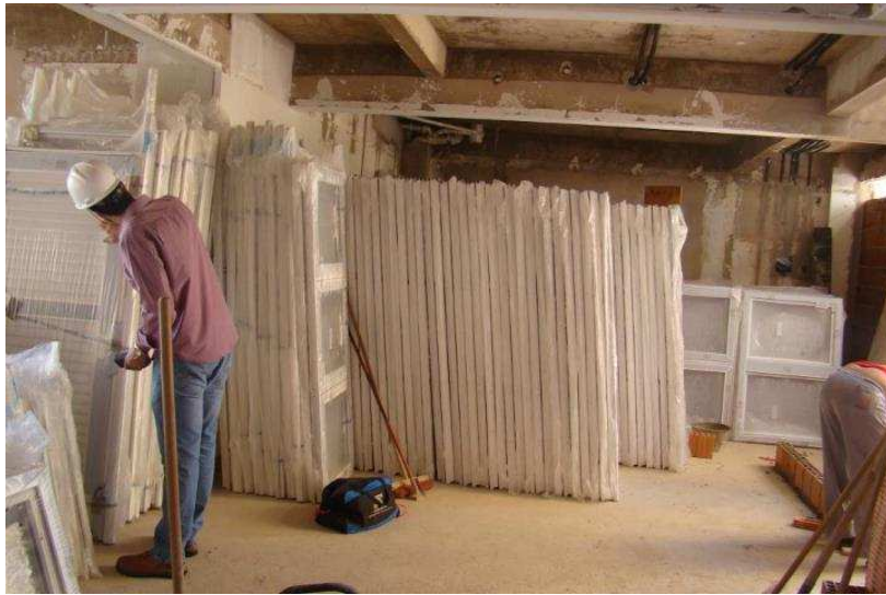
Conferência das esquadrias de PVC pela Fiscalização.
