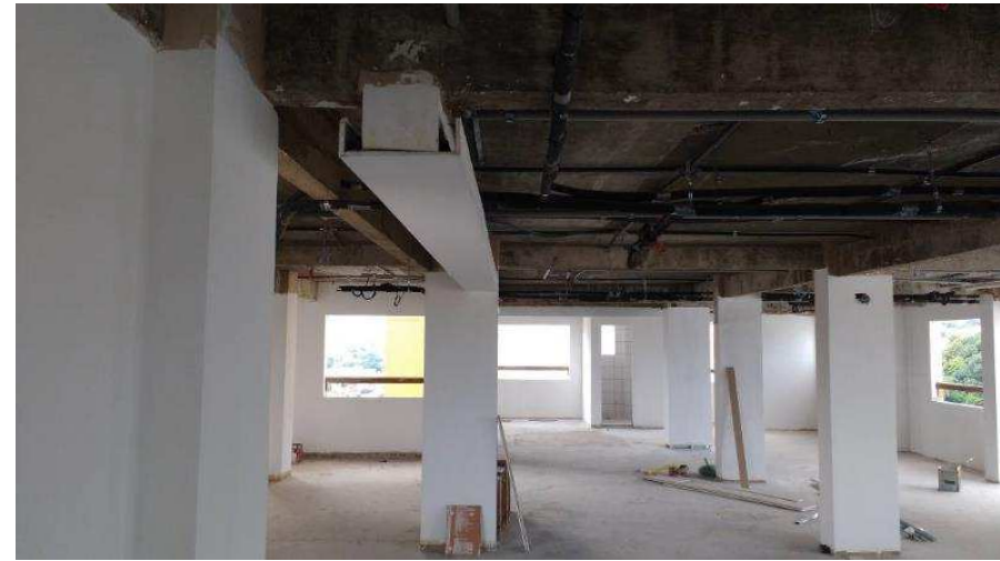
Detalhes da fixação do pilar metálico no chumbador e do “encaixotamento” de vigas no gesso acartonado.
