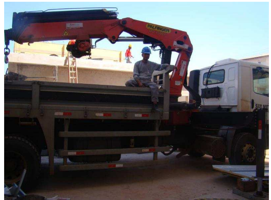
Detalhe de carga mecanizada (telhas)
