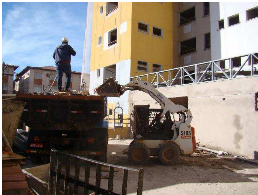
Carregamento de entulho (bobcat) em caminhão bota-fora
