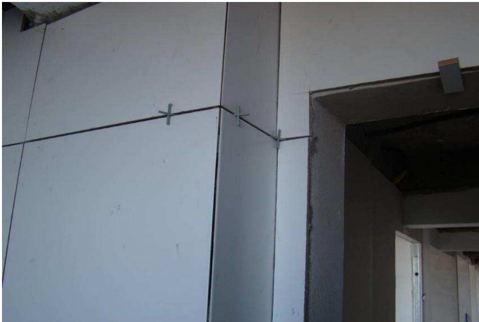
Detalhes do revestimento cerâmico nos banheiros (com espaçadores) e do rejuntamento (parcial).
