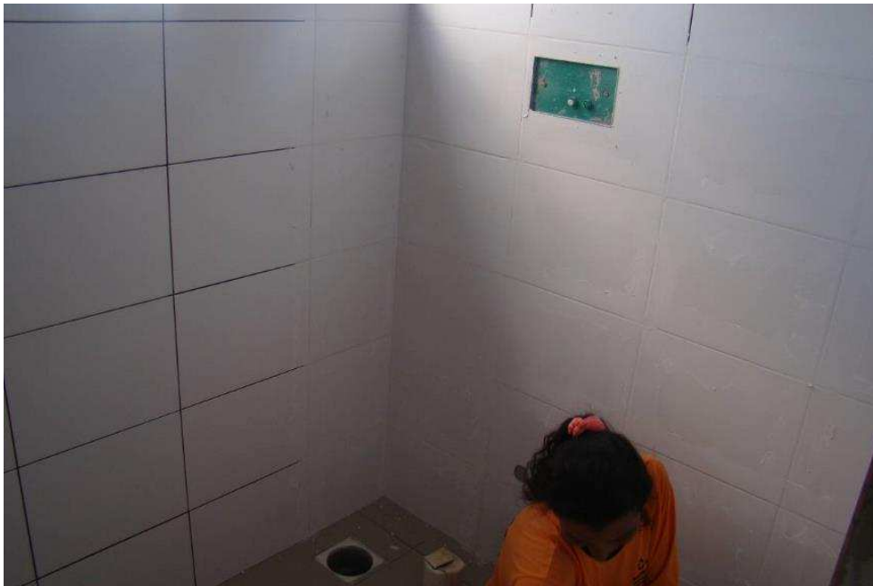
Detalhe da caixa d'água de embutir e da bancada com a cuba, em banheiro com toda tubulações de esgoto e água fria executadas
