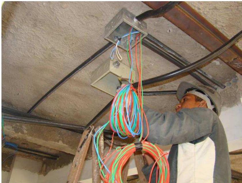
Detalhes da instalação de caixas de passagens e dos quadros de distribuição já montados e etiquetados
