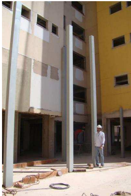
Detalhes da estrutura metálica da escada de acesso as audiências e das paredes de gesso acartonado
