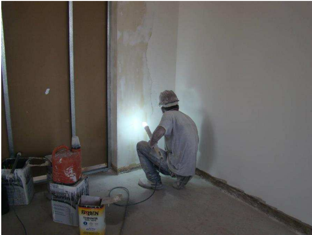
Detalhe do emassamento interno
