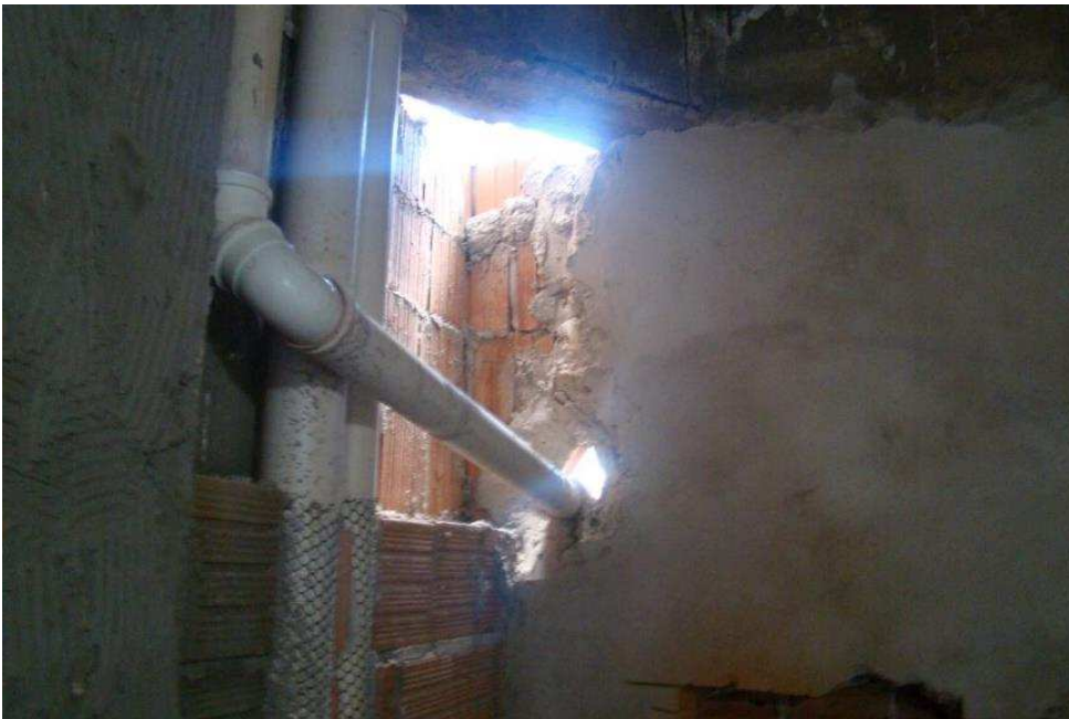
Detalhe da prumada de água pluvial e da instalação provisória de drenagem, em seguida detalhe das tubulações de esgoto
