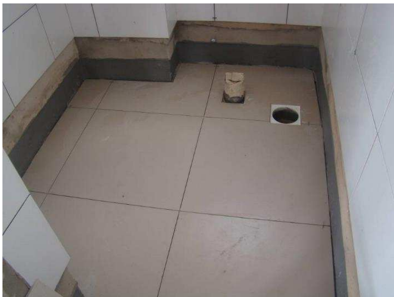
Detalhes do piso porcelanato nos banheiros e seu rejuntamento
