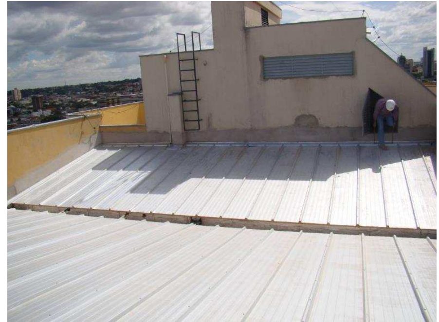
Detalhes da Cobertura com telha termoacustica em aço trapezoidal, rufo, calhas, chapim e estrutura metálica com fundo anti-corrosivo
