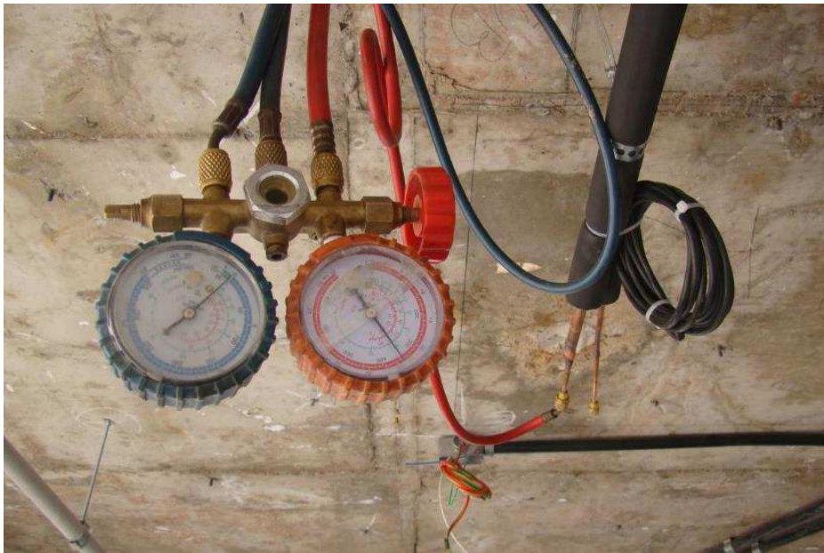
Detalhes da tubulação frigorífica sendo testada com pressão, e a Soldagem Oxicombustível com temperatura de 3480°C (com oxigênio) e utilizando nitrogênio nas tubulações para evitar fuligem.
