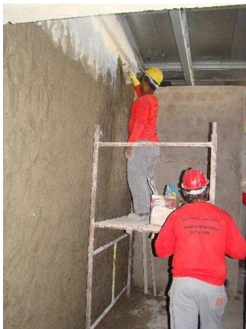
Detalhes do revestimento cerâmico na copa central (6º pavimento) e do emboçamento no acesso da escada ao 1º pavimento.
