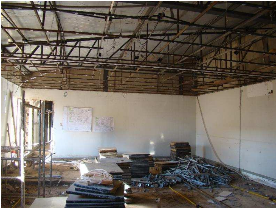
Retirada do forro e do piso elevado na antiga sala de curso
