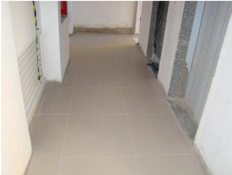
Detalhes do piso porcelanato rejuntado na circulação dos elevadores e no refeitório dos servidores (6º pavimento)
