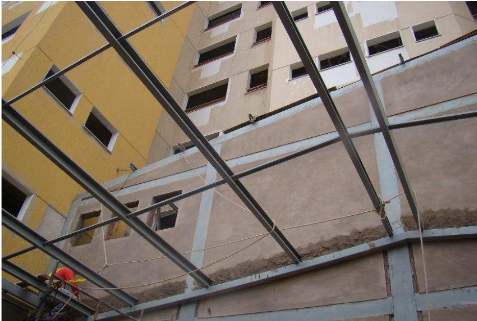
Detalhes da estrutura da Cobertura e das telha termoacústica em aço trapezoidal da sala de audiência do térreo
