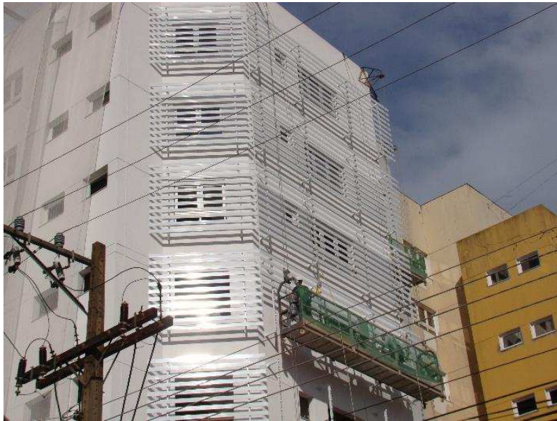
Detalhes do brise (sobre-fachada) na fachada oeste e a sua instalação
