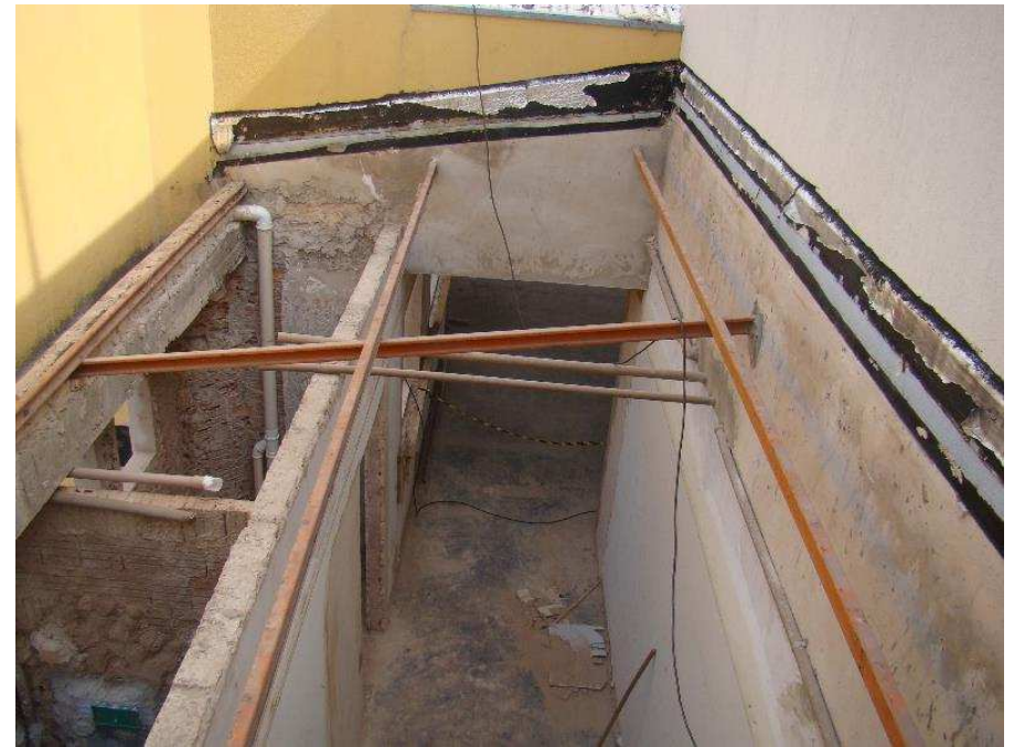
Detalhe da retirada de telha e de rufos
