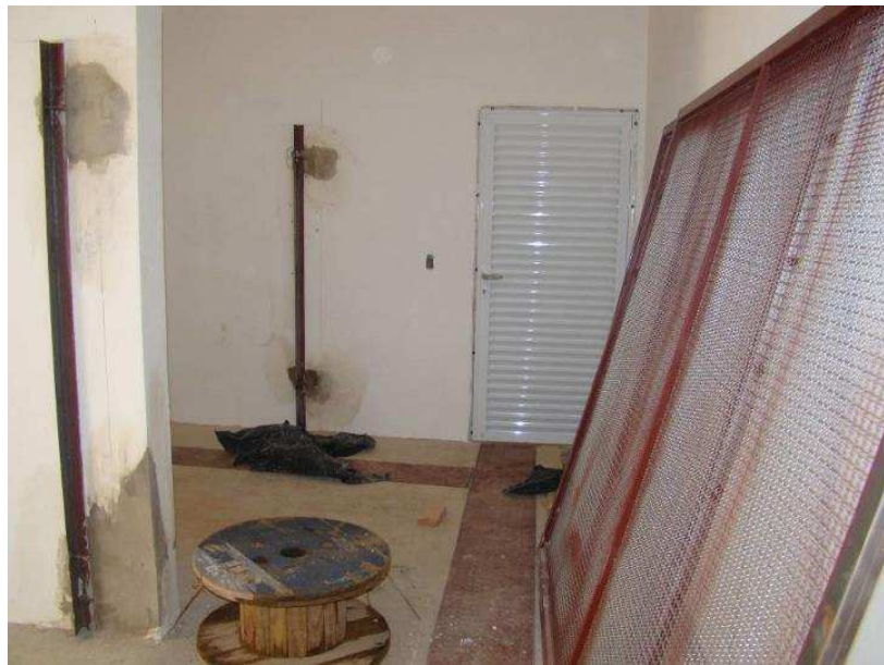
Detalhes das portas venezianas de alumínio e das janelas venezianas em alumínio na subestação. Detalhe da grade interna de proteção dos elementos energizados.
