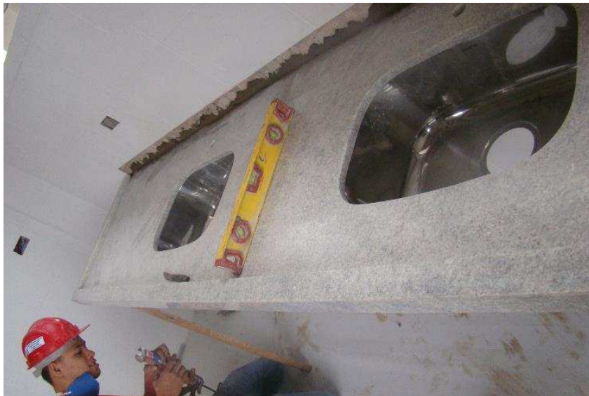
Detalhes das bancadas da copa central (6º pavimento) e dos banheiros já com as suas cubas
