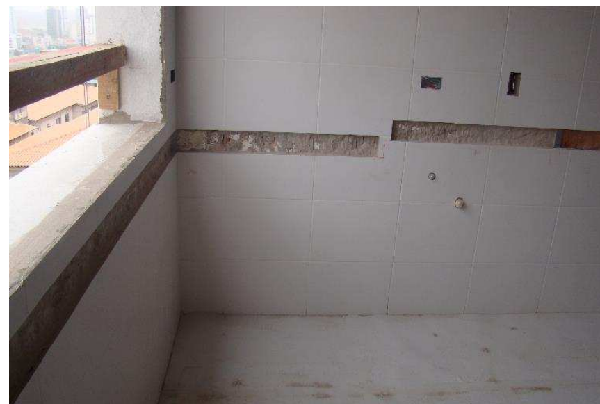
Detalhes do revestimento cerâmico na copa central (6º pavimento) e do emboçamento no acesso da escada ao 1º pavimento.
