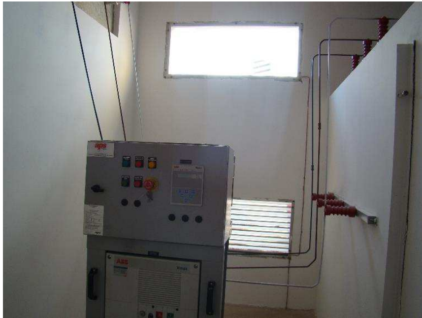
Detalhes da entrada em média tensão (ligação de disjuntor) e do painel geral em baixa tensão
