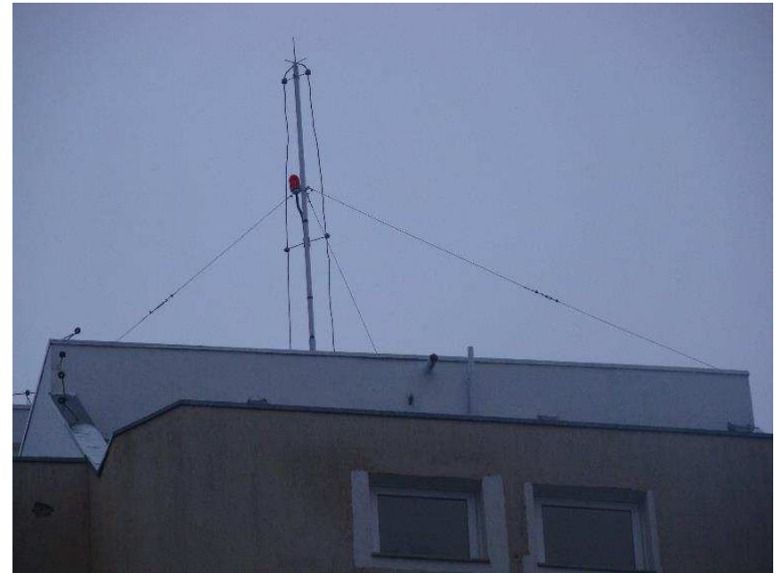
Detalhes do perfil de alumínio do SPDA e o para-raios com a iluminação de alerta e tirantes de contraventamento.
