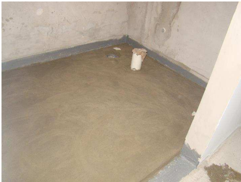
Detalhes da proteção mecânica dos banheiros e da manta asfáltica nas sacadas (área técnica).
