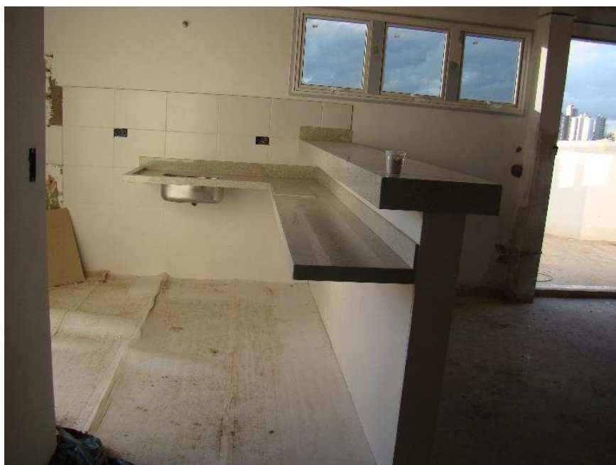
Detalhes de cuba em inox e de cuba em louça em bancada de granito aqualux.
