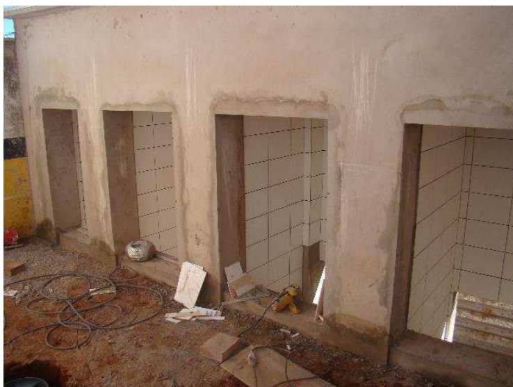
Detalhes do requadro, do azulejo na lixeira e do desempenamento da parede externa da sala de audiência do térreo
