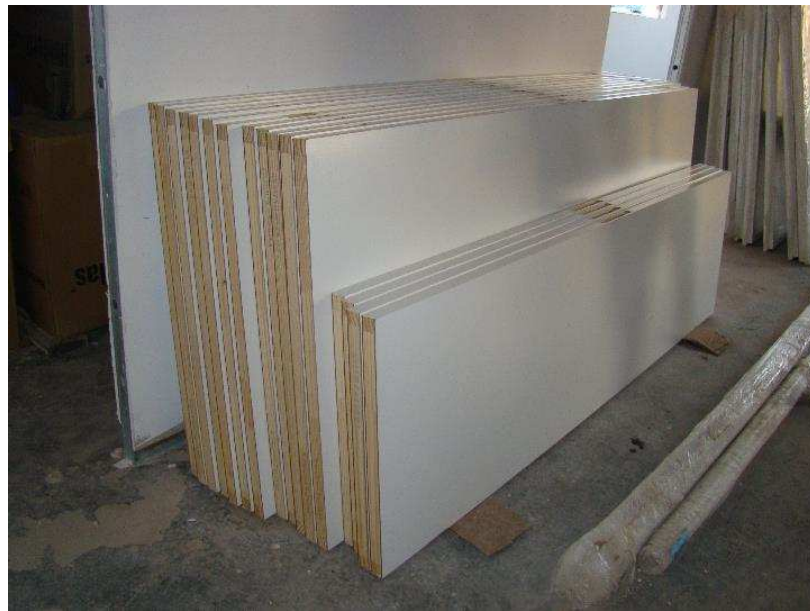
Detalhes das portas internas e dos “shafts” semi-ocas em virola revestidas com chapas em melamínico.
