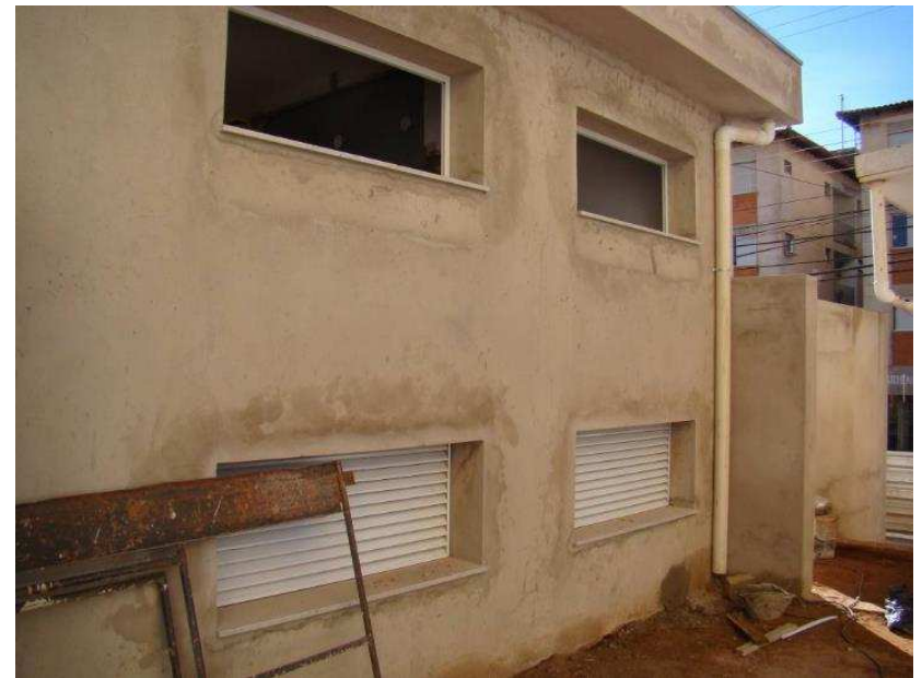
Detalhes das portas venezianas de alumínio e das janelas venezianas em alumínio na subestação. Detalhe da grade interna de proteção dos elementos energizados.
