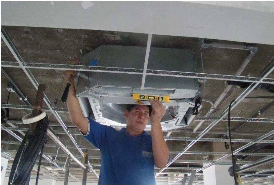
Detalhe da montagem da evaporadora e das compressoras nas áreas técnicas
