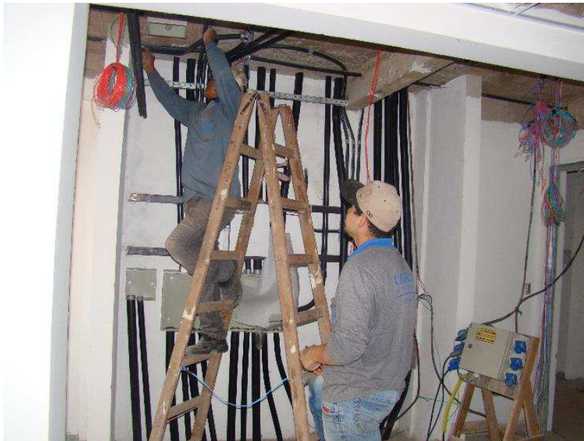
Detalhes da montagem dos quadros e tubulações do "shaft"
