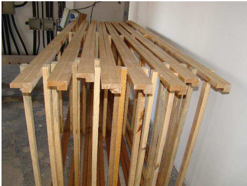
Detalhes dos batentes montados para as portas das divisórias em gesso acartonado e do batente instalado em parede de alvenaria
