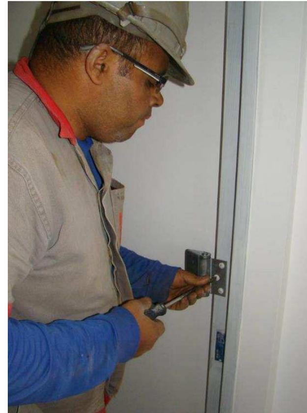
Detalhes das esquadrias de pvc na fachada oeste e instalação de dobradiças nas portas metálicas de incêndio
