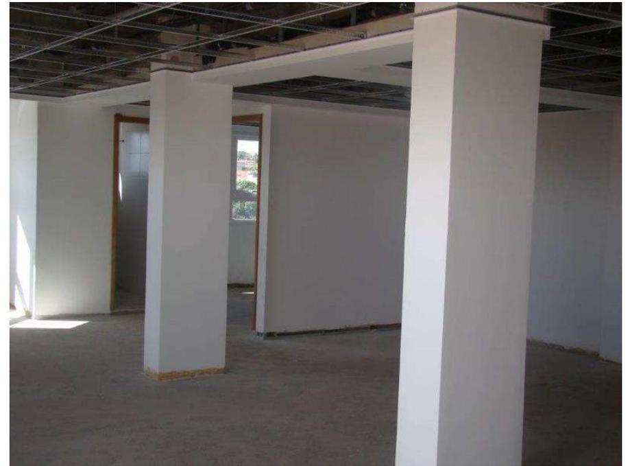
Detalhe das paredes de gesso e as vigas esquadrejadas com acartonado para dar acabamento no forro metálico.
