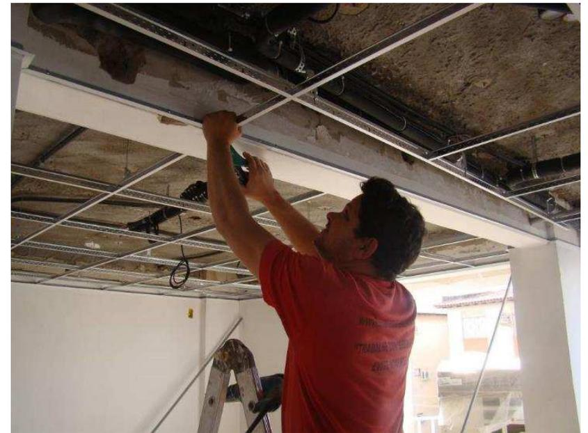
Detalhes da instalação da estrutura do forro (conferindo o nível e fixando os perfis)
