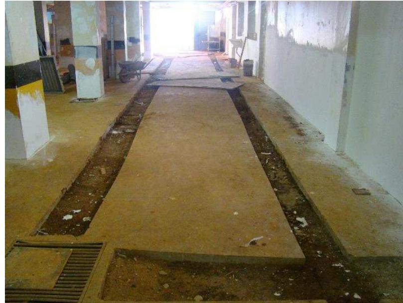
Escavação e reaterro de valas para redes de águas pluviais e esgoto
