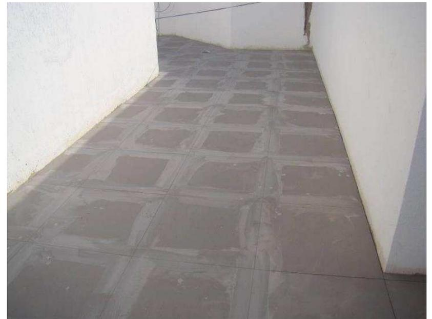
Detalhes dos assentamento de porcelanato interno e do rejuntamento do porcelanato antiderrapante
