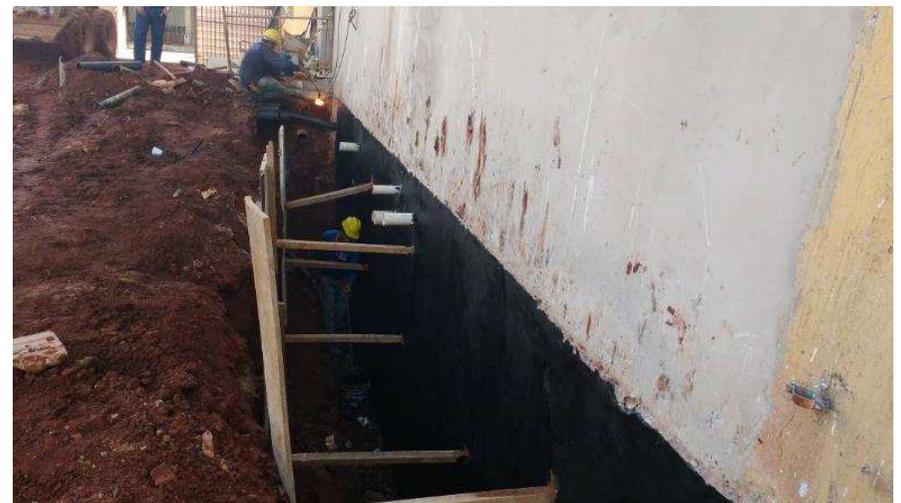
Detalhes da impermeabilização do sistema de rede de águas pluviais e esgoto com manta asfáltica
