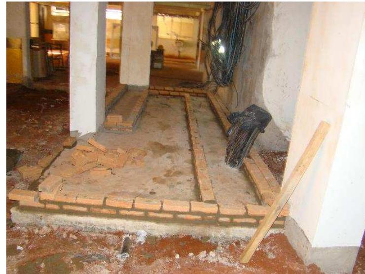
Detalhe da infraestrutura da subestação chegando no subsolo e a base dos painéis elétricos.
