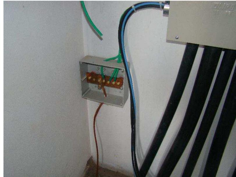
Detalhes da fita de alumínio do sistema de aterramento (prumada e cintamento), ao lado aterramento dos quadros nos "shafts"
