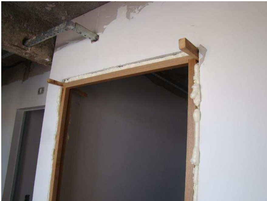
Detalhes de portas das salas convencionais, ao lados os batentes instalados
