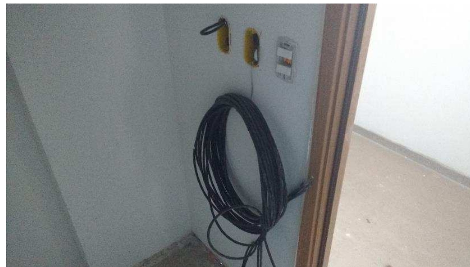
Detalhes da fiação de controle de acesso instalado, em porta corta-fogo e porta de madeira.
