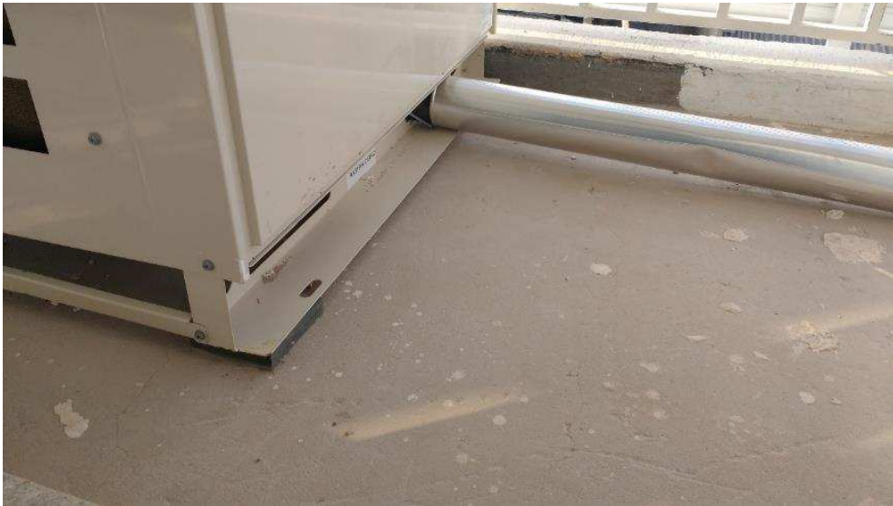
Detalhes do calço em neoprene da condensadora e proteção das linhas refrigerantes.
