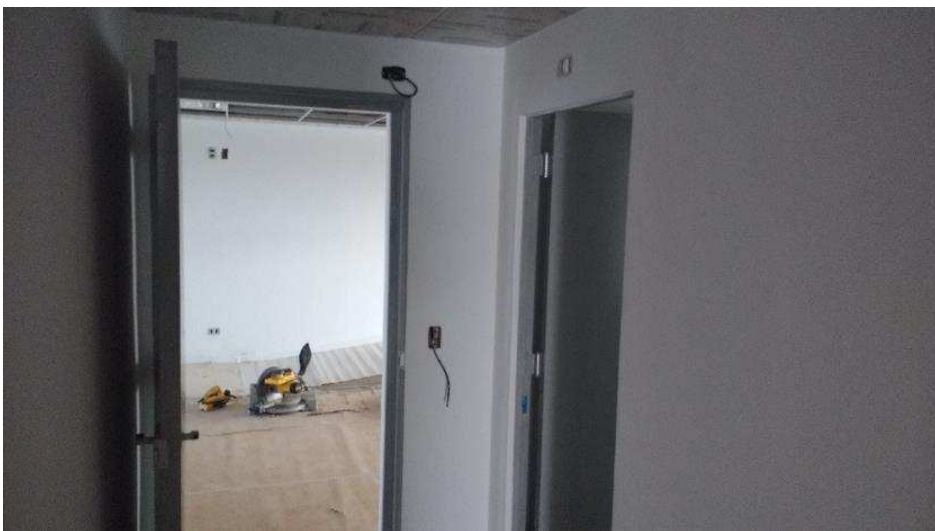
Detalhes da fiação de controle de acesso instalado, em porta corta-fogo e porta de madeira.
