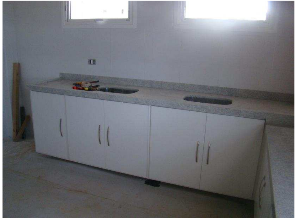
Detalhes da bancada de banheiro e bancada da copa do 6º pavimentos, com armário em MDF.
