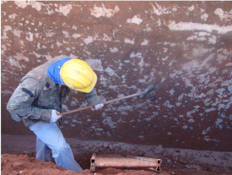
Detalhes da impermeabilização do sistema de rede de águas pluviais e esgoto com manta asfáltica
