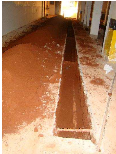
Escavação e reaterro de valas para redes de águas pluviais e esgoto
