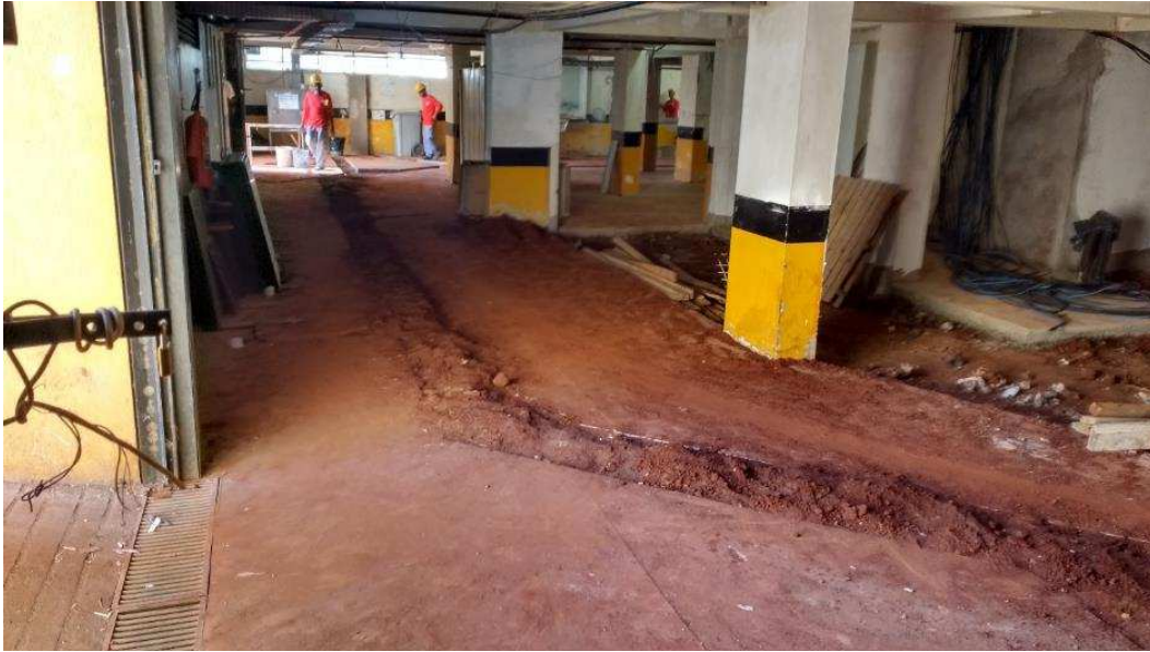
Detalhe de escavação e reaterro no subsolo.
