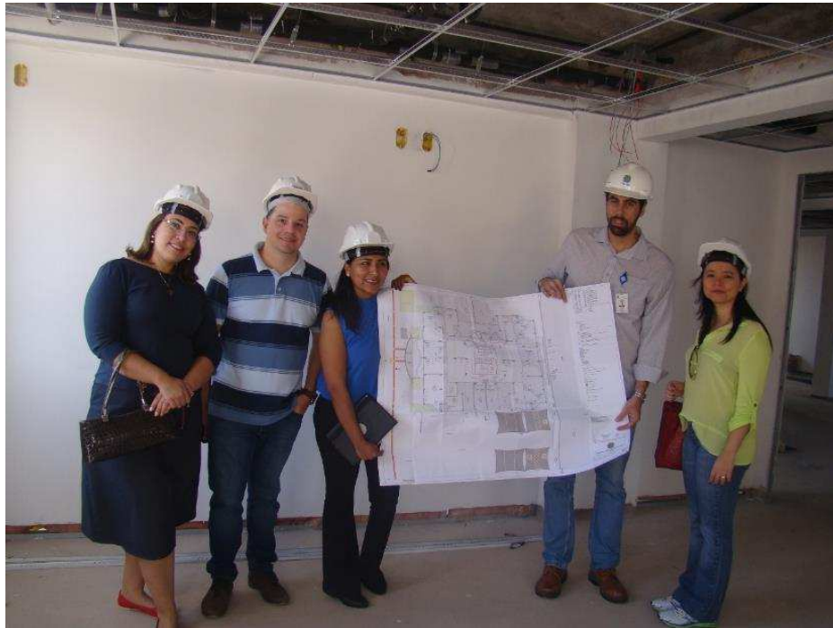
Vistoria do espaço destinado à OAB no 1º pavimento.
