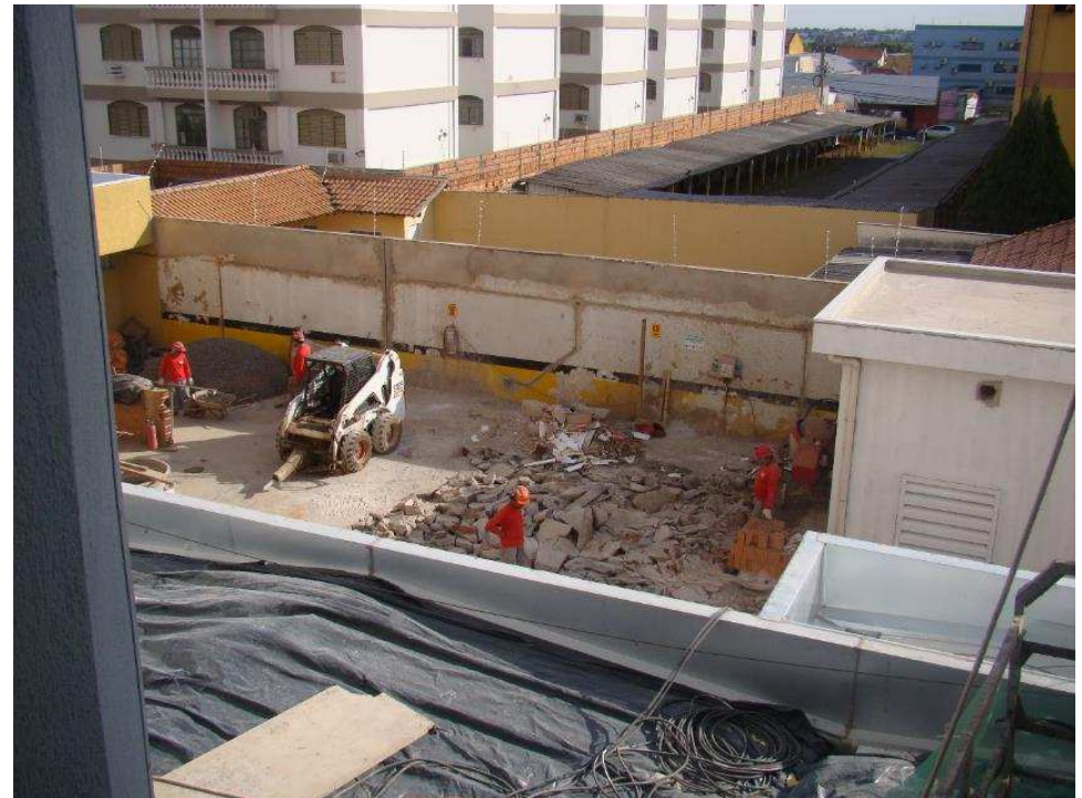
Demolição de piso de concreto na área externa (pátio).
