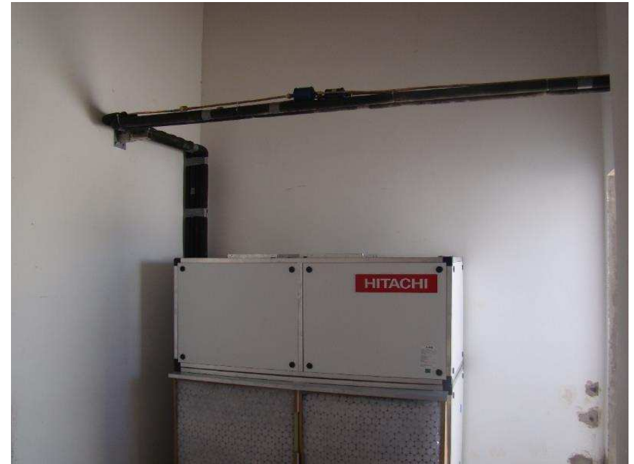
Detalhe dos dutos do Plenário (cobertura) e equipamento evaporadora instalada na sala técnica da cobertura.
