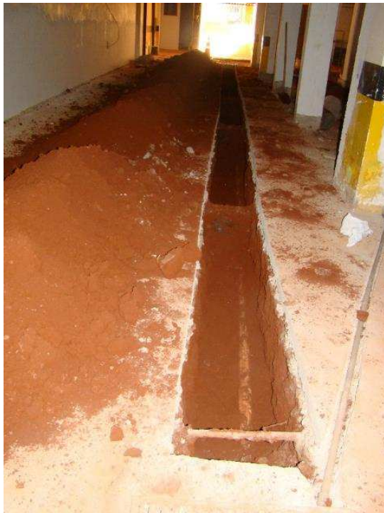
Demolição de piso de concreto no subsolo.
