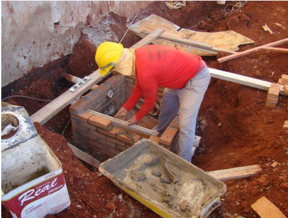
Detalhe de caixa de inspeção de esgoto no pátio externo.
