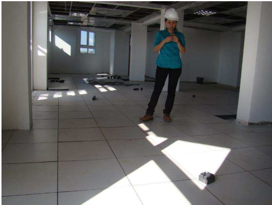
Detalhes do piso elevado instalado e de porcelanato externo antiderrapante
