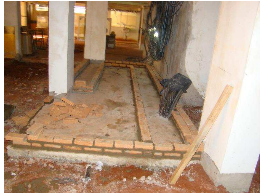
Detalhe da execução da sala técnica no subsolo, com tubulações na prumada (shaft).
