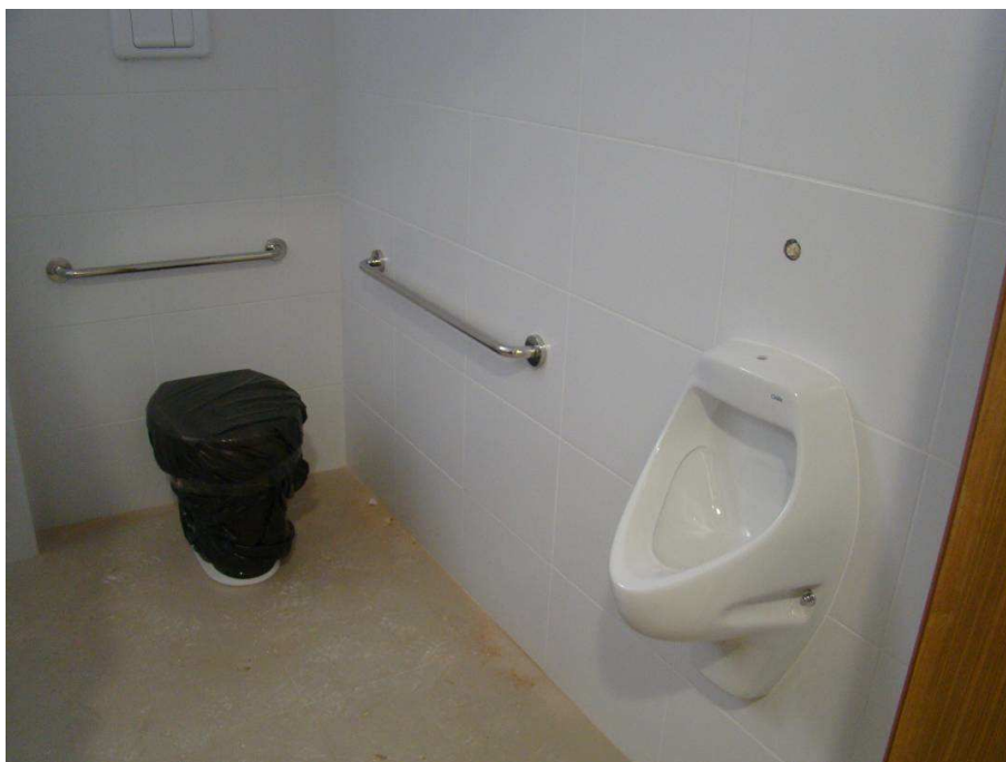
Detalhes dos banheiros acessíveis com as louças e barras instaladas
