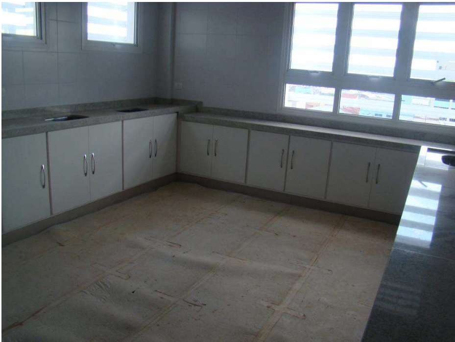
Detalhes dos armários em MDF com bancadas e cubas.
