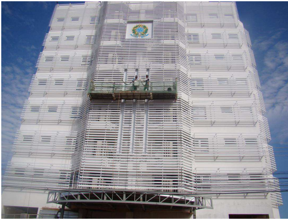
Detalhe da instalação de sobrefachada da fachada e o rejuntamento do alumínio composto com silicone
