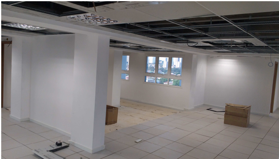
Detalhe do piso elevado instalado no 7º e 8º pavimento
