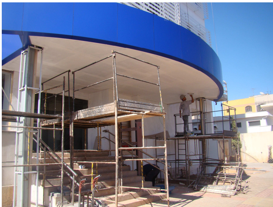
Detalhe da instalação do forro de gesso acartonado e do forro metálico na sala técnica
