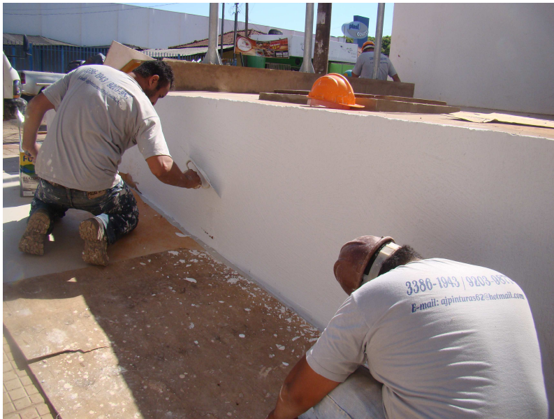
Detalhes da pintura externa do pavilhão e dos retoques finais
