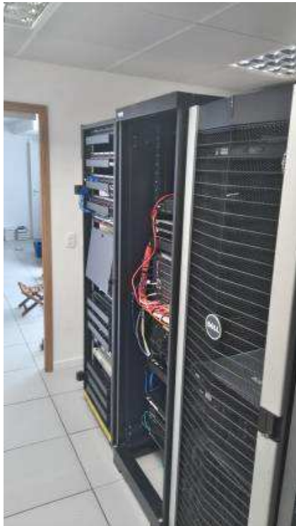
Detalhes dos racks instalados na sala de TI. Na vista do fundo, está reinstalado a central telefônica de PABX.
