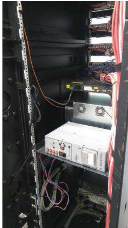
Detalhes dos racks instalados na sala de TI. Na vista do fundo, está reinstalado a central telefônica de PABX.
