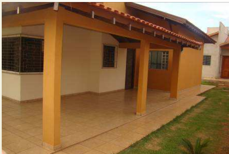
Detalhe do alojamento dos funcionários da obra
