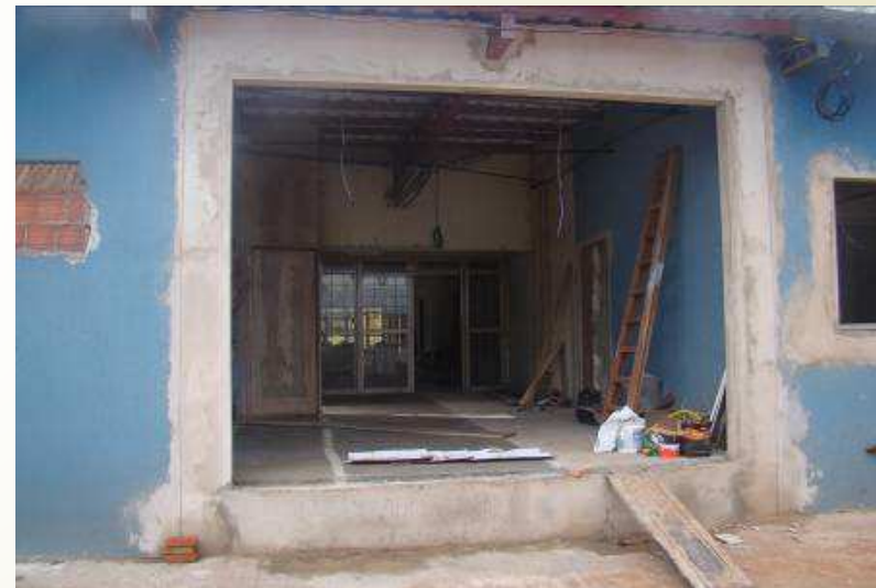
Detalhe da sala de espera coberta e com todos os elementos estruturais concluídos.
