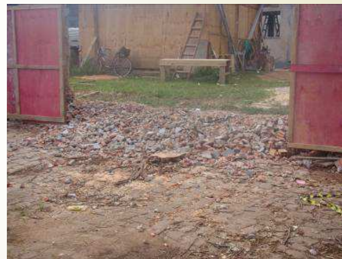
Detalhe da abertura do muro para a criação da entrada de serviço
