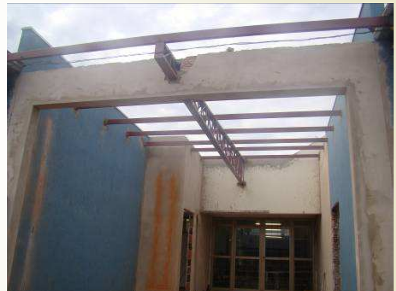
Detalhe da estrutura metálica em treliça
