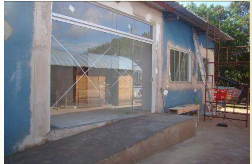
Detalhe da porta de vidro temperado colorido verde, espessura 10mm e jogo de ferragens
