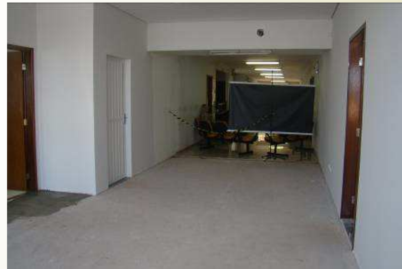
Detalhe do contrapiso
