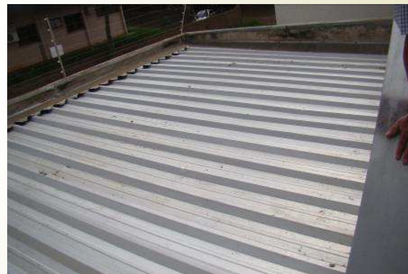
Detalhe do rufo e calha em chapa de aço galvanizado
