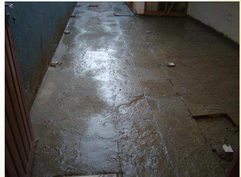
Detalhe da impermeabilização do corredor externo
