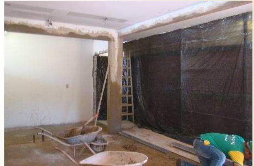
Detalhe da abertura dos vãos e de requadramento na portaria
