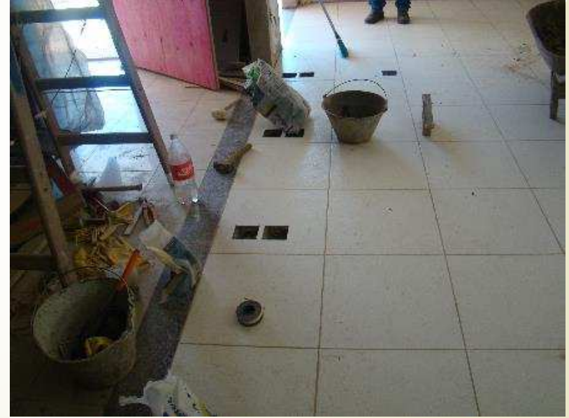
Detalhe do assentamento das soleiras de granito na portaria
