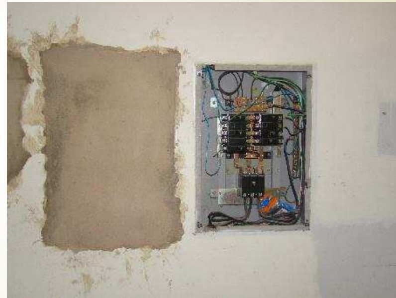
Detalhe da readequação dos circuitos no quadro de distribuição da portaria
