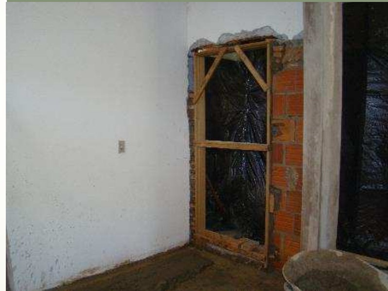
Detalhe do chumbamento e da vedação com alvenaria na portaria
