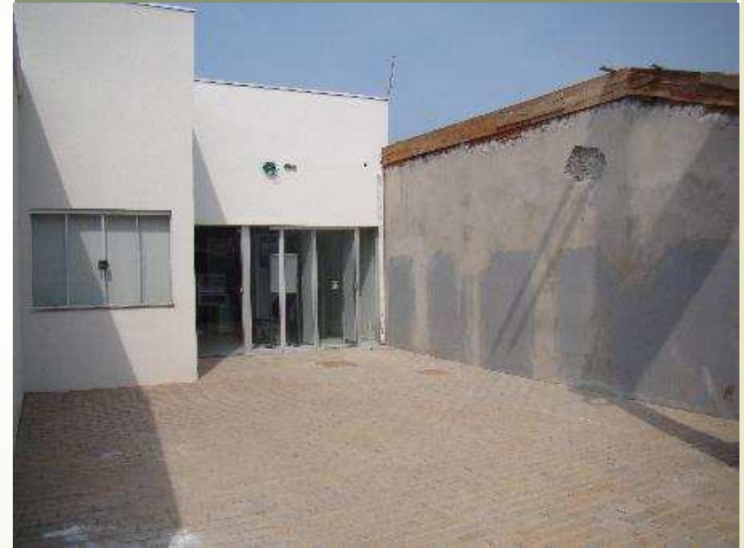
Detalhe pintura da fachada da central de atendimento ao cidadão
