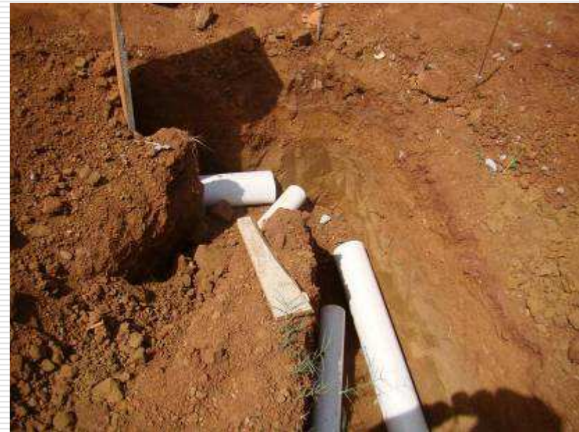
Detalhe da instalação de água fria e tubulação de água pluviais
