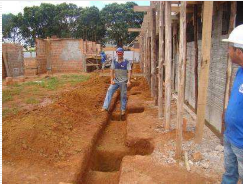
Detalhe da fundação do muro, alvenaria, vergas, e fôrmas dos pilares
