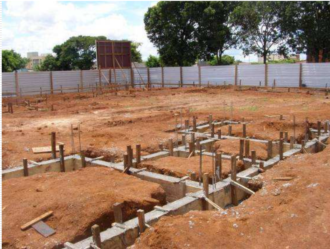
Vista dos baldrames concretados
