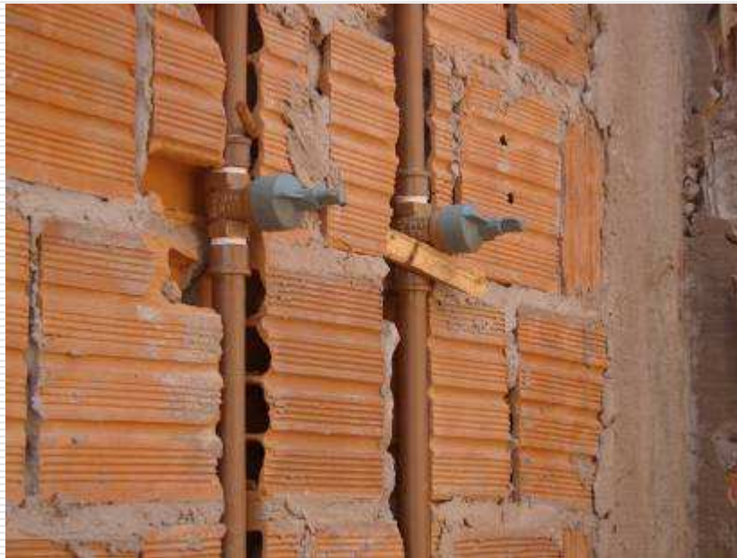
Detalhe da instalação de água fria e tubulação de água pluviais
