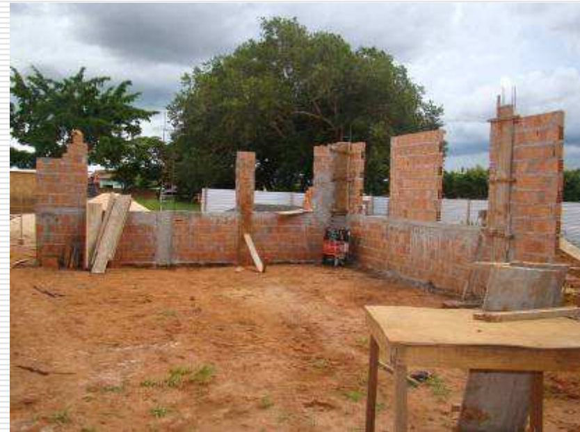
Detalhe da fundação do muro, alvenaria, vergas, e fôrmas dos pilares
