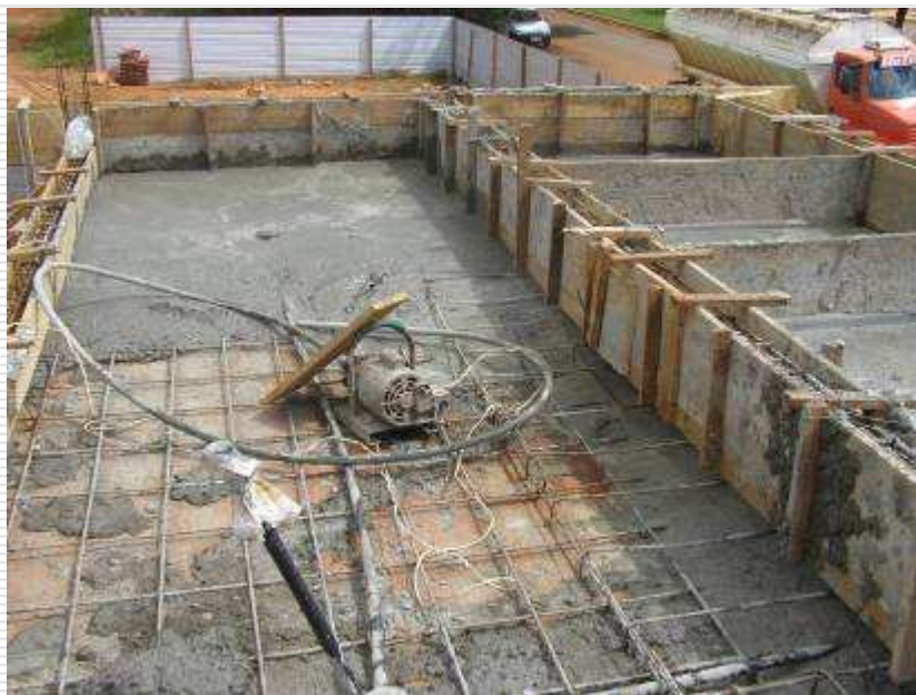
Detalhe da concretagem, formas e ferragens da estrutura do prédio
