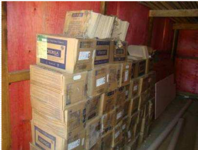
Pisos (cerâmico e porcelanato) armazenados
