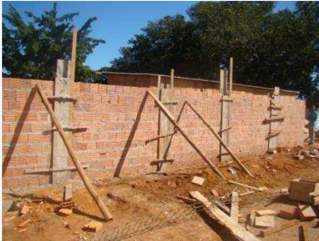
Execução do muro – alvenaria e pilares
