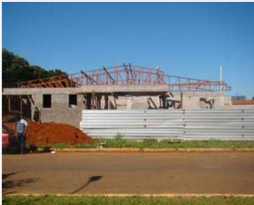
Detalhe da estrutura metálica de cobertura
