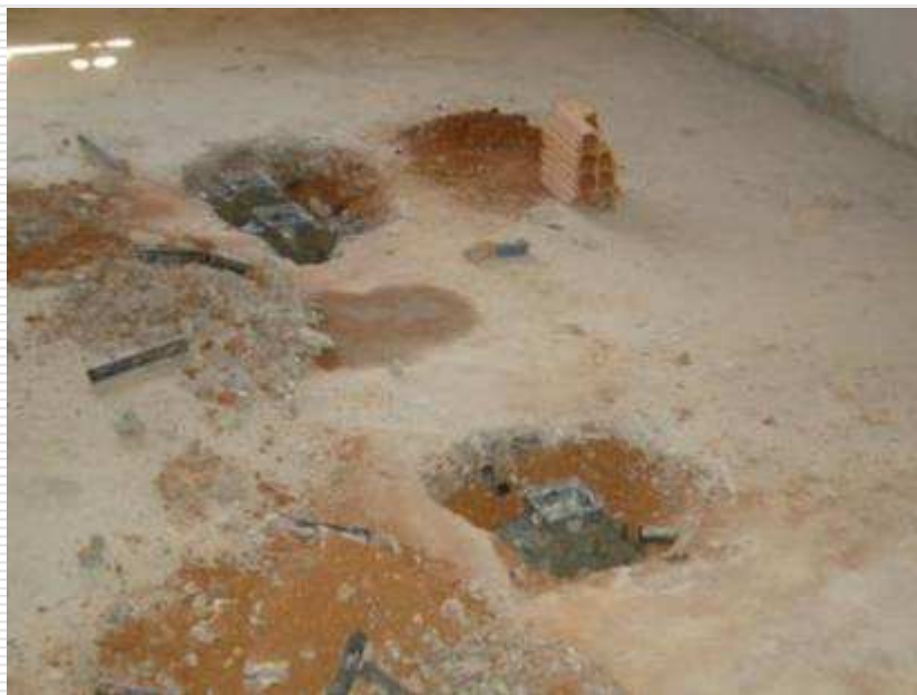
Instalações elétricas - detalhe dos eletrodutos e caixas assentadas no piso
