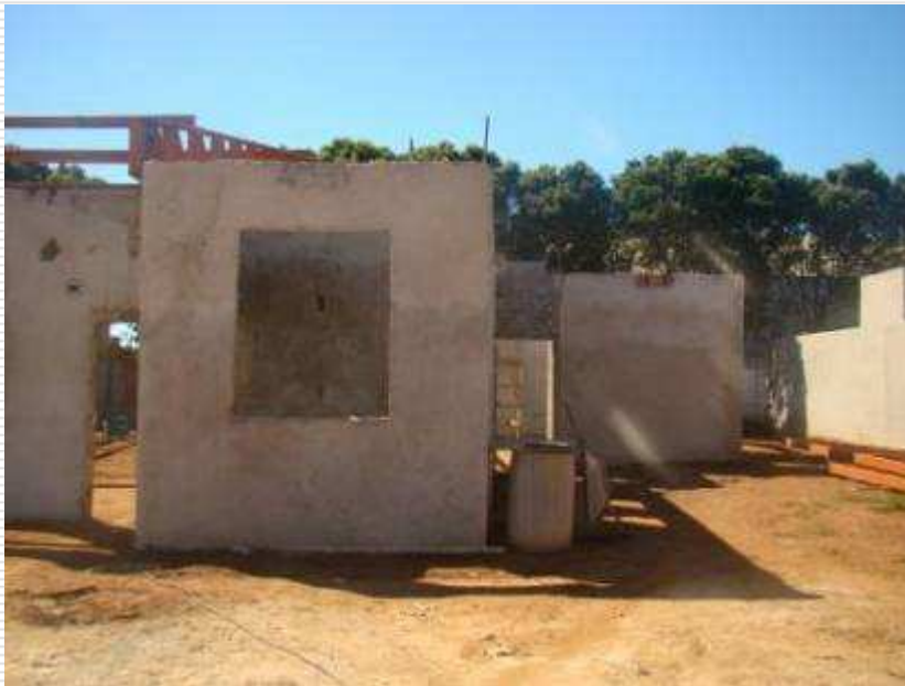
Detalhe do reboco em alvenaria
