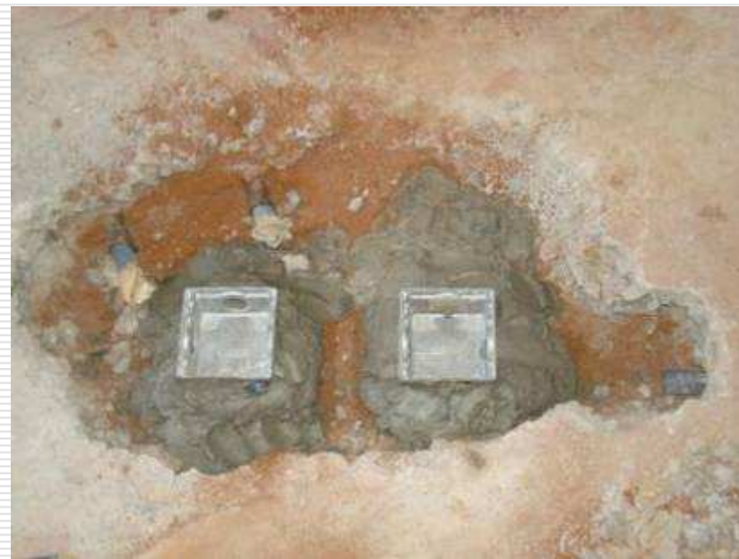
Instalações elétricas - detalhe dos eletrodutos e caixas assentadas no piso
