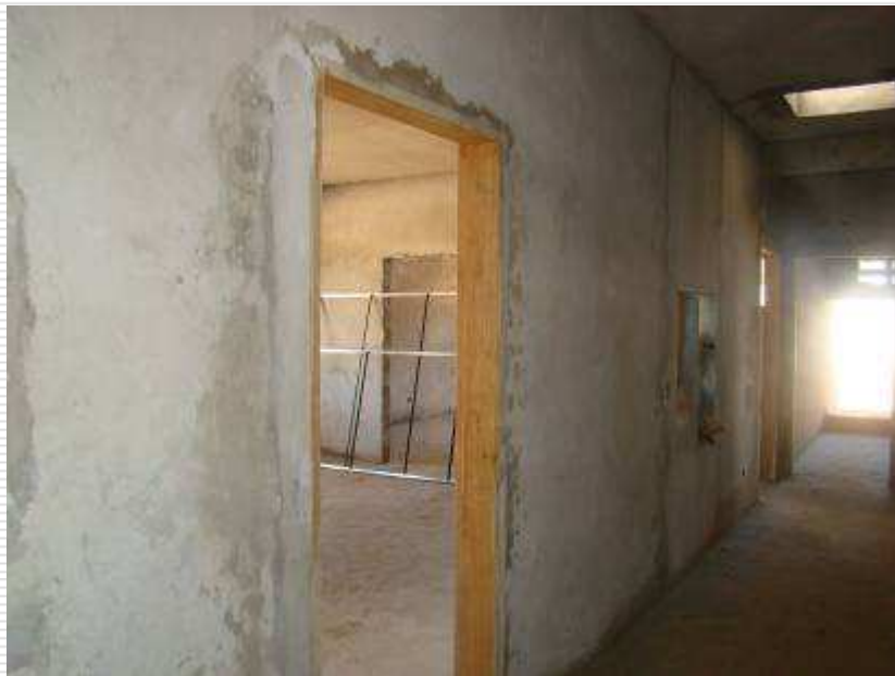
Detalhe do reboco em alvenaria
