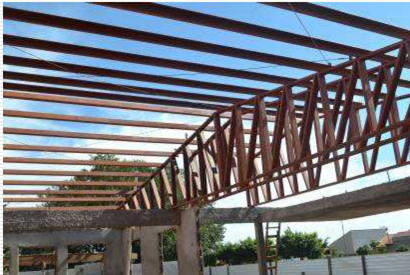
Detalhe da estrutura metálica de cobertura
