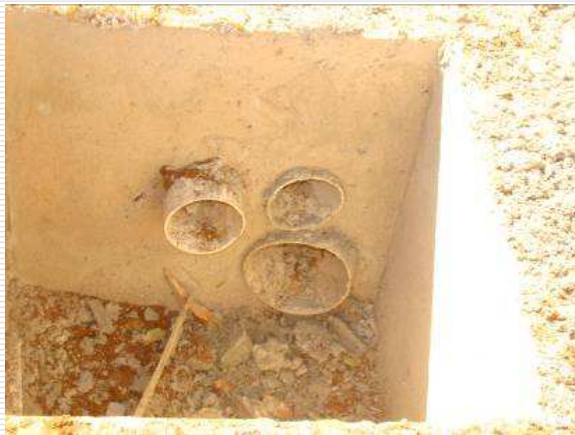
Instalações sanitárias - tubulação de esgoto
