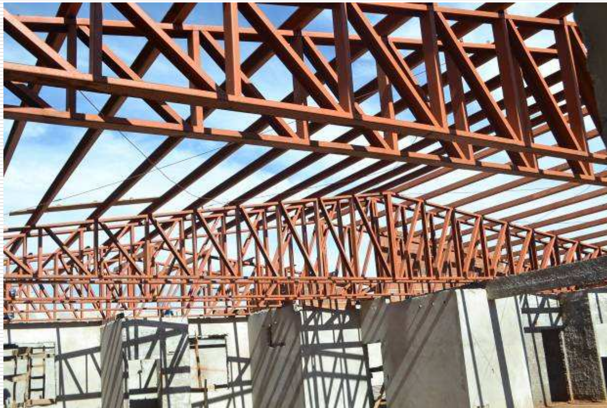
Estrutura metálica de cobertura
