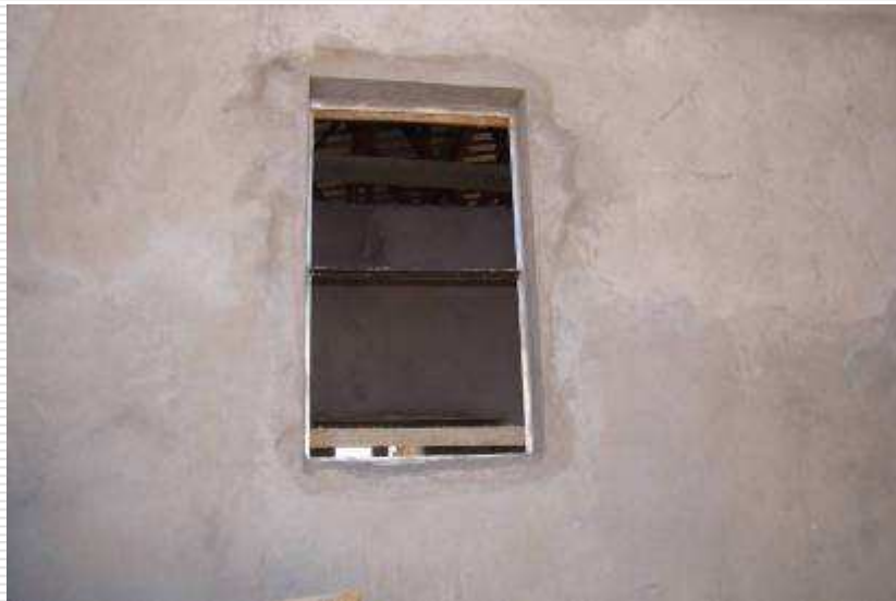
Detalhe de contramarco e batentes requadrados
