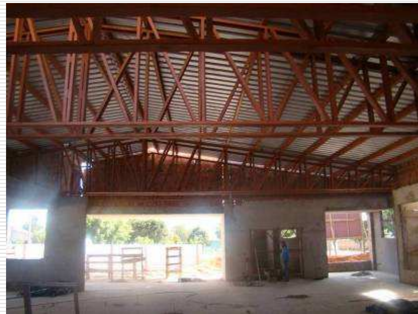
Vista interna do sistema de cobertura
