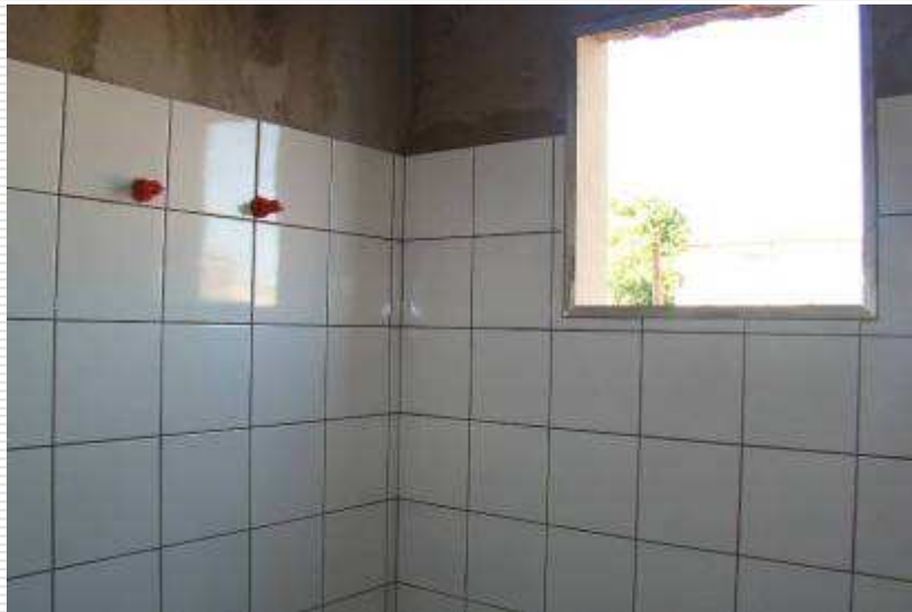
Detalhe do revestimento cerâmico aplicado
