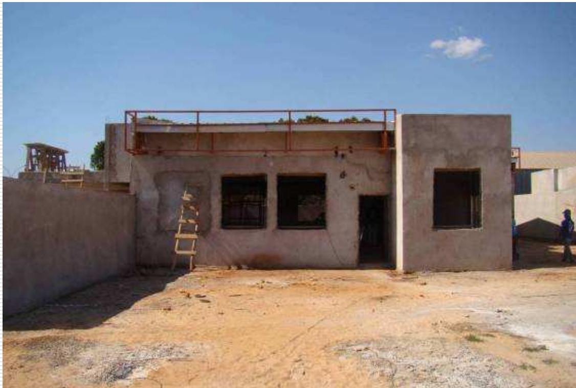
Vista da fachada lateral
