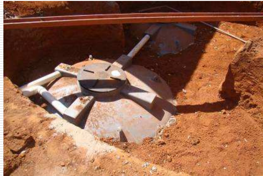
Detalhe da escavação e instalação das cisternas de água de chuva
