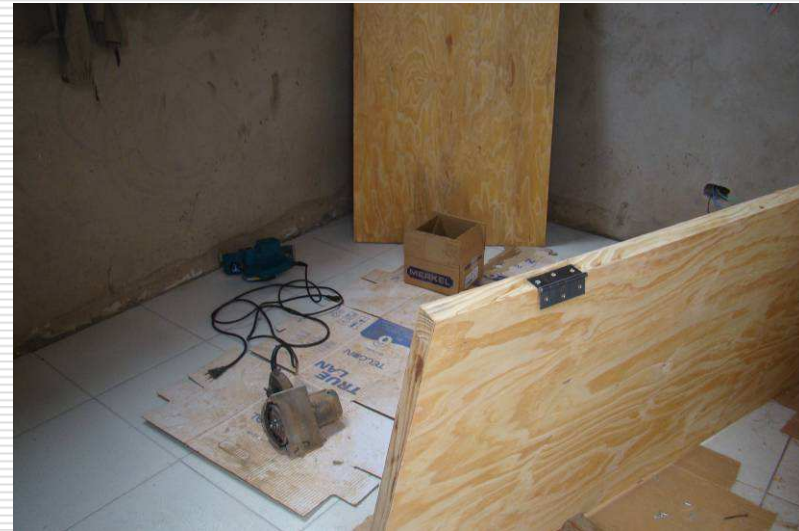
Detalhe da instalação das portas
