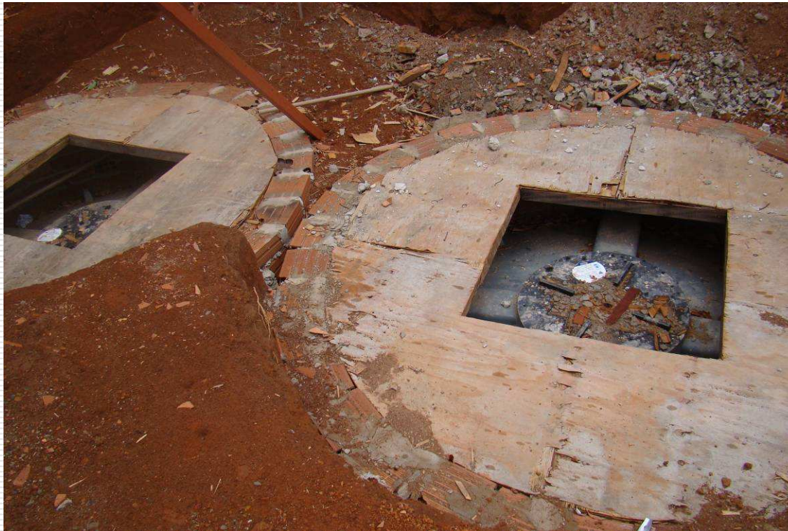
Detalhe da instalação das cisternas de água de chuva
