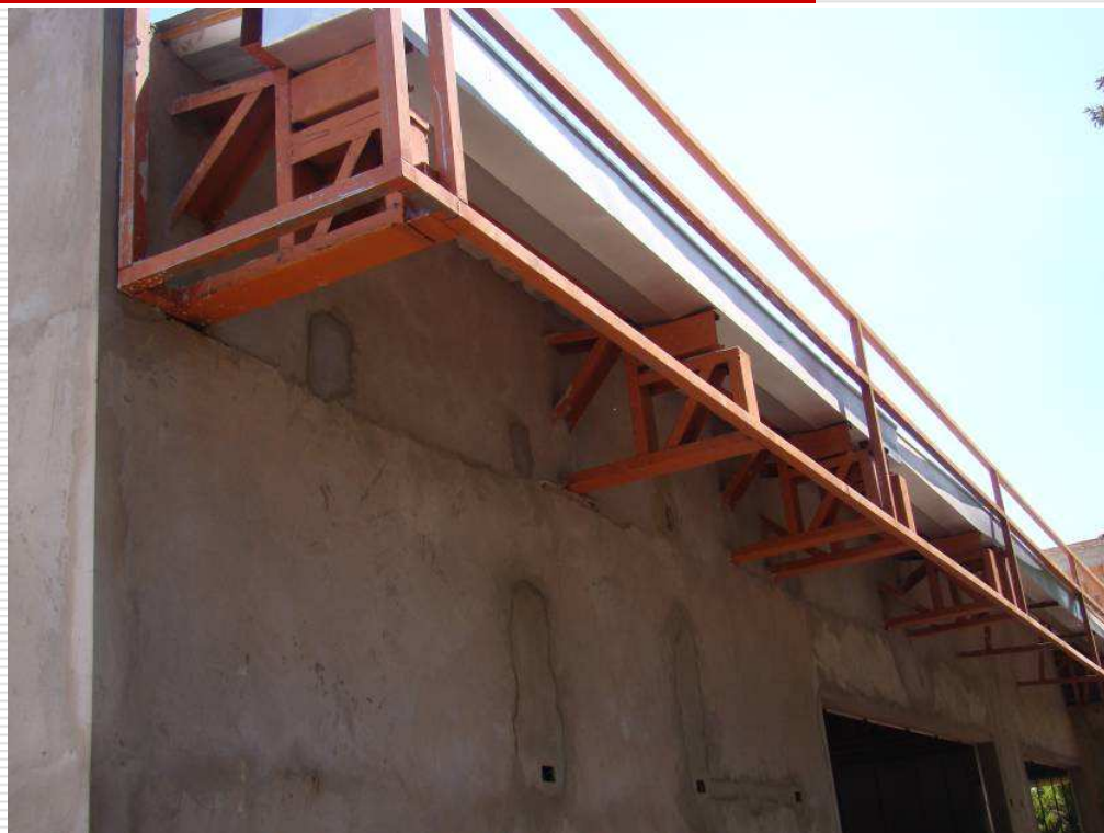
Detalhe da calha.
