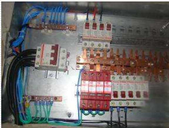
Detalhe dos quadros de iluminação, motores e tomadas de piso de lógica e elétrica
