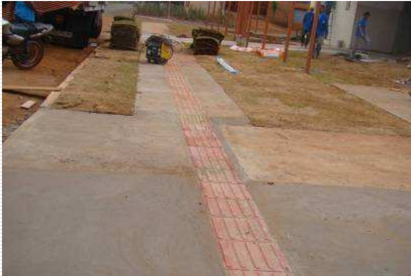
Detalhe do calçamento e da aplicação de textura acrílica nos muros
