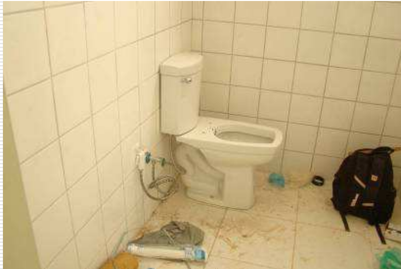
Detalhe do vaso sanitário com altura adaptada para os PNEs
