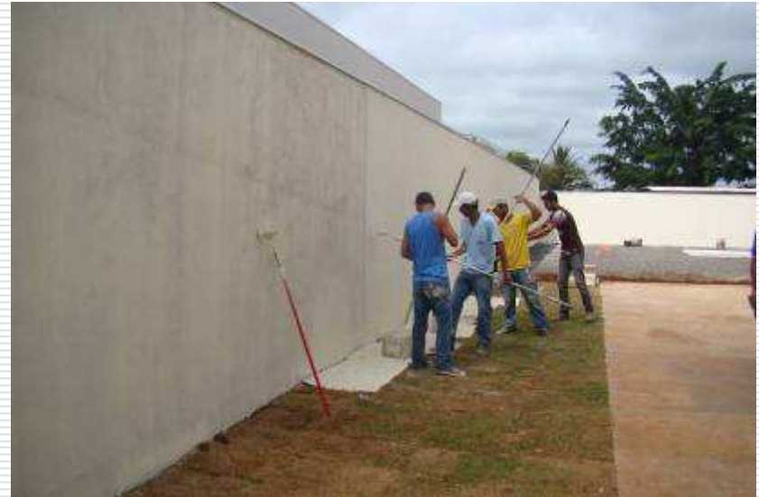
Detalhe do calçamento e da aplicação de textura acrílica nos muros
