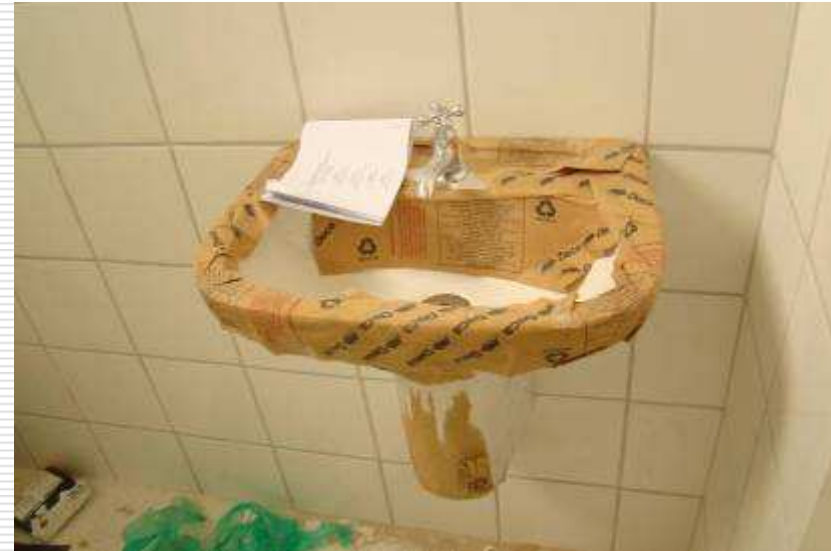
Detalhe da instalação das louças, modelo universal
