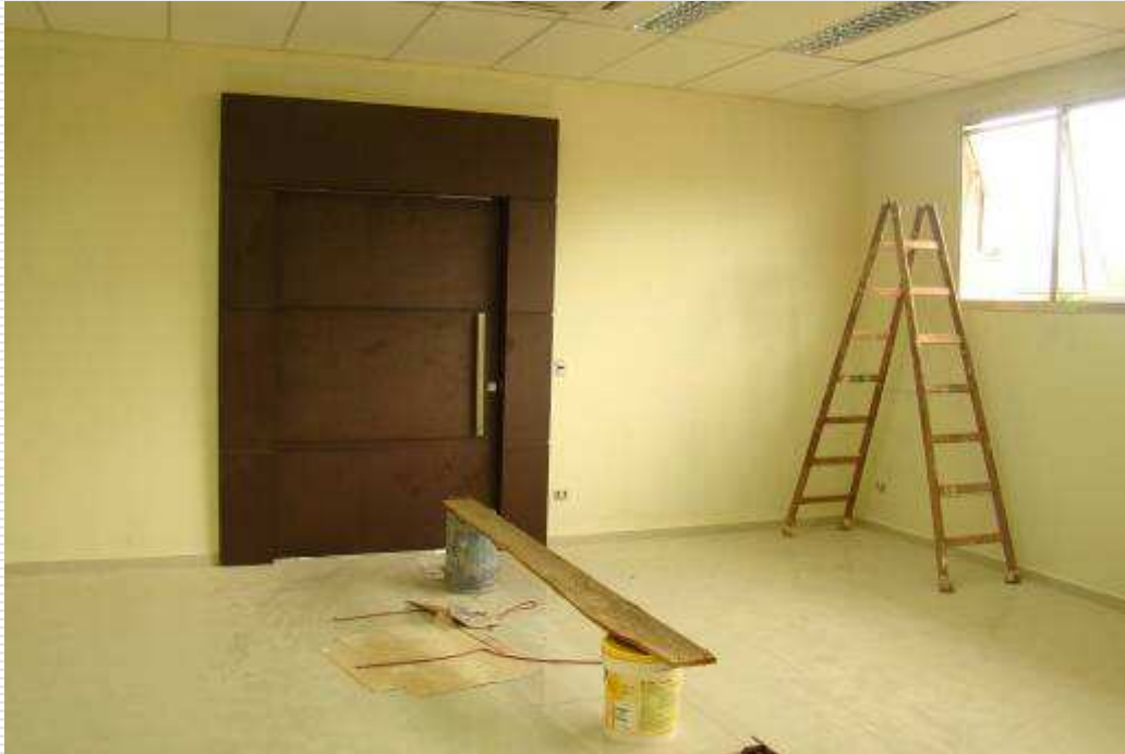
Detalhe da porta pivotante da sala de audiência e da pintura interna (palha).
