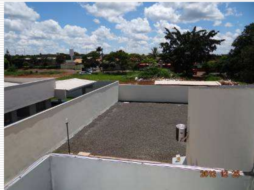
Vista posterior – lastro de brita
