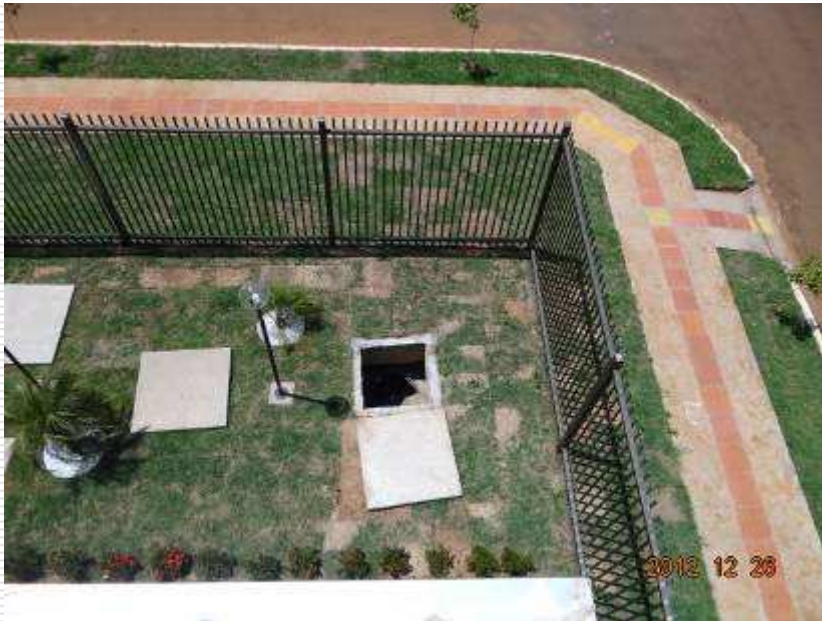
Detalhe de gradil e grama em placas
