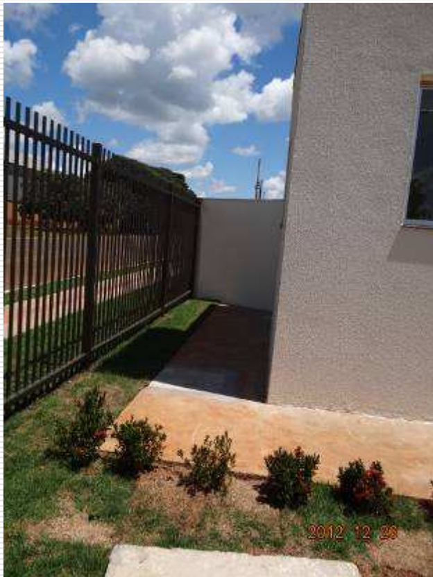
Vista lateral – grama, gradil e calçamento
