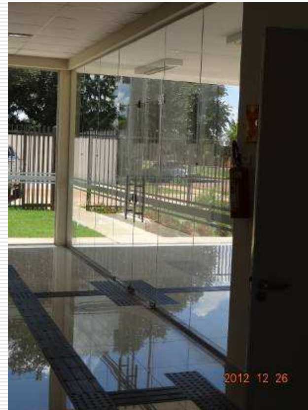
Vista interna – porta de acesso principal
