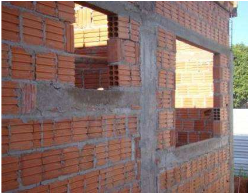
Vista de verga, contra-verga, pilares e viga-cinta concretados.
