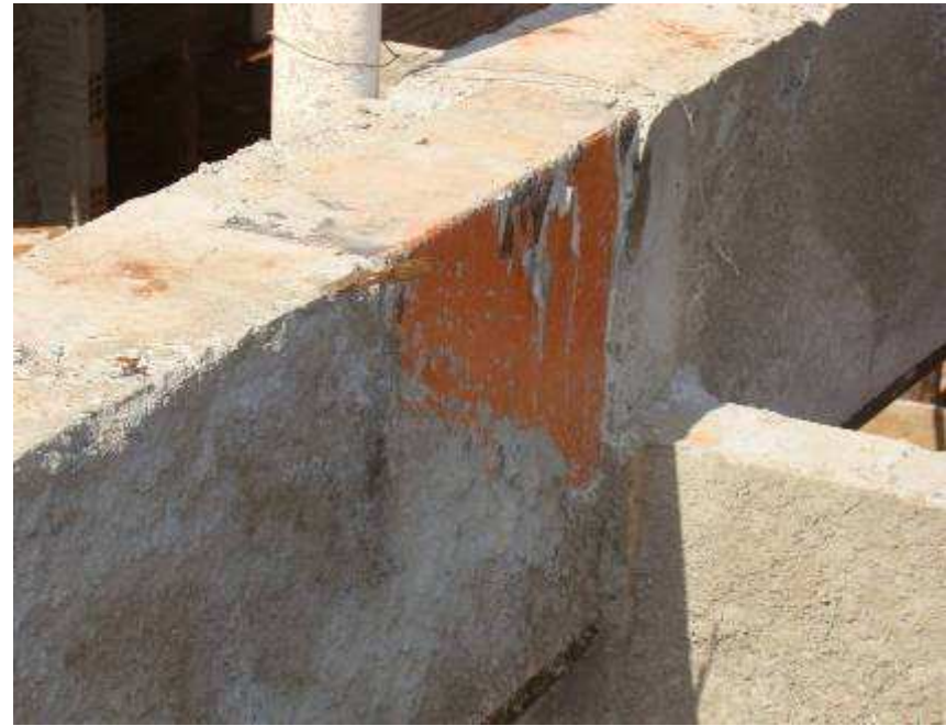
Detalhes do chumbador na viga e das formas e escoramento da laje maciça
