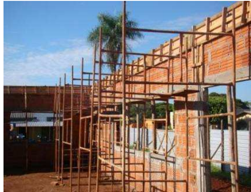
Vista de verga, contra-verga, pilares e viga-cinta concretados.
