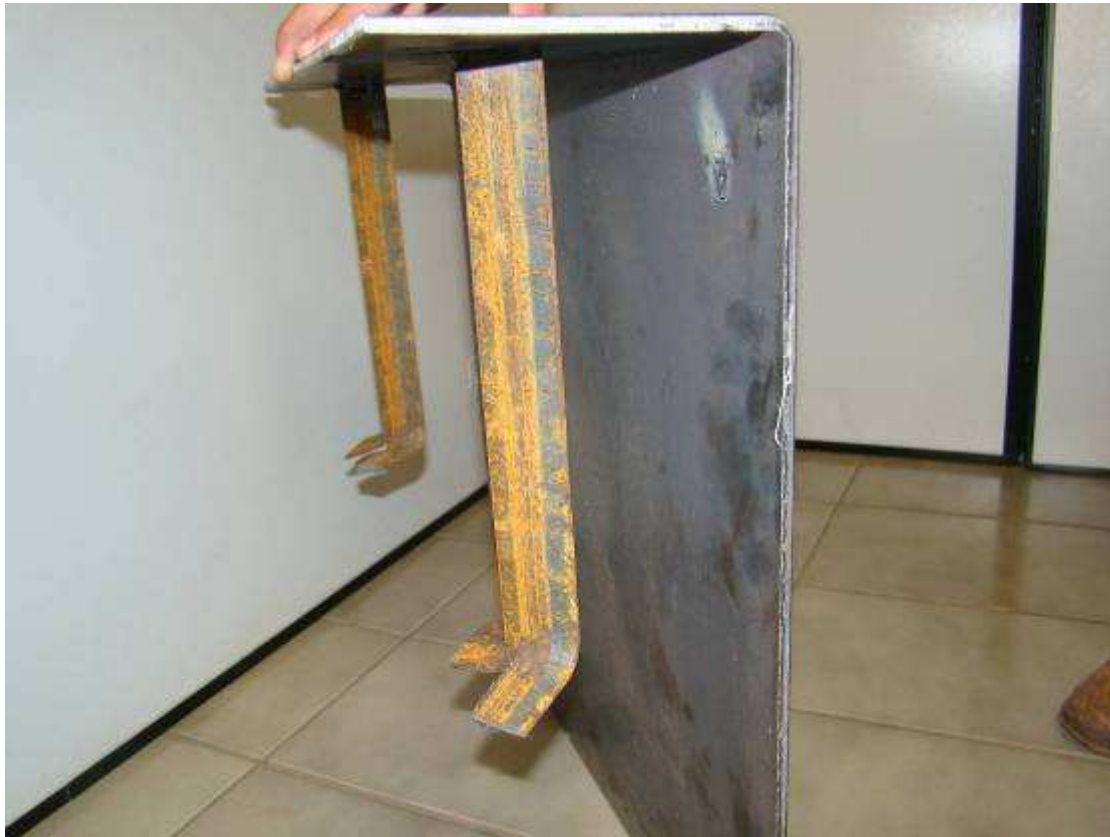
Detalhe do chumbador para as tesouras da cobertura
