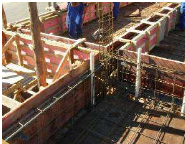
Detalhe das ferragens, tubulações de passagens, formas, lançamento e acabamento de concreto
