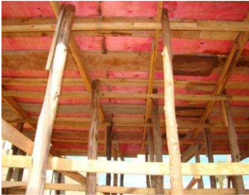
Detalhes do chumbador na viga e das formas e escoramento da laje maciça
