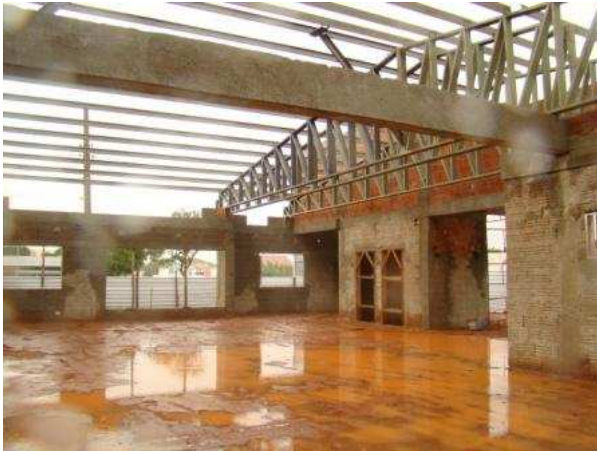
Estrutura de concreto, alvenaria e chapisco
