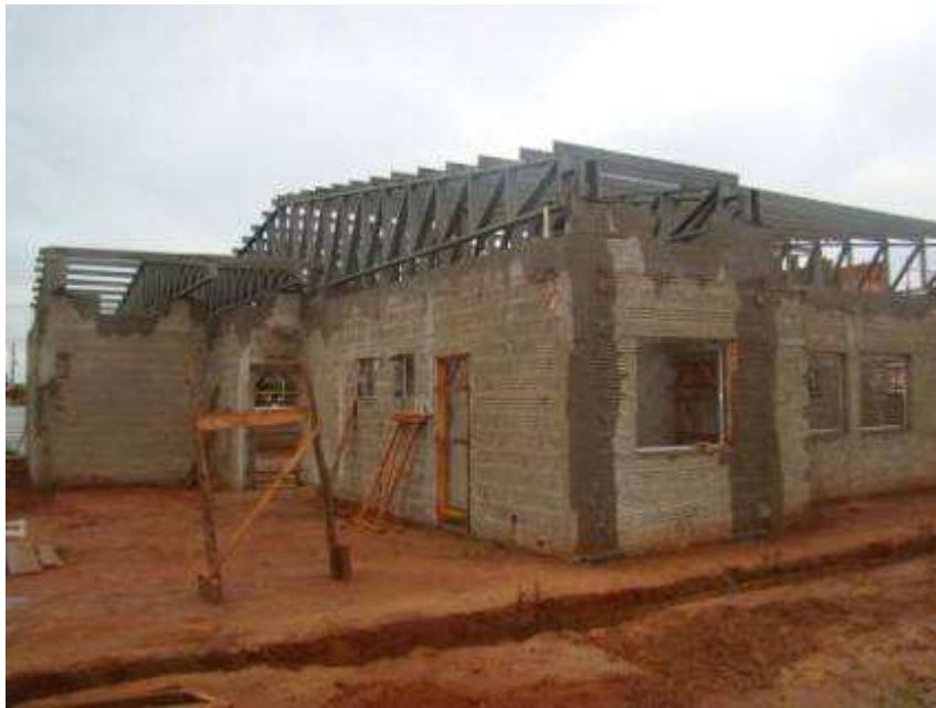
Detalhe da estrutura metálica
