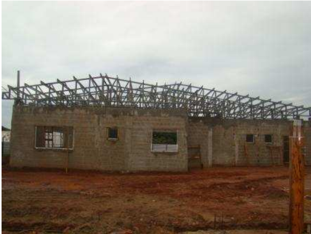
Detalhe da alvenaria, chapisco, estrutura metálica e "contra-marco" em janelas de alumínio
