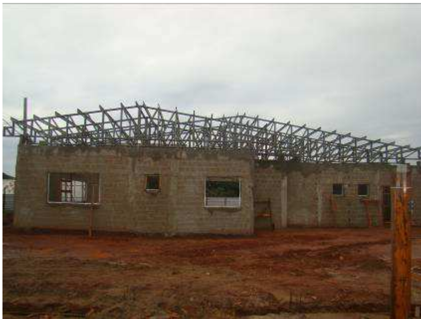
Estrutura metálica de cobertura
