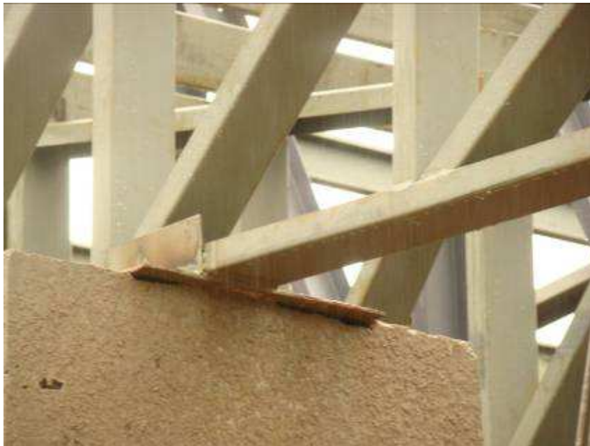
Detalhe da estrutura metálica da cobertura (tesouras, terças, contraventamento e chumbadores)
