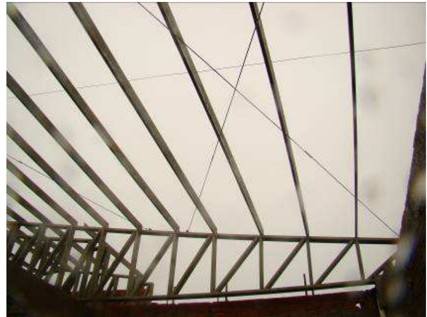
Detalhe da estrutura metálica da cobertura (tesouras, terças, contraventamento e chumbadores)
