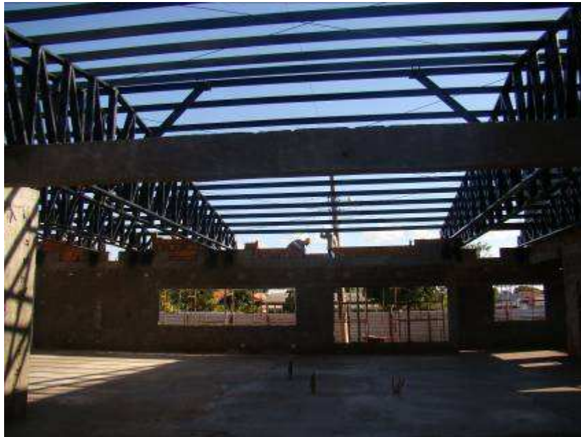
Detalhe do contrapiso regularizado e fechamento das platibandas ao fundo
