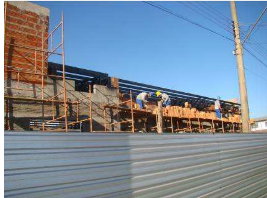
Vista da fachada lateral sendo vedada
