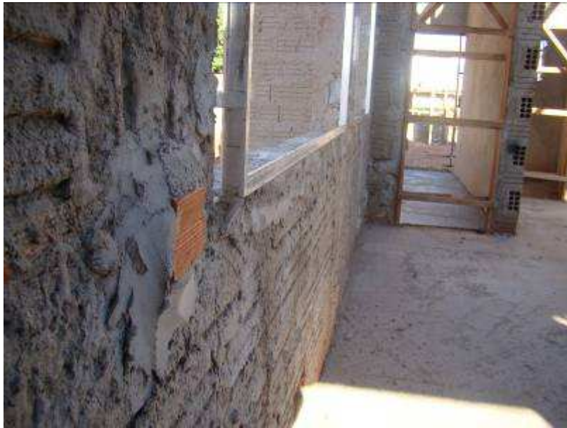
Detalhes dos contramarcos, batentes e das paredes taliscadas liberadas para o reboco
