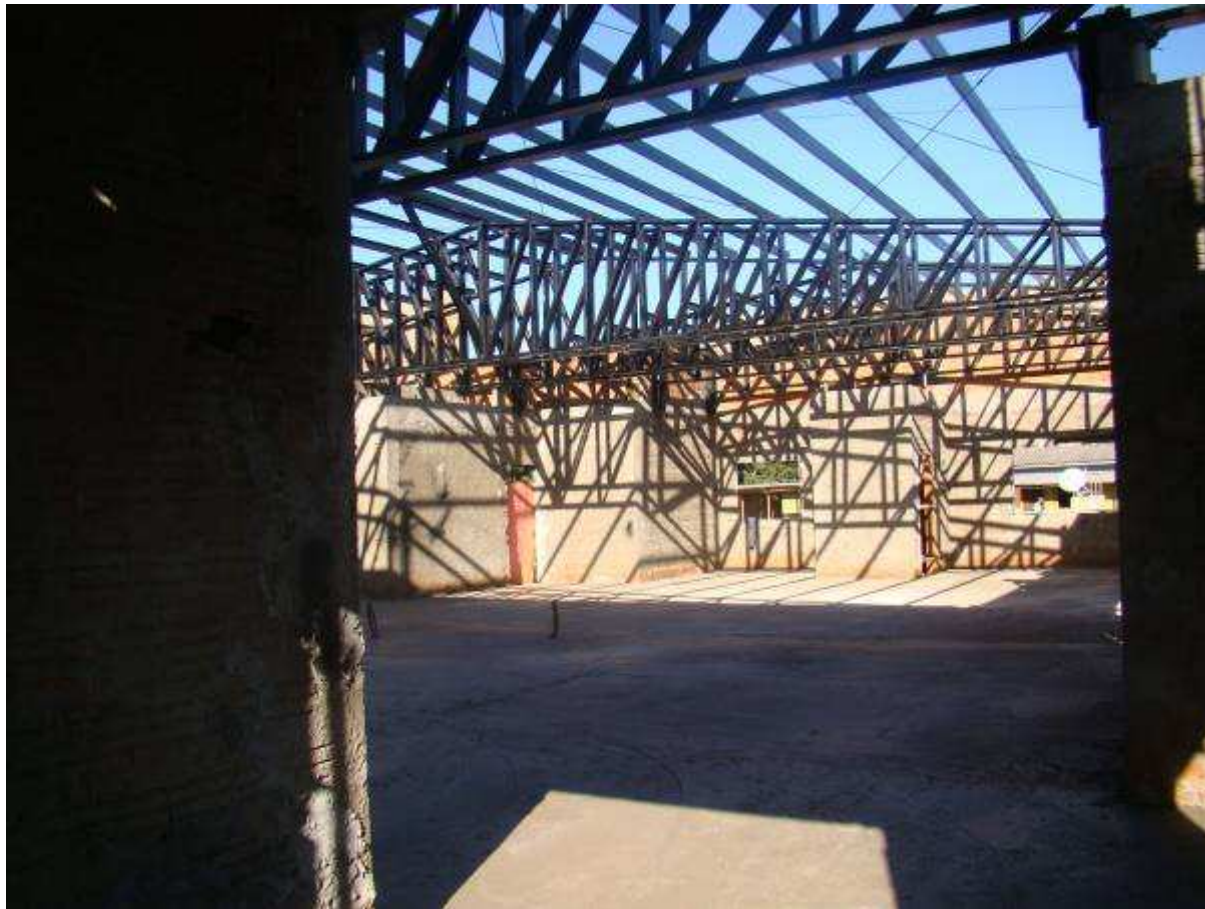
Vista interna da estrutura metálica concluída
