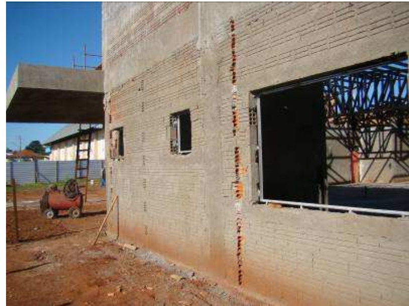
Detalhe dos cortes na alvenaria para a instalação das tubulações frigoríferas
