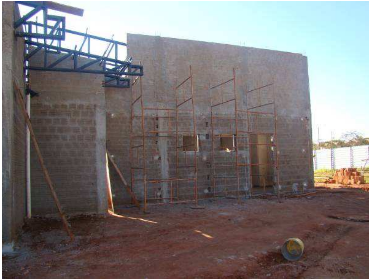
Detalhe das platibandas e dos oitões
