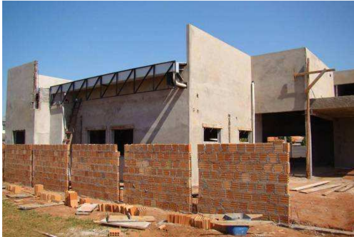
Vista da fachada lateral
