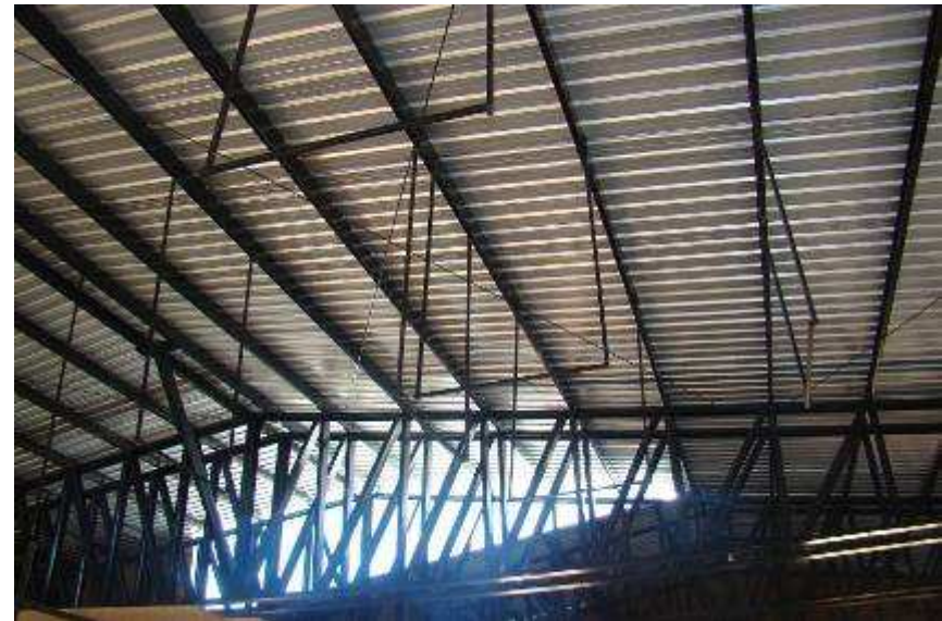
Vão entre tesouras, não previsto em projeto, aguardando autorização para fechamento
