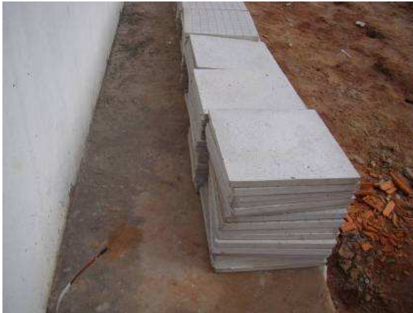
Detalhes do ladrilho hidráulico e do piso tátil depositado na obra.
