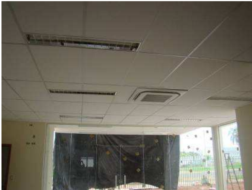
Detalhes do forro, climatização acabamento elétrico e de lógica (tomada de piso)
