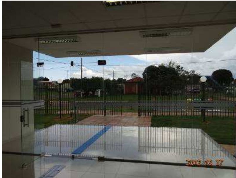
Vista interna – porta de acesso principal
