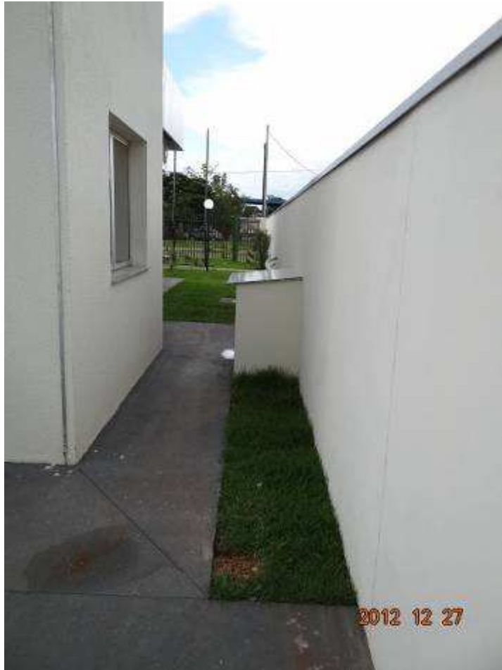
Vista lateral: chapim metálico
