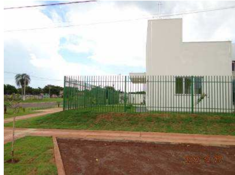
Vista externa – grama em placas e gradil metálico
