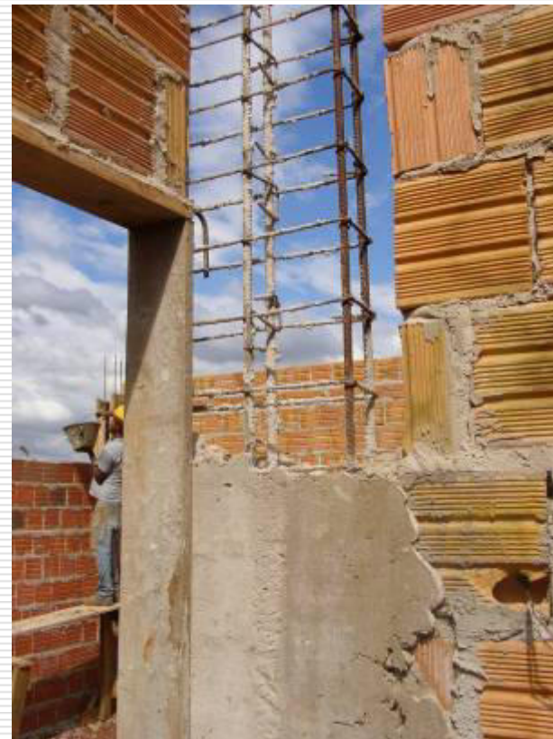
Detalhe da ferragem das vergas acima das portas
