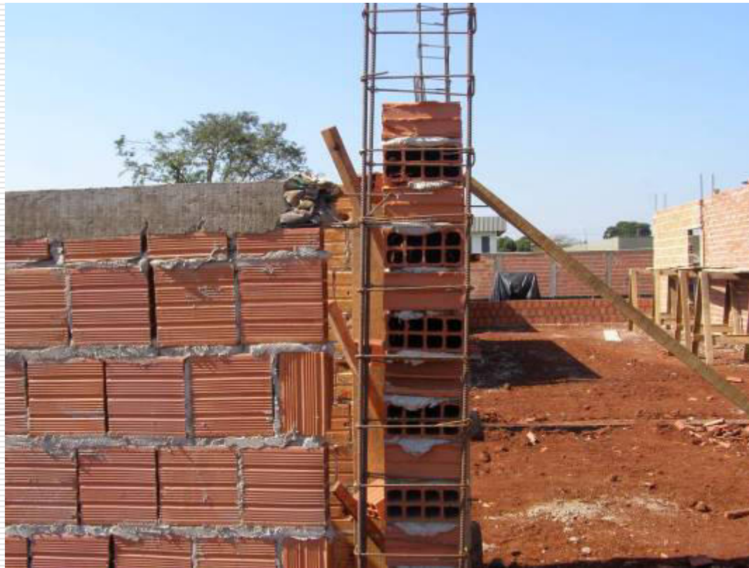
Detalhe da ferragem do pilar e alvenaria
