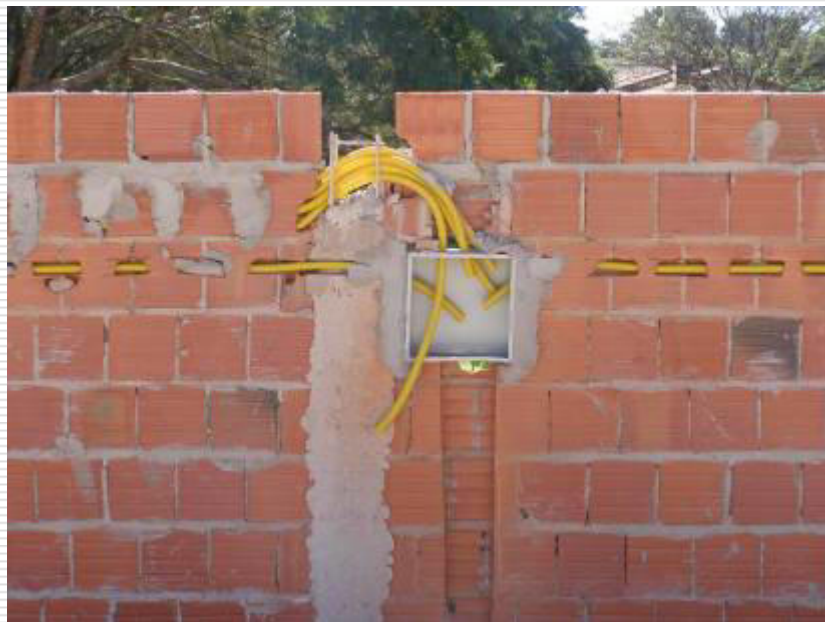
Caixa de passagem, rasgo em alvenaria e eletrodutos para instalação dos condicionadores de ar.
