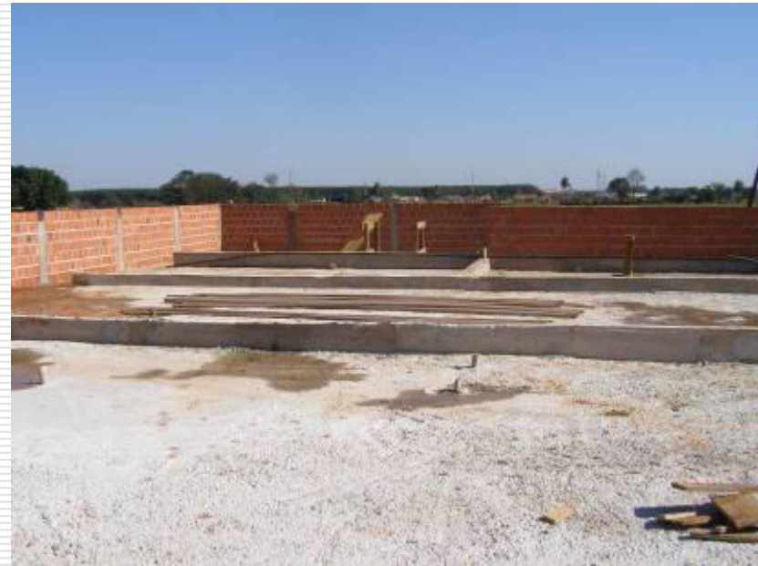
Detalhe da laje e vigas invertidas concretadas
