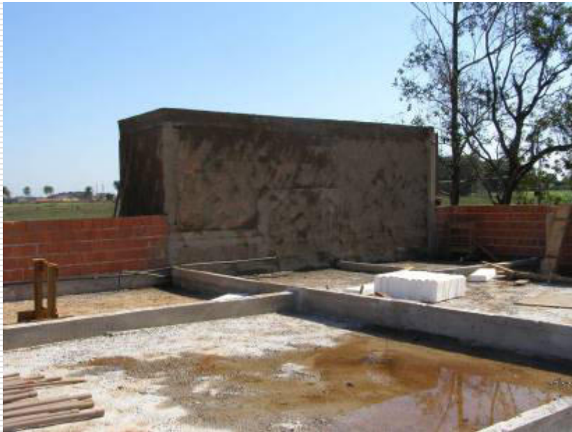
Elemento estrutural onde será instalada a caixa d'água e depósito de materiais
