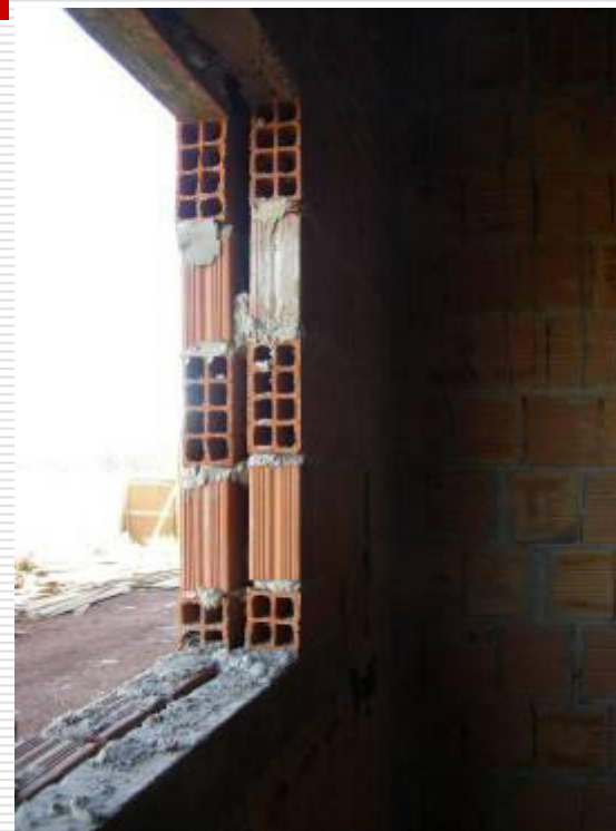
Alvenaria de vedação externa de 1 vez (paredes paralelas)
