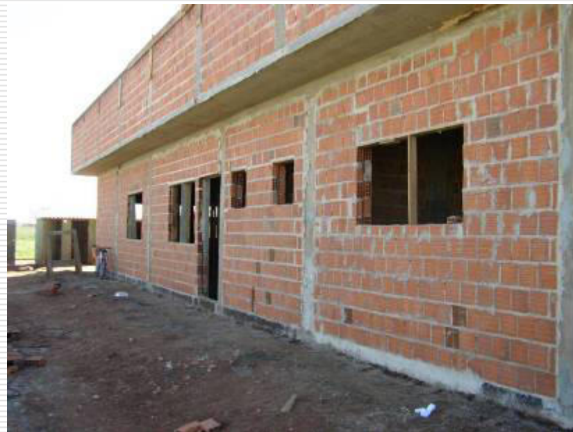
Detalhe da alvenaria de vedação externa de 1 vez (paredes paralelas)
