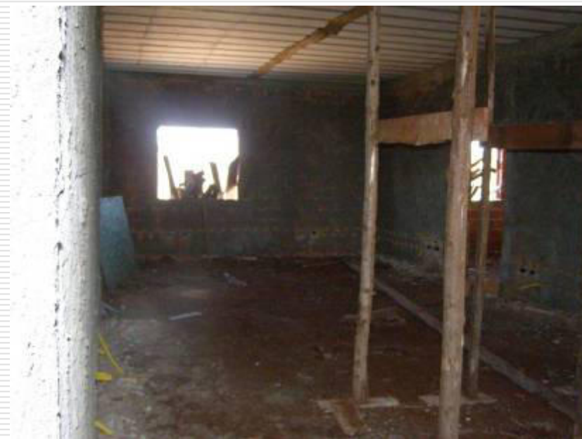
Detalhe da parte interna da secretaria
