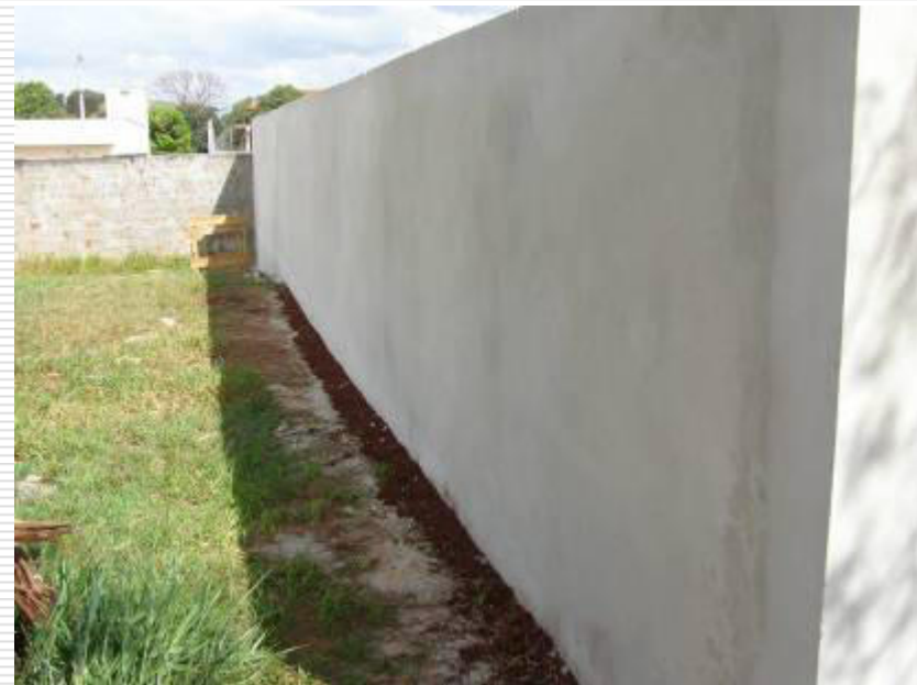
Detalhe dos muros laterais já rebocados interna e externamente
