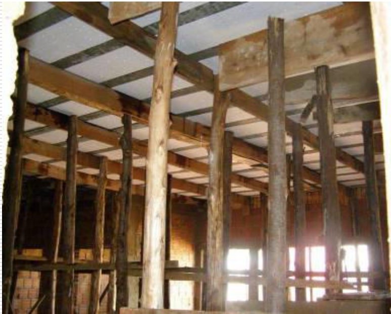
Detalhe dos escoramentos de sustentação da laje até findar o tempo de cura do concreto usinado (28 dias)
