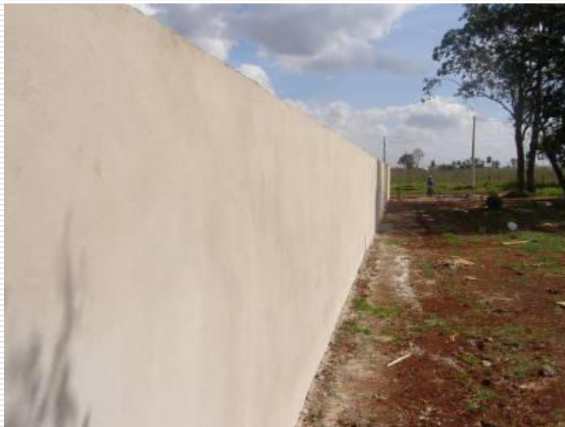
Detalhe dos muros laterais já rebocados interna e externamente
