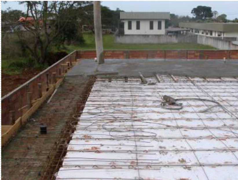
Concretagem da laje com utilização de vibrador elétrico
