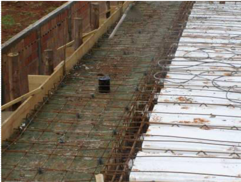
Detalhe da ferragem negativa do beiral e da caixa octogonal de aço estampado para ponto de luz
