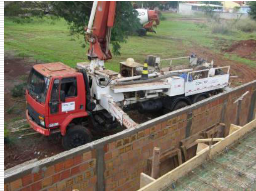
Caminhão bomba utilizado para lançar o concreto usinado (fck 25 MPA) sobre a laje
