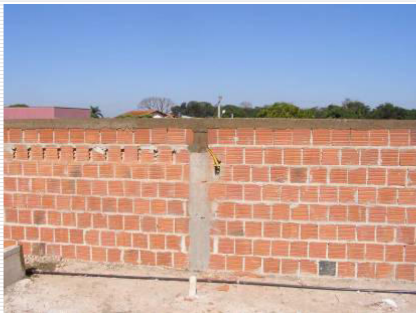
Detalhe da caixa de tomada de aço galvanizado na platibanda, onde será instalado o ar condicionado
