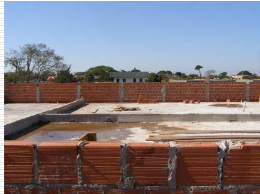
Detalhe da platibanda (muro de alvenaria construído para esconder o telhado)
