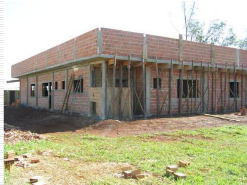
Vista geral da obra
