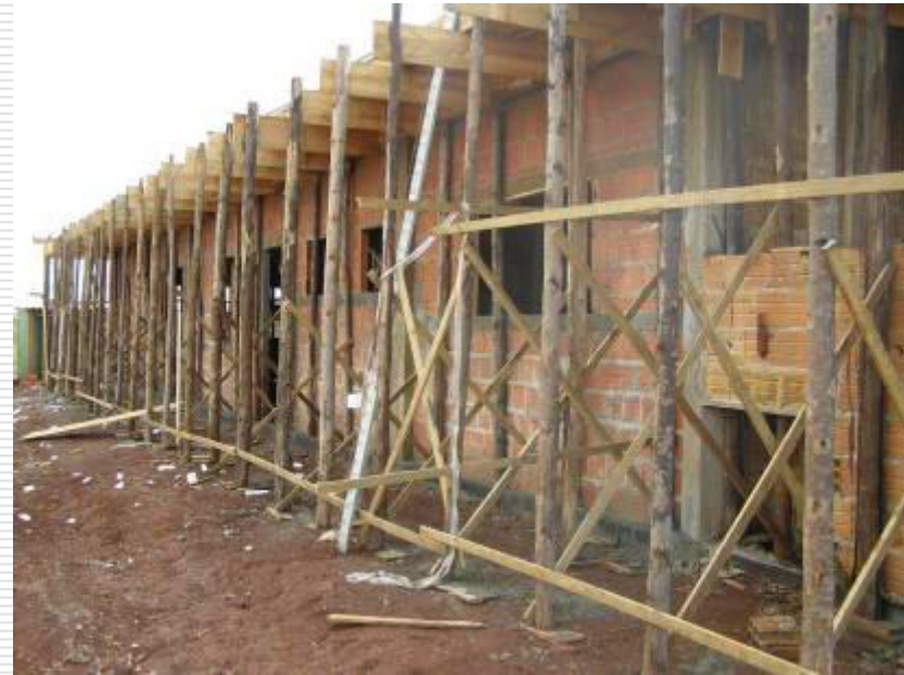
Escoramento da laje do beiral
