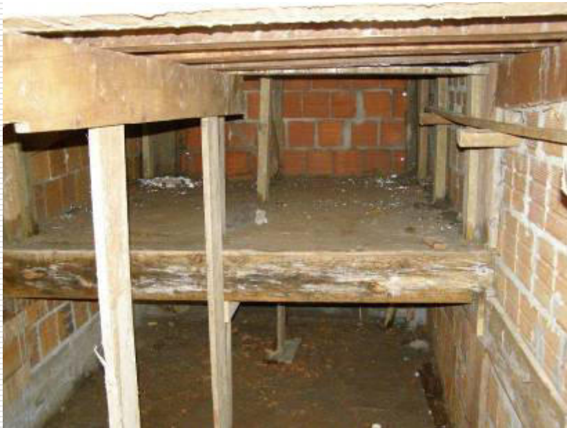
Detalhe da laje onde será apoiada a caixa d'água
